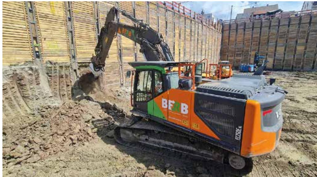
**Präzise:** Beim Anlegen eines „Berliner Verbau“ in Leonberg setzte das Abbruch- und Erdbauunternehmen BERB eine Kemroc-Doppelkopffräse KRD 120 am firmeneigenen 26 t-Bagger ein. (Foto: Kemroc)
