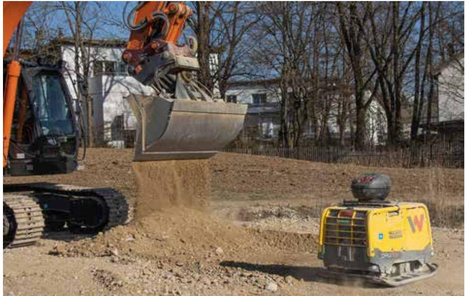
**Cobot im Einsatz:** Die kollaborierende Rüttelplatte verdichtet auf Basis des digitalen Geländemodells das vom Bagger erzeugte Planum autonom bis zu einem vorgegebenen Verdichtungsgrad. (Foto: TUM)
