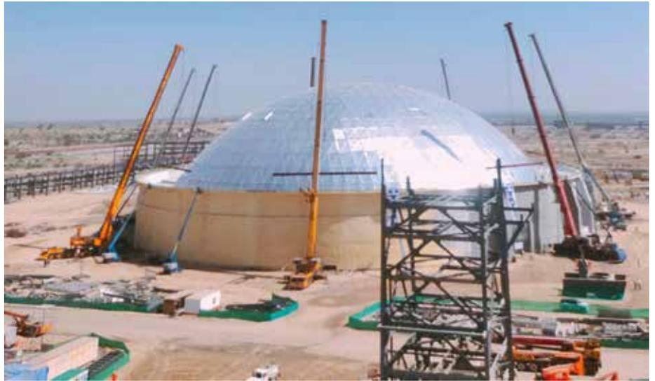
**Großprojekt:** Acht Tadano-Krane haben im indischen in Rajasthan eine 250 t schwere Koks-Kuppel mit einem Durchmesser von 126 m angehoben. (Fotos: Tadano)
