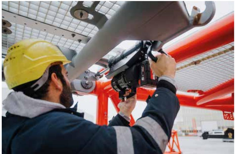
**Zeit- und Kosteneinsparung:** Der Akku-Bolzenziehzyylinder beschleunigt das Einrichten von Baustellen ersetzt schwere Diesel-Aggregate. (Foto: Liebherr)
