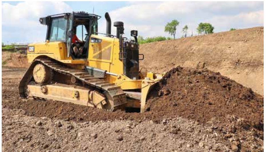
Der D6XE ist der weltweit erste Dozer, bei dem ein Deltalaufwerk mit hochgesetztem Turas mit einem starken Elektromotor angetrieben wird. (Fotos: Zeppelin/Maaßen/Andreas Cichowski)
