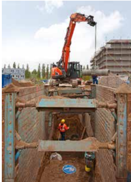
Der 24-Tonnen Raupenbagger wurde eigens für das Bauprojekt mit einem hydraulischen Schnellwechselsystem und Rohrgreifer ausgestattet. (Fotos: HKL Baumaschinen)
