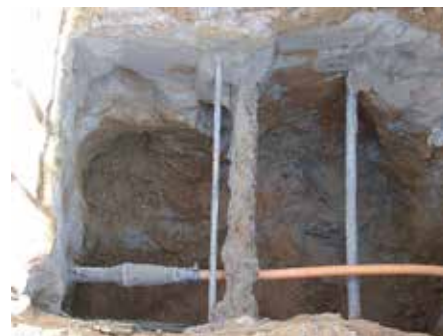
Durch die Sicherheit , keine Leitungen oder Rohre versehentlich zu beschädigen, geht die Arbeit viel schneller von der Hand.
