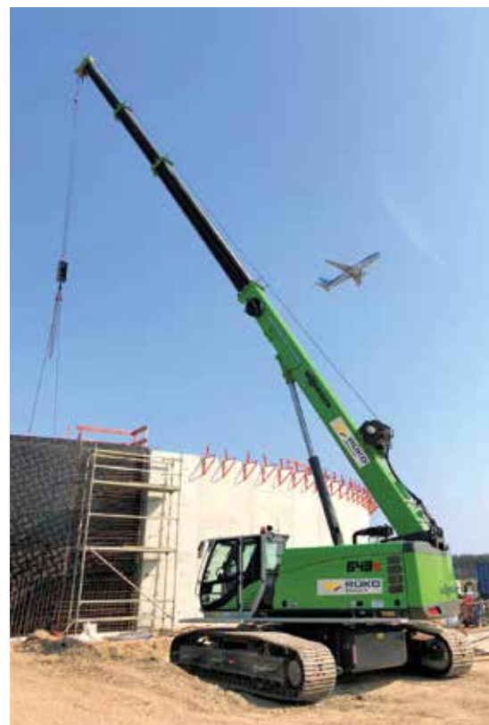
Der Raupen-Teleskopkran wurde am Frankfurter Flughafen überwiegend für den Hub bei Schal-, Bewehrungs- und Betonagearbeiten für das neue Speicherbecken eingesetzt. (Foto: Rüko)
