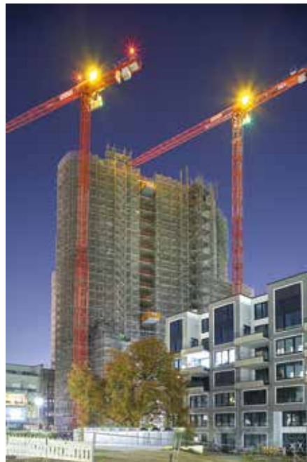
Zwei freistehende Krane errichten den Rhein 740 Tower im linksrheinischen Düsseldorfer Stadtteil Heerdt. (Fotos: Florian Sander)
