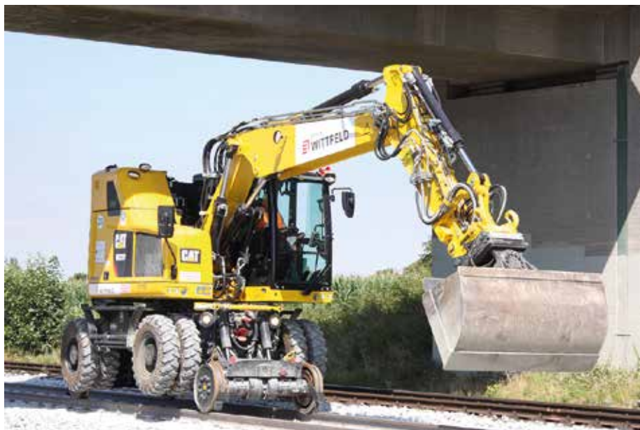
Zwischen Wilhelmshaven und Oldenburg wird die zweigleisige Bahnstrecke fit gemacht für schwere Containerzüge. Der neue Zweiwegebagger soll das Schotterplanum einbauen. (Fotos: Caterpillar/Zeppelin)
