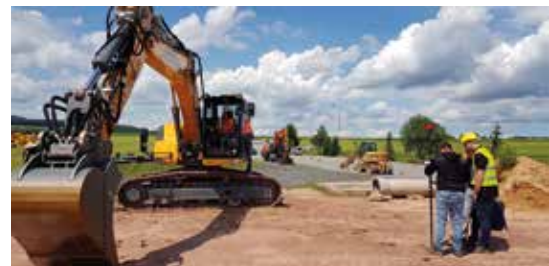
Zur Verfügung stehen auch 2-D- und 3-D-gesteuerte Bagger sowie GPS-Rover zur Vermessung.
