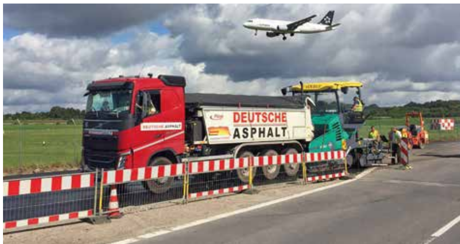
Mit dem ASW Asphaltprofi Thermo wird Asphalt heiß und homogen angeliefert, sodass er in optimaler Konsistenz verbaut werden kann. (Fotos: Fliegl)
