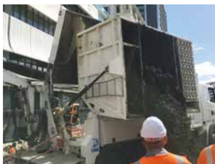
Das seitliche Abkippen erhöht die Effizienz der Maschinen. (Fotos: RSP)
