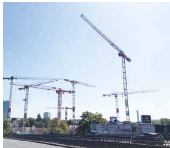
Zu den interessantesten Baustellen mit BBL-Kranen im laufenden Jahr gehört der neue Kanzlerplatz in Bonn mit acht Kränen,
