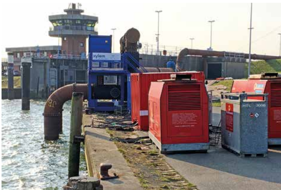
Überall dort , wo große Wassermengen bewegt werden müssen, kommen Mietpumpen zum Einsatz. Hier eine Umpump-Maßnahme für die Sanierung eines Sperrwerks. (Fotos: Xylem)
