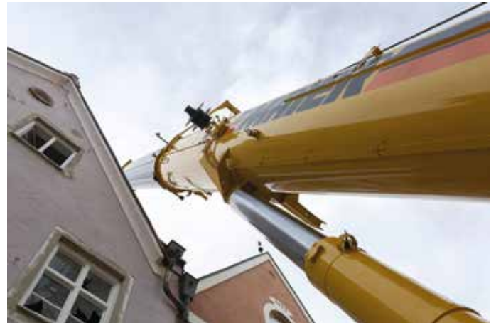
Diffizil: Um die Last in 40 Meter Ausladung zu erreichen, musste der Teleskopmast sogar zwischen Hausgiebeln manövriert werden.
