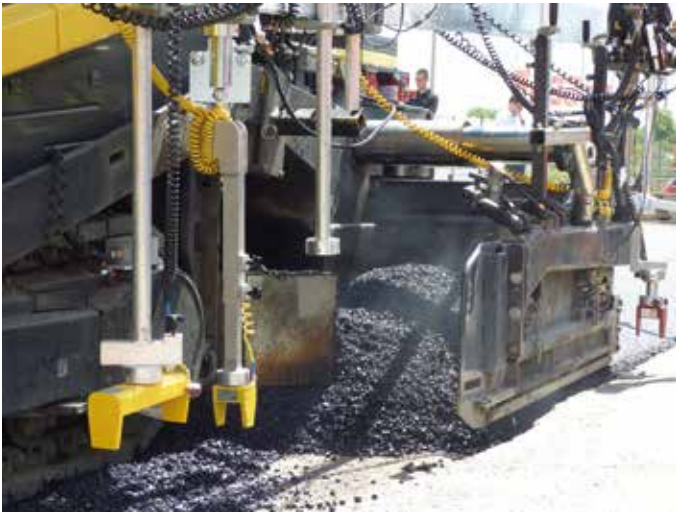
Eine Schwierigkeit bei der Ermittlung der exakten eingebauten Asphaltmenge ist die Bestimmung der noch nicht verbrauchten Restmenge.
