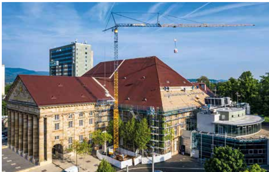
Bei der Sanierung des großflächigen Daches an der historischen Stadthalle in Kassel kam der neue Liebherr 81K.1 zum Einsatz. Hier waren eine beachtliche Hakenhöhe und maximale Ausladung gefordert. (Foto: Wedekind Baumaschinen)
