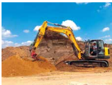
Bei den Erdarbeiten spielt der bewährte 15-Tonnen-Bagger seine Stärken voll aus.
