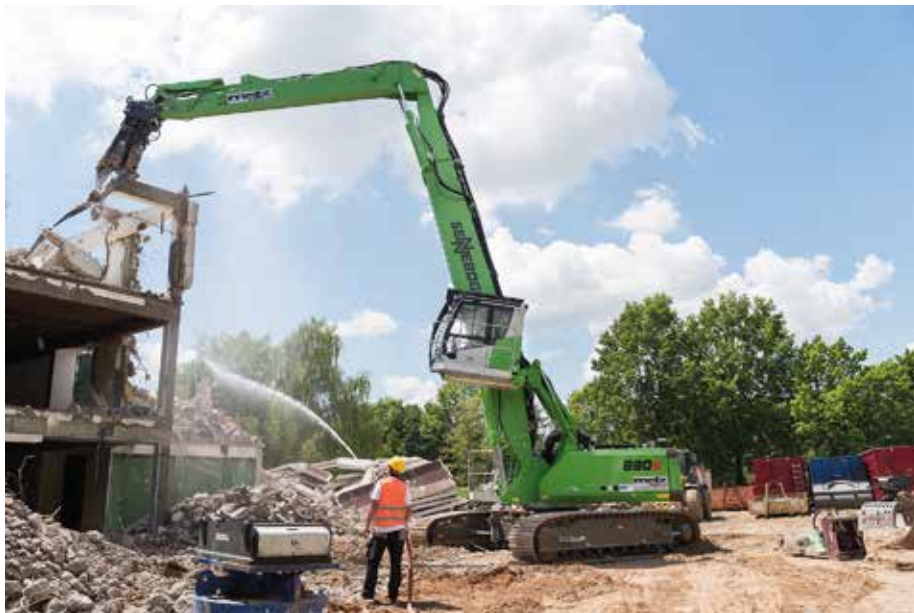
Ob Abbruchgreifer , Schaufel oder Schere – der 830 Abbruch besticht durch Flexibilität und ist mit 19 Meter Reichhöhe und, 3,5 Tonnen Traglast ein starker Begleiter. (Fotos: Sennebogen)
