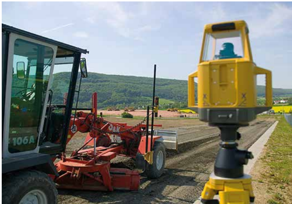
Praktische Übungen mit der Lasersteuerung am Grader. (Fotos: AFZ Walldorf)
