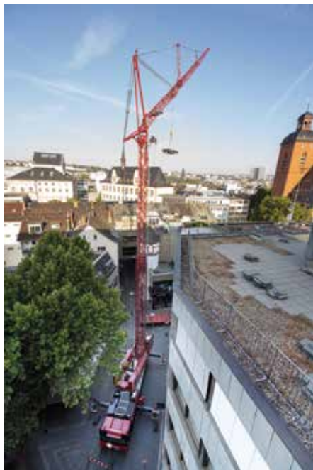
Raumwunder MK 88: In der verwinkelten Innenstadt von Mainz begnügt sich der Mobilbaukran mit wenig Platz zum Stellen und Aufbauen. (Fotos: Liebherr)
