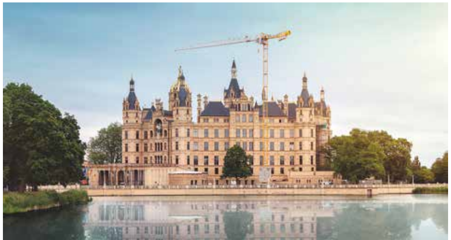
Die wertvolle Engelsfigur auf dem goldenen Dach des Schweriner Schlosses durfte bei der Sanierung auf keinen Fall beschädigt werden. Um Höhe zu gewinnen, wurde der Kran auf einem Betontisch aufgebaut. (Foto: Siloco/Jörn Braasch)
