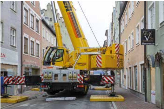
Passage dank VarioBase: Für Fußgänger wird eine Schneise freigehalten – die rechten Kranabstützungen sind rund 75 Prozent ausgefahren.
