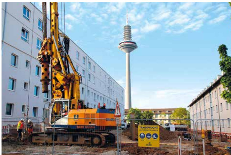
Zusammen mit einem Arge-Partner führt Bauer Spezialtiefbau Nachverdichtungsarbeiten in der Frankfurter Platensiedlung aus. (Foto: Bauer Group)
