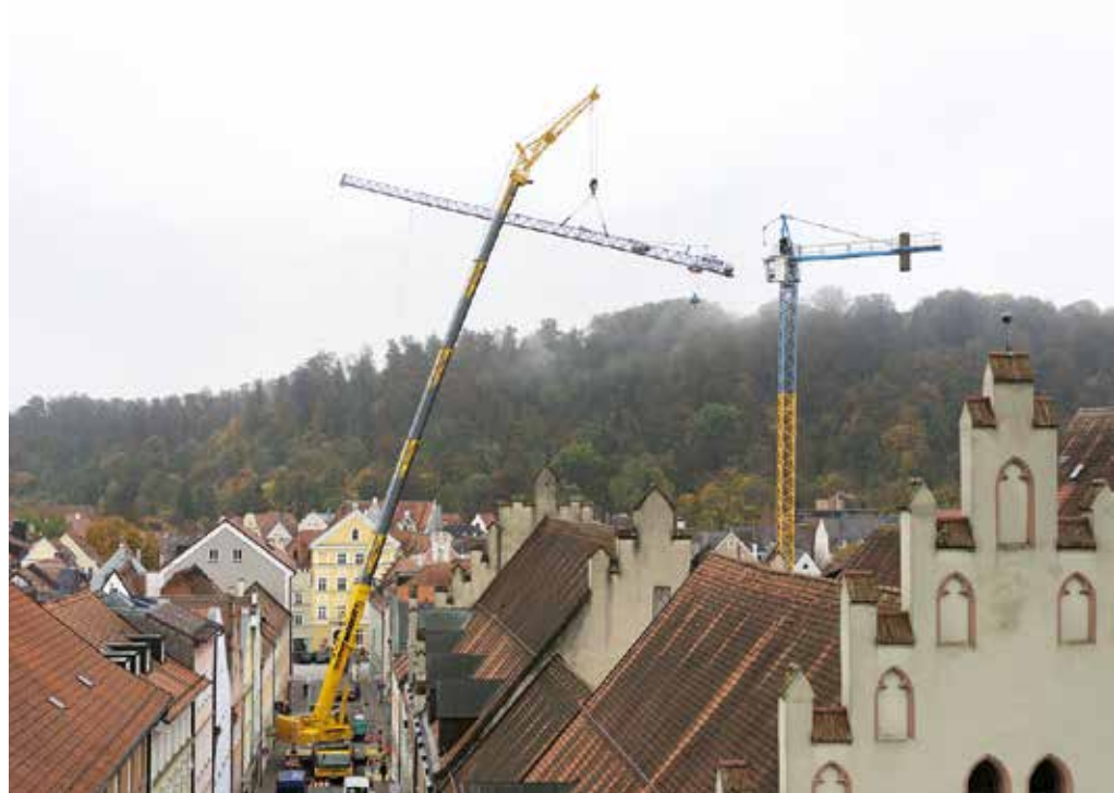
Schwerstes Teil: Sieben Tonnen Bruttolast hängen mit dem Hauptausleger des Baukrans am Haken des LTM 1250-5.1. (Fotos: Liebherr)
