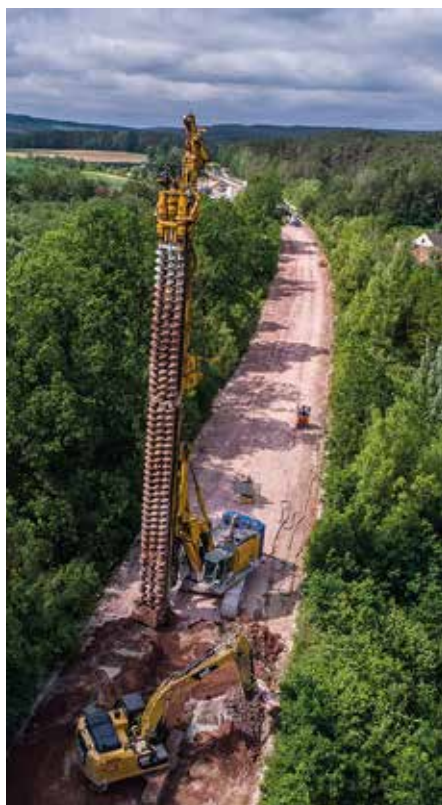
Die DB Netz AG beauftragte das Spezialunternehmen mit der Sanierung von insgesamt drei Bahndämmen. (Bauer Gruppe)
