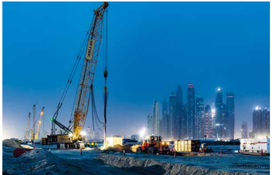
Vor der Skyline Dubais entsteht am Persischen Golf ein neuer Hafen. Das Unternehmen Keller setzt für die Tiefenverdichtung einen HS 8130 mit Rüttellanze ein. (Foto: Liebherr)
