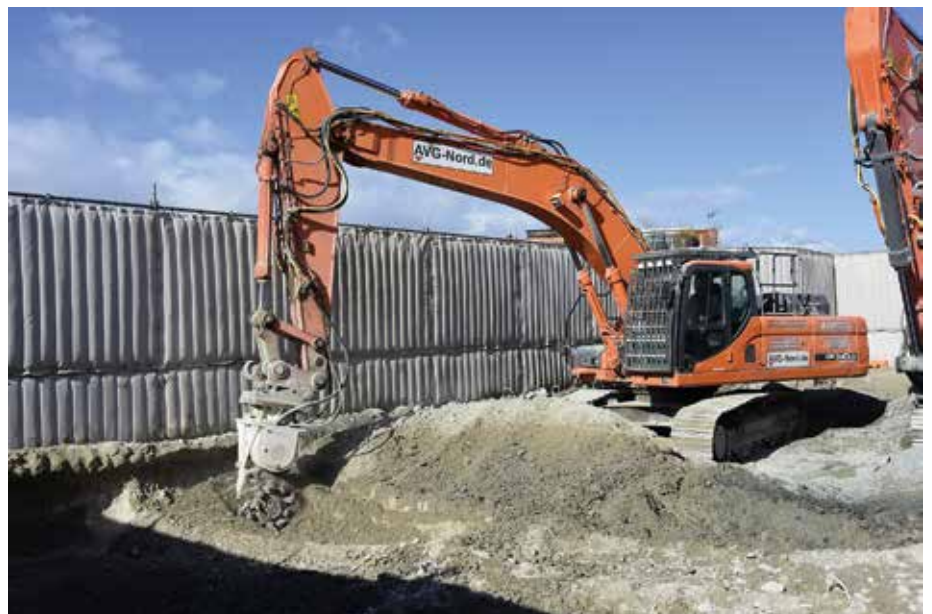
Von oben nach unten: Die Maschinen wurden zu Projektbeginn von einem schweren Mobilkran auf die Bunkerdecke gesetzt. (Fotos: Erkat)
