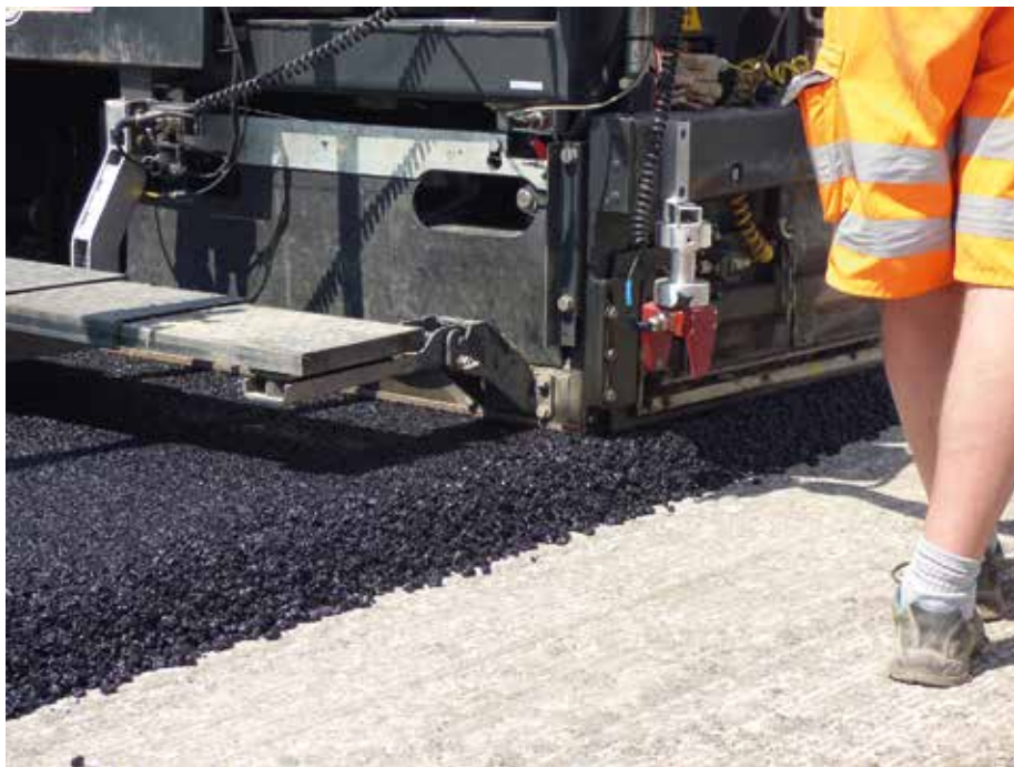
Die frei schwimmende Bohle – bei der Erfassung exakter und belastbarer Messdaten eine echte Herausforderung.
