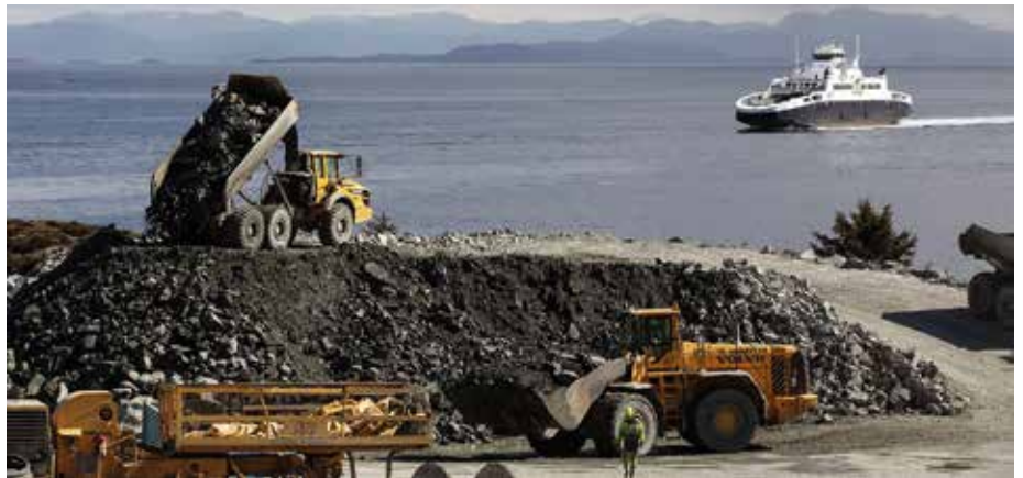
Dieses wegweisende Projekt entlang der norwegischen Küste soll die Reisezeit halbieen. Zahlreiche Maschinen aus der breiten Volvo-Palette sind an dieser Baustelle beteiligt.
