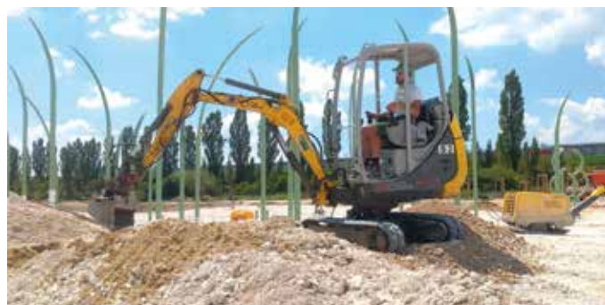
Für die filigraneren Aushubarbeiten im späteren Wasserpark ist ein 1,7-Tonnen-Bagger im Einsatz.
