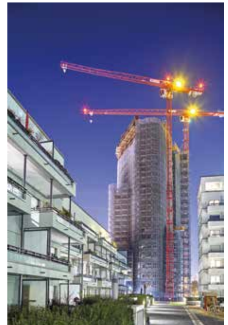
Dank eines ökonomischen Aufbaukonzepts stehen die beiden Krane nur rund 47 Meter voneinander entfernt und können exakt untereinander durchschwenken.
