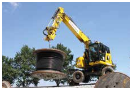
Auch Kabelzieharbeiten sind von dem Bagger zu übernehmen.
