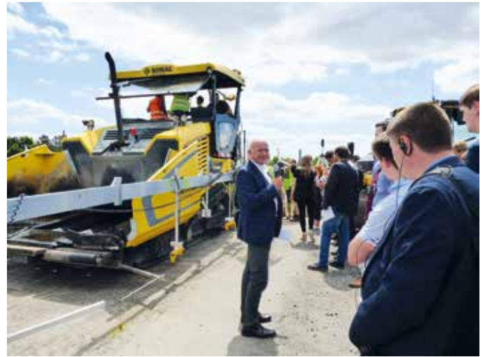
Zahlreiche Interessenten verfolgten den Demonstrationseinbau auf dem Testgelände der Moba mit den Erläuterungen der Forschungspartner.
