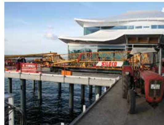
Am Timmendorfer Strand – direkt über der Ostsee – sollte am Ende der 150 m langen Seebrücke ein „Teehaus“ gebaut werden. Wegen der geringen Tragkraft der Brücke wurde der Kran in Einzelteilen zum Einsatz transportiert. (Foto: Siloco)
