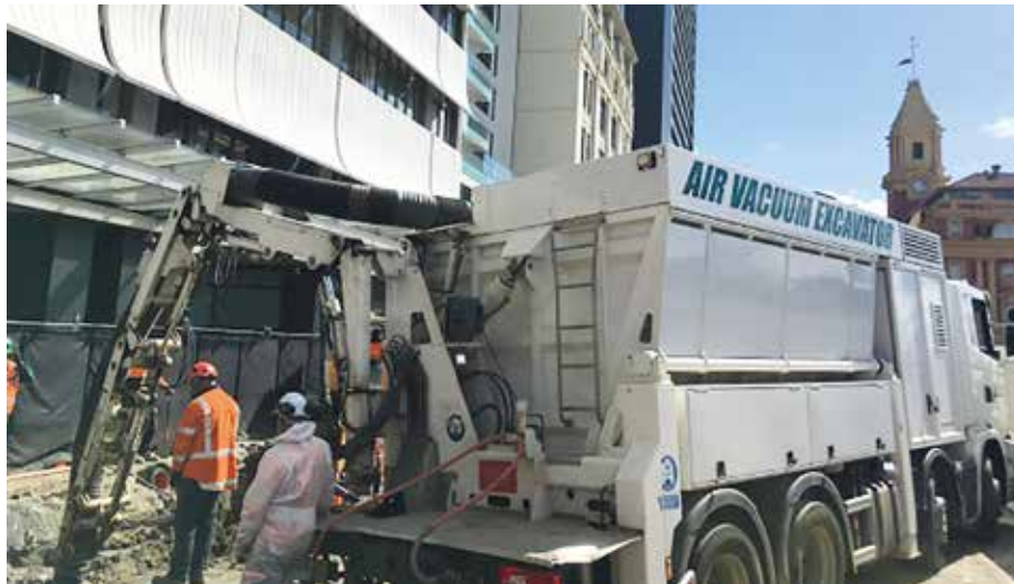
Die Bediener schätzen den zielgenauen Einsatz des hydraulisch geführten Saugrüssels und die enorme Saugleistung.
