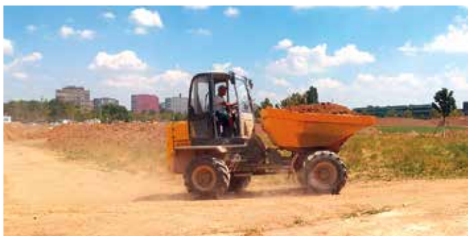
Mit den Raddumpfern mit sechs und neun Tonnen Nutzlast ist der Transport großer Mengen an Erdmaterial selbst auf den schmalen Wegen kein Problem.
