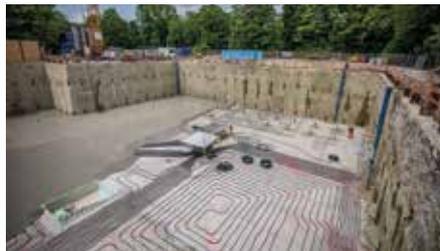
**Anspruchsvoll:** Rund 3.000 m<sup>2</sup> Mixed-in-Place-Wand und eine 2.500 m<sup>2</sup> große Bodenplatte wurden geothermisch aktiviert. Dabei wurden mehr als 5 km Rohrleitungen auf der Baugrubensohle verlegt.
