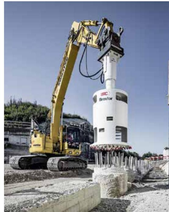
**Verkürzte Bearbeitungszeit:** in Pfahl mit 1 m Durchmesser und 1 m Abbauhöhe kann mit dem Brextor innerhalb von einer Stunde bearbeitet werden. (Foto: BRC Engineering AG)
