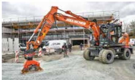
**Vielseitig:** Dank Tiltrotator und Oil-Quick-Wechsler ist jedes Anbaugerät schnell und präzise im Einsatz. (Foto: Dieter Göllner)
