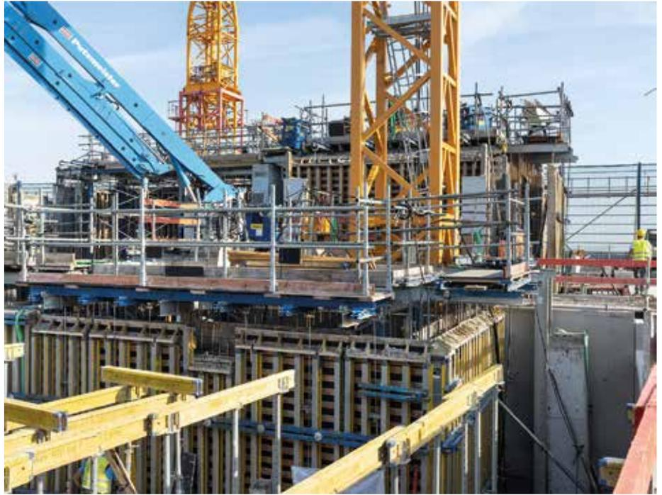
**Hybridlösung:** Der Stahlbetonkern des Hochhauses wurde aus Ort beton und Fertigteilen hergestellt.
