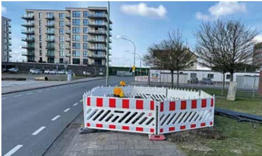
**Negativbeispiel:** Muss ein Gehweg voll gesperrt werden und ist die Anlage eines Notweges nicht möglich, so ist die Einrichtung von Überquerungshilfen (z.B. Fußgängerüberweg) zu prüfen und gegebenenfalls anzuordnen. Fußgänger sind allein mit Zusatzzeichen 1000-12 bzw. -22 am Absperrschrankengitter auf den gegenüberliegenden Gehweg zu weisen (s. auch RSA21 - Teil B: Innerörtliche Straßen Nr. 2.4.5). (Foto: Holger Lehn)
