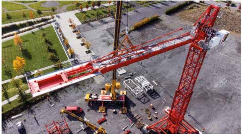
**Ausleger am Haken:** Der Tadano All-Terrain-Kran AC 7.450-1 mit 59,80 m Ausleger und 100 t Gegengewicht bewältigt die Hübe zum Aufbau des Wolff Baukrans 8076 problemlos. (Fotos: Tadano)
