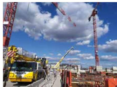
AMCS Technologies hat mit dem DCS 61-S/M eine Antikollisionslösung von Turmdreh- zu Mobilkran entwickelt. (Foto: AMCS Technologies)
