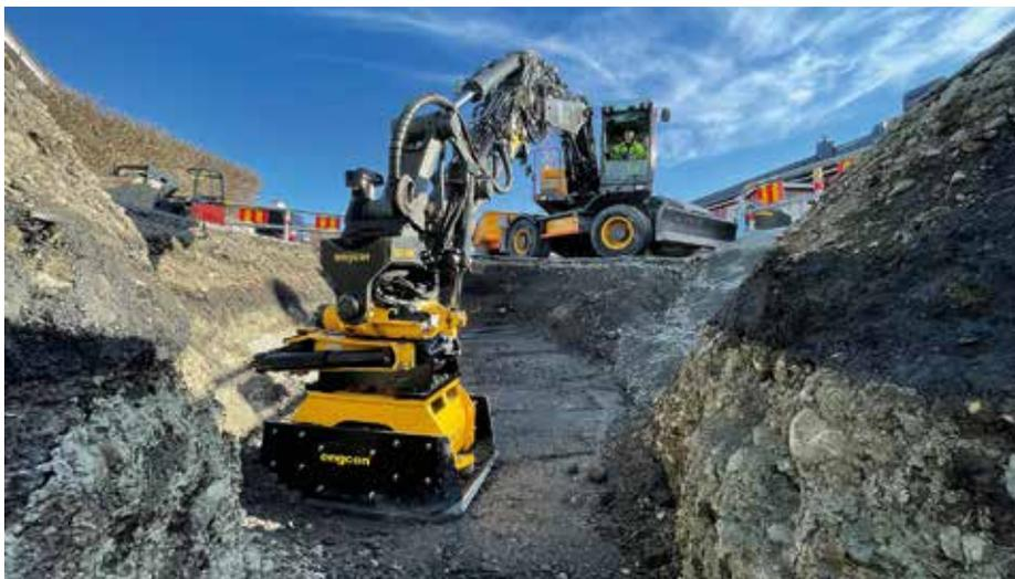
Engcon zeigt den Anbauverdichter PC6000 für Bagger von 12 bis 26 t. (Foto: Engcon)
