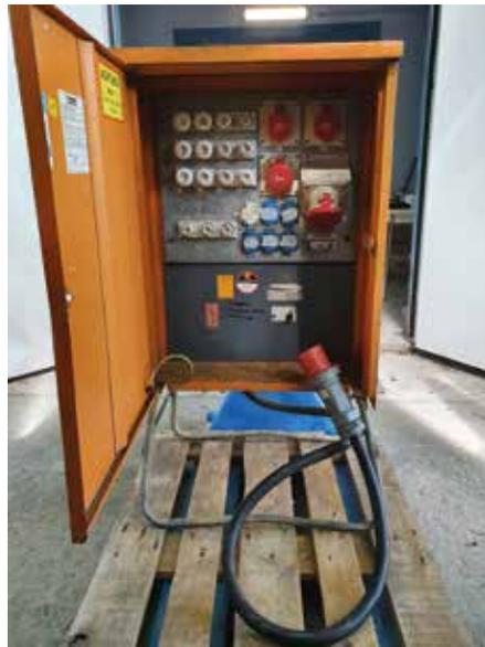
**Abb. 1:** Einen alten Baustromverteiler ohne Hauptschalter nachrüsten mit einer kurzen Leitung und einem Stecker ist nun nicht mehr zulässig. (Fotos: Michael Lochthofen)
