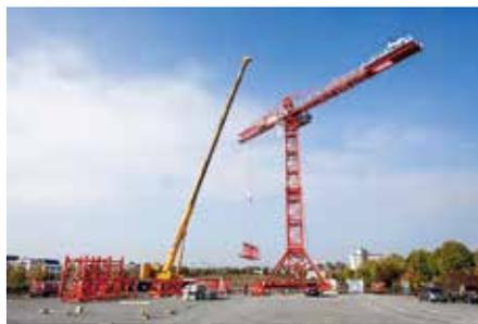
**Kurzer Prozess:** Innerhalb von nur einer Stunde hatten zwei Monteure den Aufbau des AC 7.450-1 abgeschlossen. Schon konnte der Aufbau des Prototyps beginnen.
