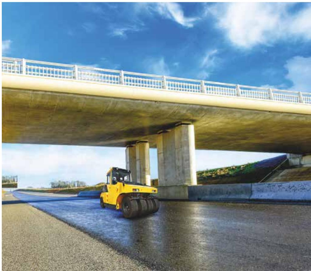
**Cleverer Lösung:** BKT hat mit PAC Master und PAC Master Plus Reifen für Walzen entwickelt, die die Wärme ableiten, die bei der Aufbringung des Straßenbelags während der Aufbringung entsteht. (Foto: BKT)
