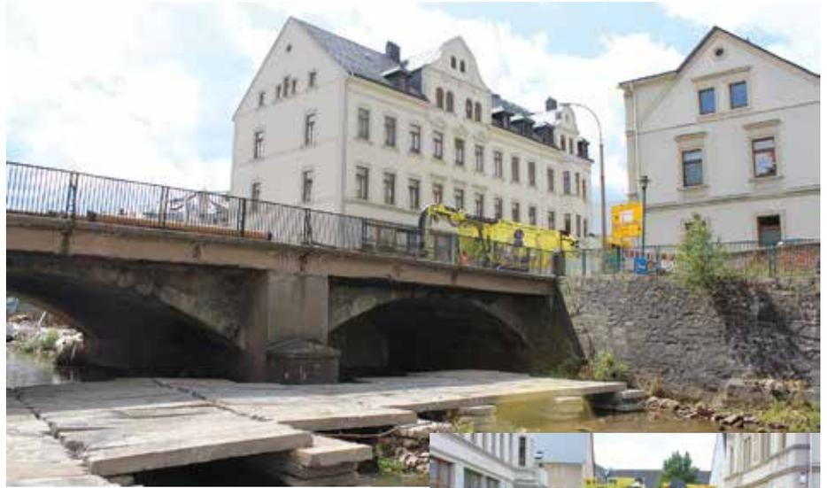
**Bessere Variante:** Bei der Sanierung der Marktbrücke in Olbernhau kam nur Handschachtung oder Saugbaggertechnik in Frage – die Saugbaggertechnik der SBW GmbH bekam den Zuschlag. (Fotos: SBW)
