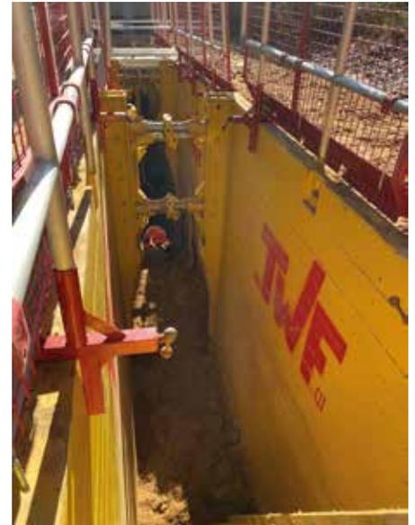
**Einsatz der XL-Verbauboxen:** Die Baugrubenabsicherung beim Sanierungsprojekt in Leverkusen erfolgt mit Absturzsicherungen und Zaunelementen sowie Einsatz der Grabenbrücke zum sicheren Überqueren des Grabens von TWF. (Fotos: TWF Tiefbautechnik GmbH)
