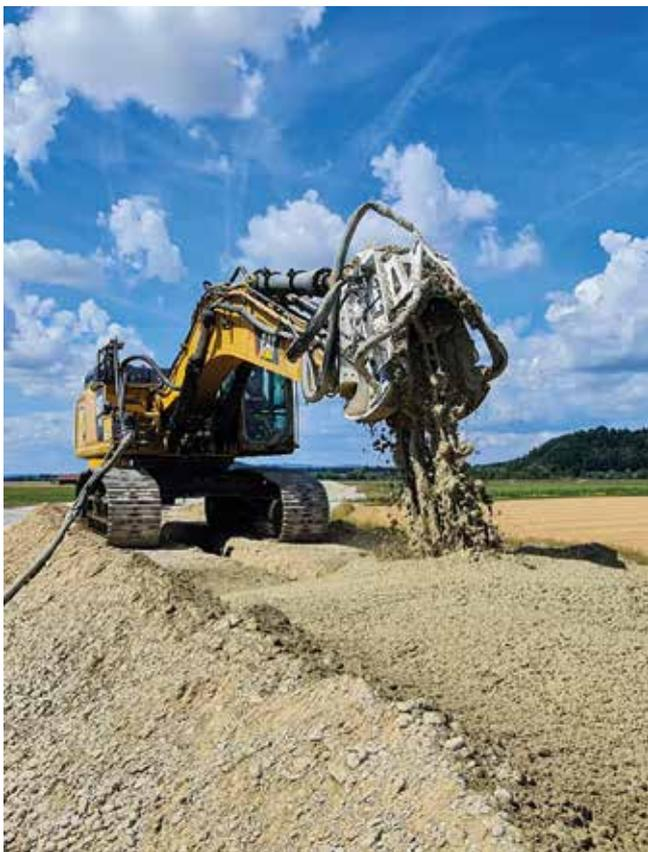
Auf Spezialtiefbau fokussiert KEMROC mit seinem neuen Geschäftszweig KEMSOLID. Dessen zentrale Elemente, die KSI-Injektoren, durchmischen den Boden mit einer Zementsuspension. So entstehen genau definierte, solide und dichte Erdbetonkörper.
