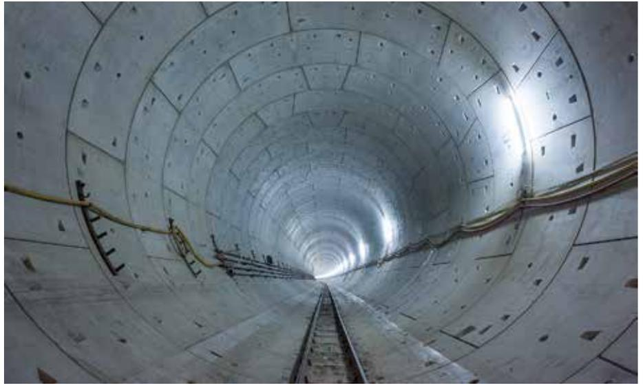
**Runde Sache:** Tübbingausbau im Boßlertunnel nach dem Vortrieb. (Foto: Porr)
