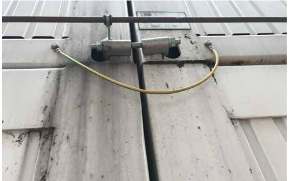
**Abb. 5:** Verbindung zwischen zwei Containern zum Potentialausgleich.
