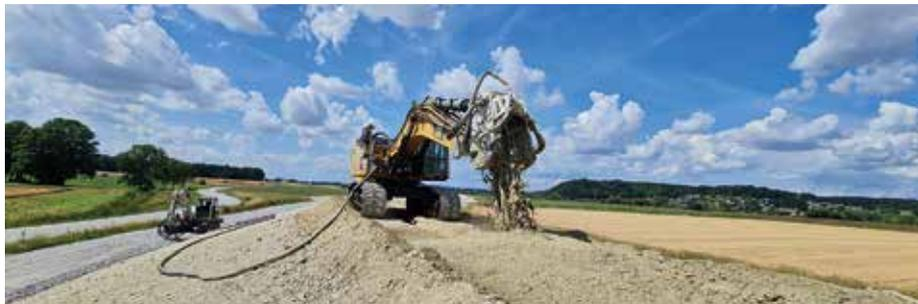
Auf Spezialtiefbau fokussiert Kemroc mit seinem neuen Geschäftszweig Kemsolid. Die KSI-Injektoren durchmischen den Boden mit einer Zementsuspension. So entstehen genau definierte, solide und dichte Erdbetonkörper. (Fotos: Kemroc)
