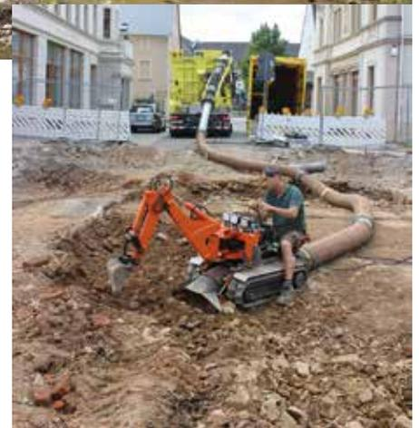
**Cleverer Lösung:** Durch den Einsatz eines Mini Diggers von RSP lastet nur wenig Gewicht auf der Brücke.
