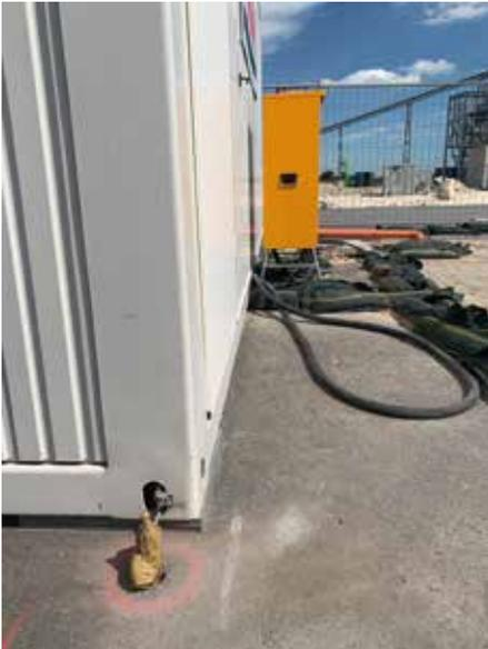
**Abb. 4:** Beispielhafte Erdung von Containern mittels Tiefenerder, Blitzschutzmaterial und Bohrung durch die Asphaltdecke.
