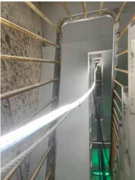
**Abb. 6:** Ein LED-Lichtschlauch mit 2400 lm/m wird bei einem Sanierungs-Projekt an einem Stahlseil befestigt und in ein Treppenhaus gehängt. Dies ist nun auch möglich nach der DGUV Information 203-006
