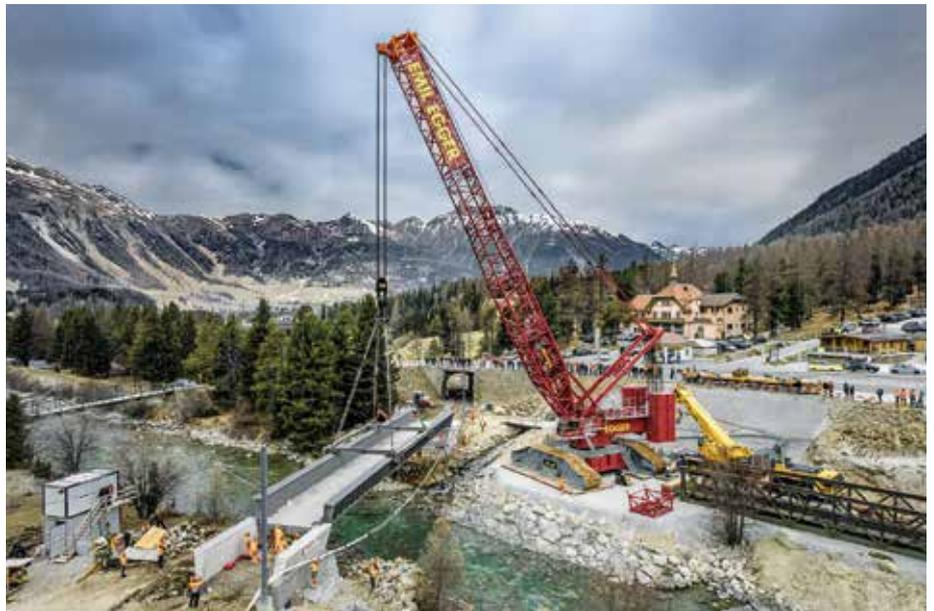
**Drangvolle Enge:** Deutlich zu sehen ist, dass für Derrickausleger und Schwebeballast kein Raum zur Verfügung steht. Rechts wurde die alte Fachwerk-Brücke abgesetzt, die 100 Jahre zuverlässig ihren Dienst geleistet hat. (Foto: Liebherr)
