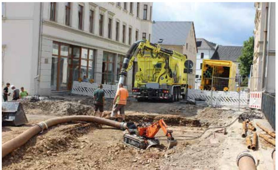
**Genug Platz:** Die Kombination mit dem neuen Tandem-Tieflader-Anhänger von SBW ermöglicht, Material, Schlauchverlängerungen oder sogar kleinere Bagger zur Baustelle zu bringen.
