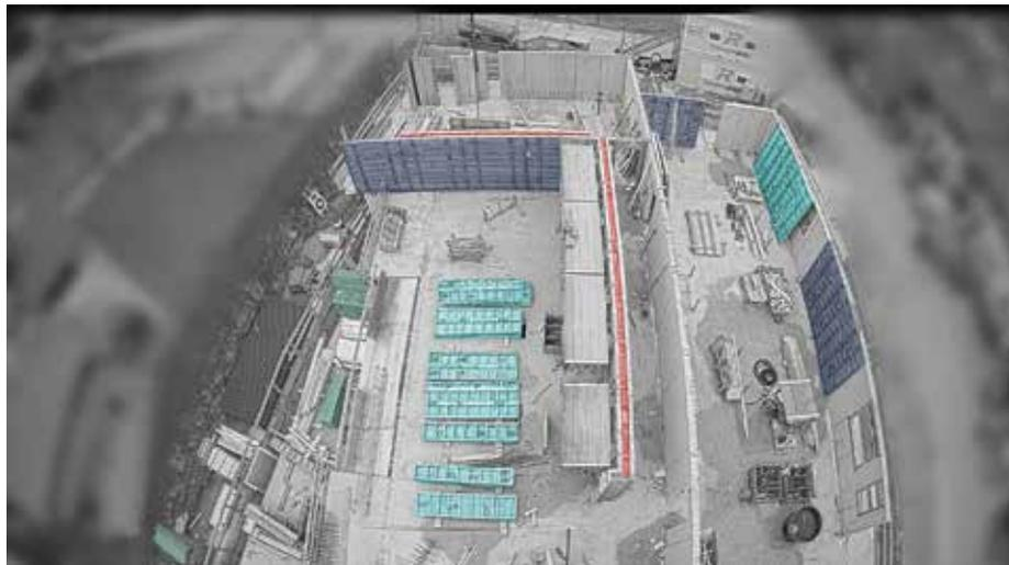
Die Kameras zeigen das gesamte Bauareal und machen den öffentlichen Bereich unkenntlich. Das System erkennt mittels KI Objekte und Personen. (Foto: Umdasch Group Ventures)
