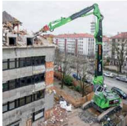
**Mit einer komfortablen Reichweite** von 33 m empfiehlt sich der neue Abbruchbagger bei Sauer Bau für besonders anspruchsvolle Abbruchvorhaben. (Fotos: Sennebogern)
