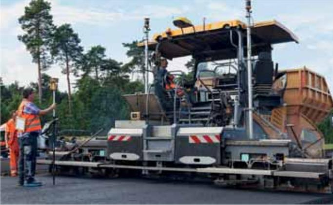
**Die 3D-Steuerung Navitronic Plus** übernimmt neben der Nivellierung und der Steuerung der Einbaulage auch das Lenken.
