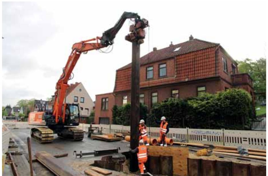
**Hohe Zugkraft für das Setzen und Ziehen der Spundbohlen** ist die Hauptanforderung für den Hitachi ZX210LC-6. Umfangreiche Ausstattungen der Maschine sorgen für sicheres und effizientes Arbeiten. (Foto: Kiesel)
