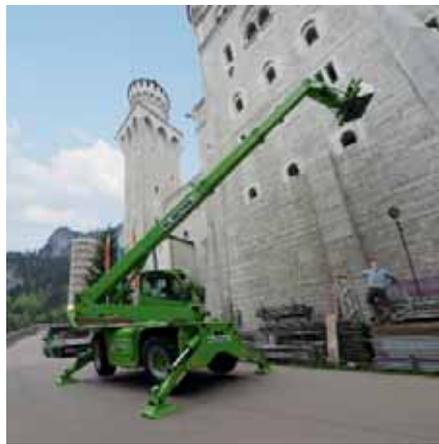
*Der gemietete Merlo Roto wurde auf der „Neuschwansteinstraße“ direkt unterhalb des Schlosses positioniert. Hier hängt die BSB Bau- und Spezialgerüstbau GmbH das Gerüstmaterial an die Maschine an. (Fotos: HKL)*
