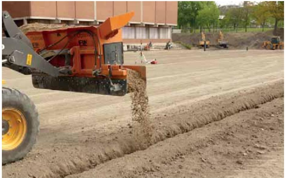
**Der Radlader mit der Finliner Materialverteilschaufel** fährt immer parallel zum Graben. Das verkürzt die Verfüllzeit und spart Handarbeit. (Fotos: Optimas)
