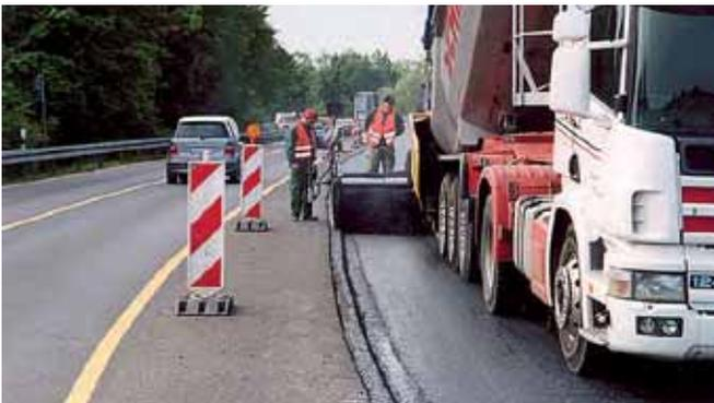
**Baustelle mit halbseitiger Sperrung**, Personal muss im Gefahrenbereich arbeiten (Foto: Leisering, BG BAU)
