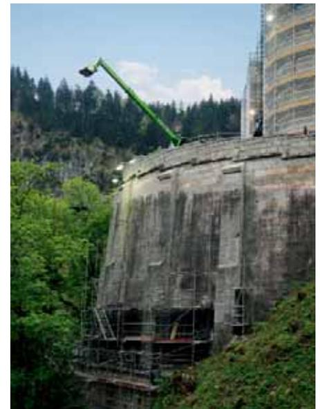
*Mit einer Seilwinde ausgestattet, ließ der Teleskop das Gerüstmaterial von oben in die Tiefe der Pöllatschlucht hinunter.*
