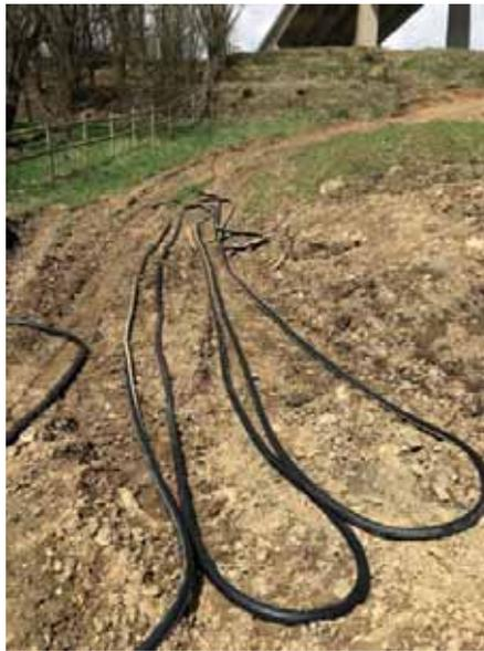
*Durch das bis zu 60 Prozent geringere Gewicht liegen gegenüber dem vergleichbaren Einsatz von herkömmlichen Kupferleitungen die Zeiteinsparungen beim Ausbringen zwischen 25 und 75 Prozent. (Fotos: Engst Kabel)*
