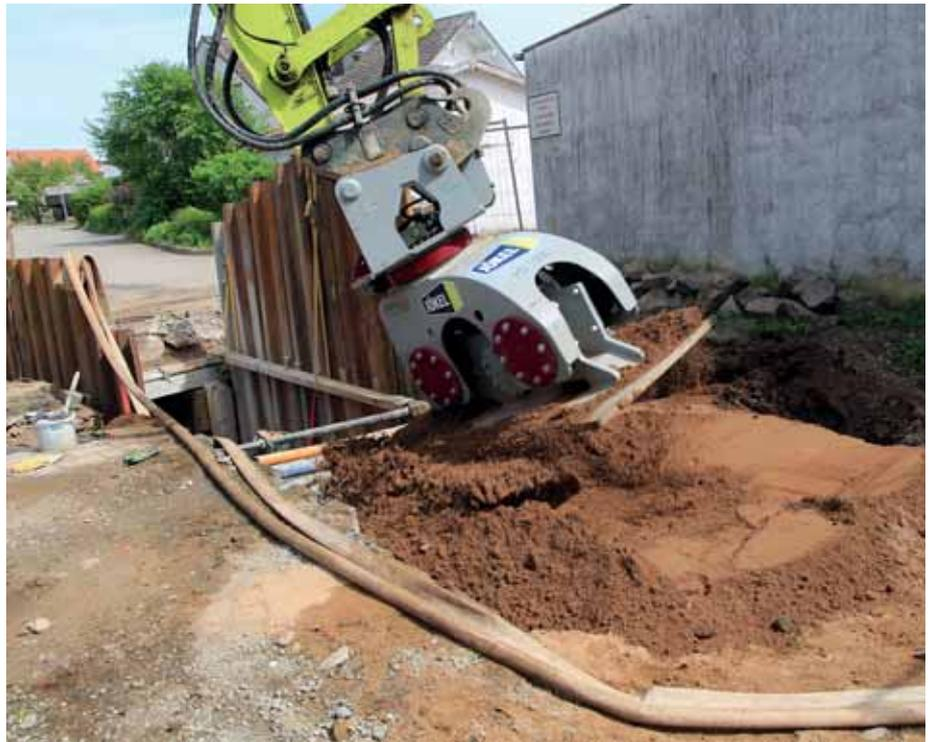
*Das Display zeigt immer zur Baggerkabine, unabhängig davon, in welche Richtung der Verdichter gedreht wird: So wird eine hohe Qualität der Verdichtung erreicht und gleichzeitig jede Art von Schäden verhindert. (Foto: Kiesel)*
