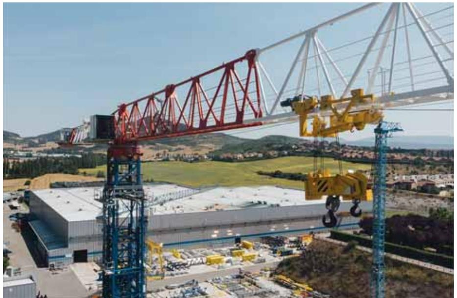
**Dank des Einfach- und Doppelaufkatzsystems** mit automatischem Wechsel der Umlenkrollen verfügt der Kran stets über ein optimiertes Lastdiagramm.
