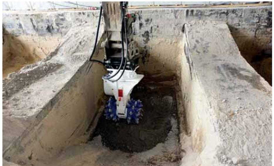
**Beim Bau der neuen S-Bahn-Linie S21** in Berlin müssen Baggeranbaufräsen den Altbestand an Beton durchfräsen, um den weiteren Bauprozess zu ermöglichen. (Foto: Erkat)
