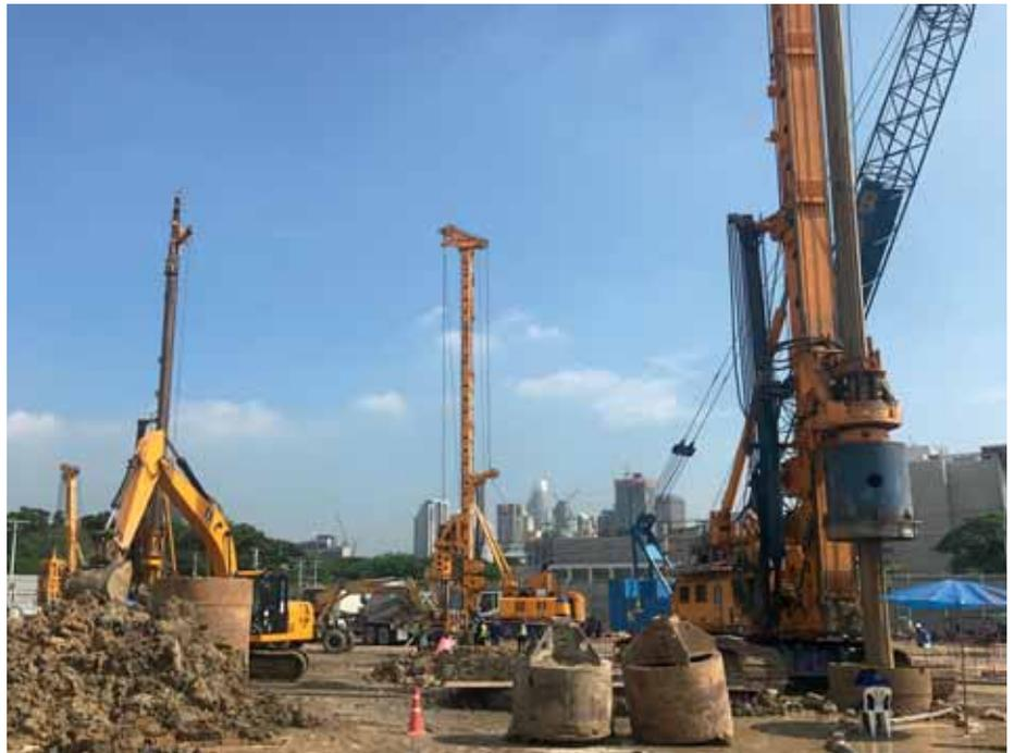
*Thai Bauer wurde im Rahmen des Großprojekts „One Bangkok“ mit der Gründung der Gebäude sowie der Herstellung der Schlitzwand beauftragt. (Foto: Bauer Group)*
