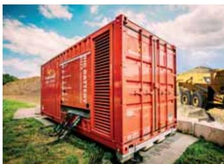
**Trotz der hohen Kapazität** von 600 kWh lässt sich der Batterie-Großspeicher „Big Battery Box“ mit nur wenigen Handgriffen am Einsatzort aufstellen. (Fotos: Bredenoord)
