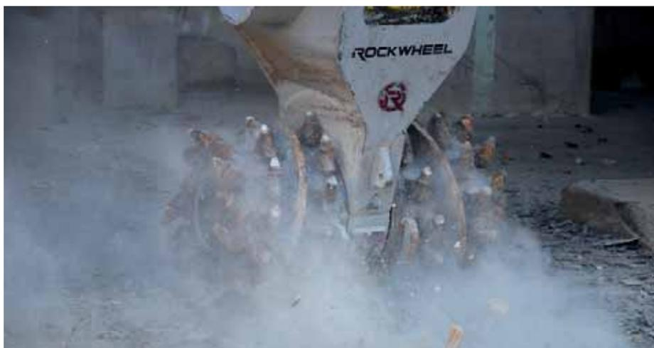
**Die Rockwheel Fräse D15** beim Anrauen von Beton. (Foto: Kiesel)
