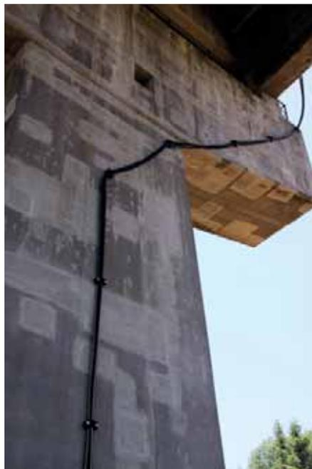
*Durch die Einsetzbarkeit bis zu einer Nennspannung Uo/U 600/1000 V lassen sich auf „Trafo-Strecken“ auch große Entfernungen, wie sie oft auf Autobahn- und Brückenbaustellen auftreten, äußerst wirtschaftlich überwinden.*
