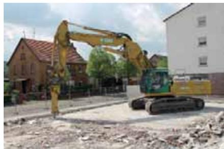
Der KMC zerlegt mit dem Hydraulikhammer die Fundamente des ehemaligen Supermarktes.
