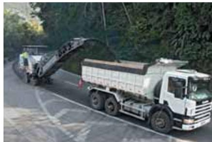
Die Großfräse bietet ein breites Anwendungsspektrum – von der Deckschicht-Sanierung über den kompletten Ausbau bis hin zu Feinfräsarbeiten.
