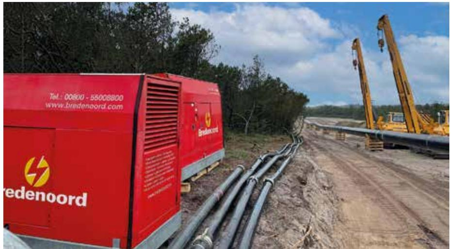
**Autark:** Mobile Stromaggregate von Bredenoord sichern bei der Trockenlegung von Röhrräben den Betrieb der Wasserpumpen. (Foto Bredenoord)
