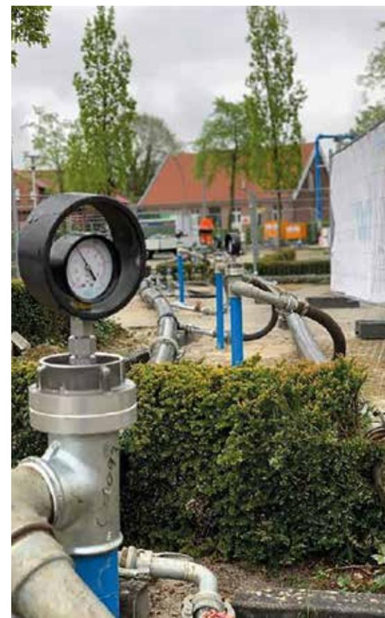
**Daten in Echtzeit:** Über 30 Brunnen am Campus Lingen werden zwischen 25 bis 30 m<sup>3</sup> Wasser stündlich infiltriert. Die Daten werden an die Hölscher Wasserbau GmbH übermittelt und können jederzeit online eingesehen werden. (Foto: Hölscher Wasserbau)
