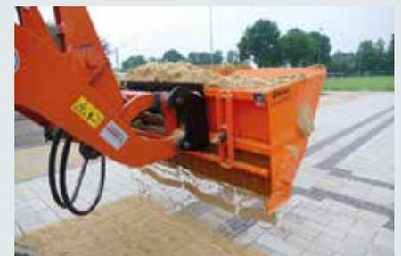
**Schnelle Lösung:** Die Optimas-Streuschaufel verteilt das Füllmaterial gleichmäßig.
