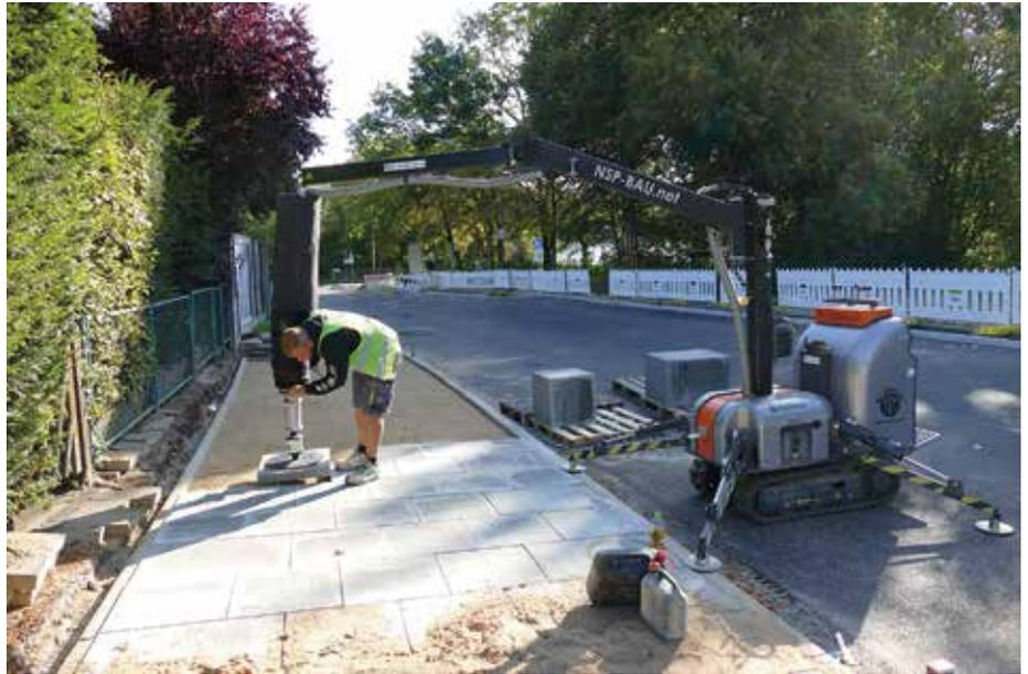
**Kraftpaket:** Mit dem Optimas Vacu-Mobil Allrounder lassen sich schwere Platten oder Hochborde leicht und schnell verlegen. (Fotos: Optimas)
