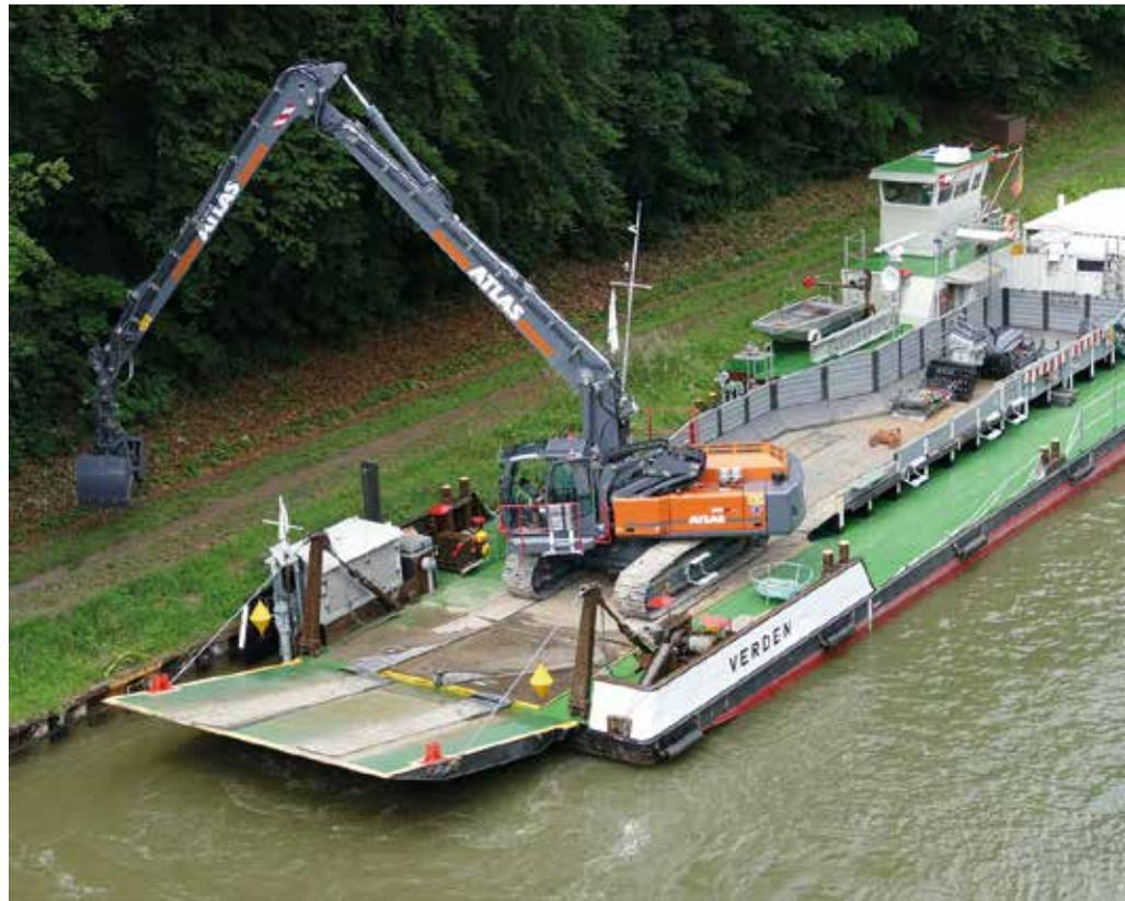
**Großes Einsatzspektrum:** Der Atlas-Kettenbagger 340 LC blue erledigt Böschungsarbeiten von der Arbeitsfähre „Verden“ aus. (Foto: Atlas)
