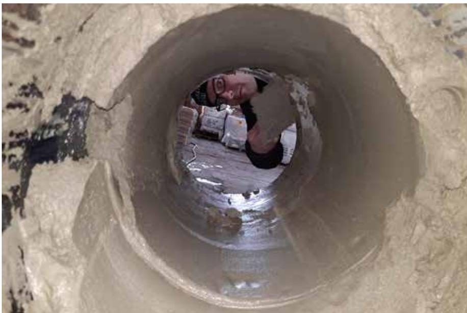
**Effektive Lösung:** Das Team setzt auf ein neuartiges Beton-Liningsystem, bei dem der Beton auf die Tunnelwand gespritzt wird.
