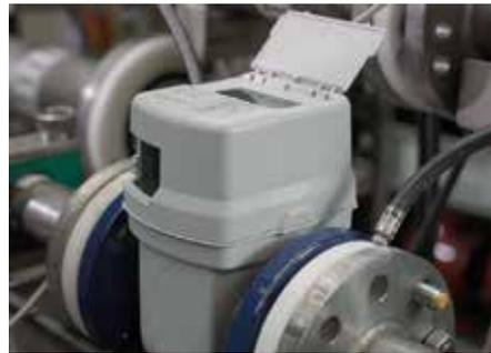
**Präzise:** Der statische Wasserzähler Cordonel liefert zuverlässige Informationen für die effektivere Steuerung von Verteilungsnetzen. (Foto: Xylem)
