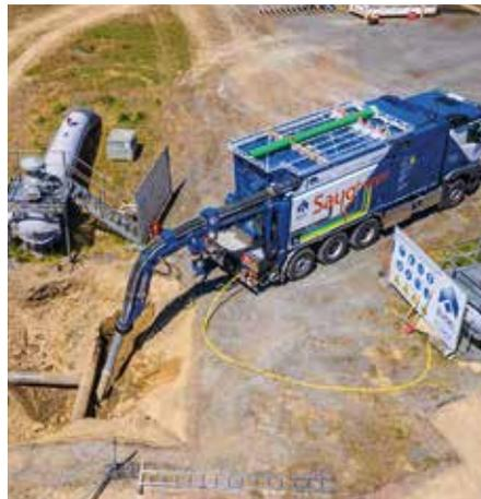
**Schonende Technik:** Saugbagger-Einsatz beim Herrichten einer Baugrube für die Umlegung einer Gasleitung DN300. (Foto: Dominik Ketz)
