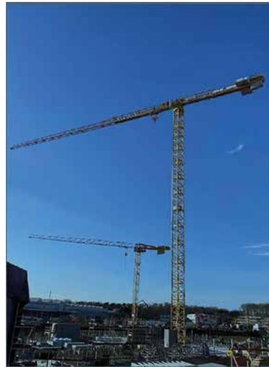
**Zentral platziert:** Der Potain MDT 809 in der 32 t-Variante erreicht mit 80 m Auslegerlänge und 67,10 m Hakenhöhe bei Bau der FAIR-Teilchenbeschleunigeranlage in Darmstadt auf dem gesamten Baufeld eine Hubkapazität von 5 t. (Foto: Manitowoc)
