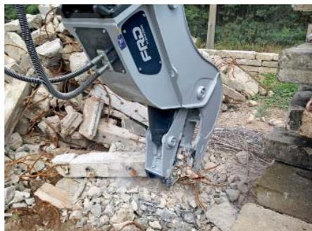
**Vorbereitung zum Recycling:** Ein Pulverisierer VS15 löst die Moniereisen aus der Betonkonstruktion heraus.
