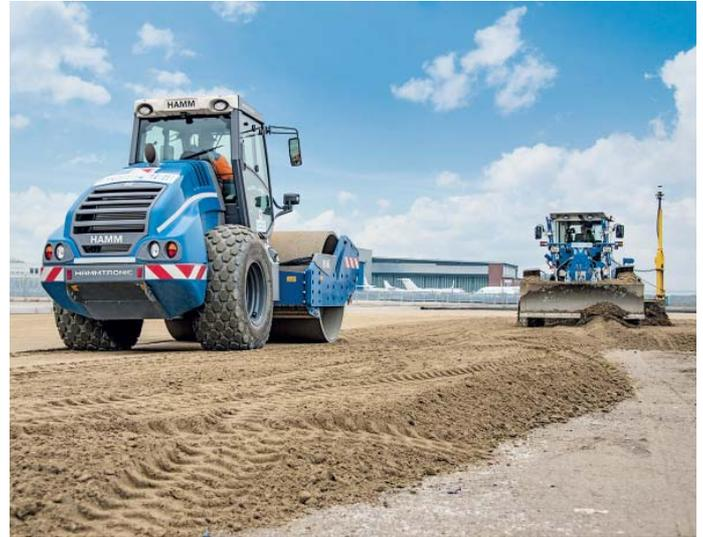
**Die Verdichtung der HGT** erfolgte am Flughafen Köln/Bonn mit einem Hamm-Walzenzug H 16i. (Fotos: Wirtgen)
