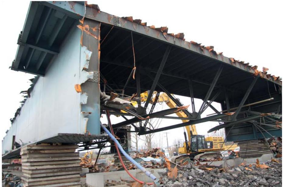
**Das 120 m lange Brückenteil** wurde in einem Stück abgebaut und von der Baumaschine mithilfe einer 15 t schweren Schere zerlegt. (Fotos: Zeppelin)
