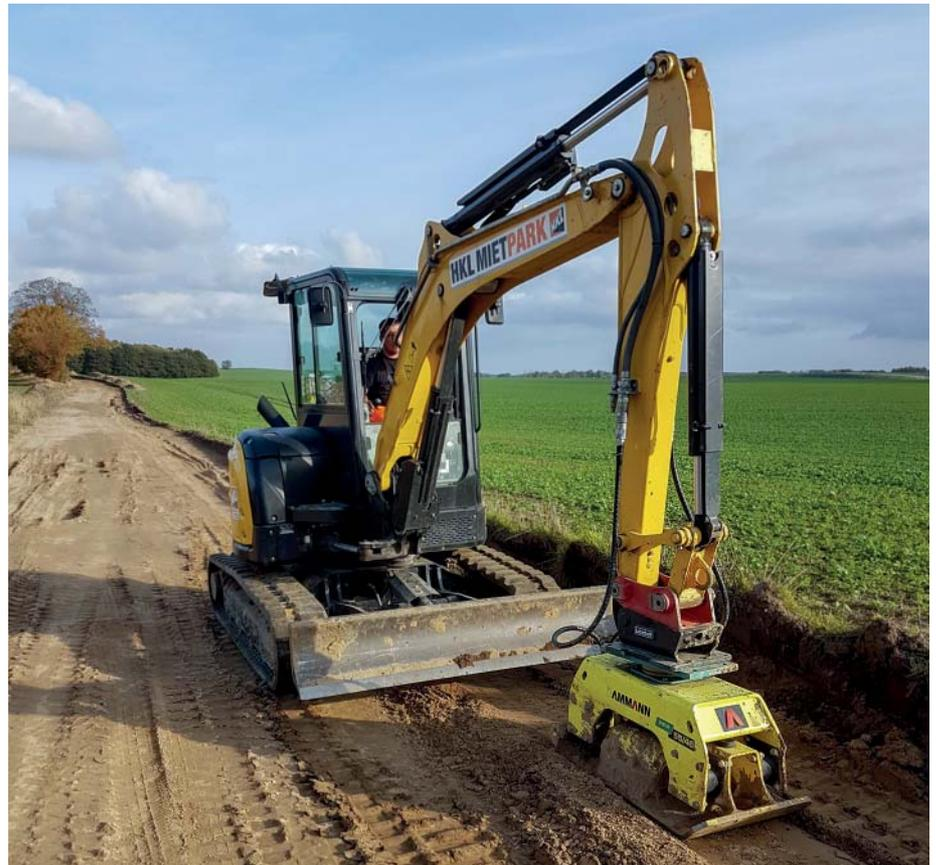
**Montiert an einem 5-t-Kompaktbagger**, konnte der Anbauverdichter sein ganzes Potenzial ausspielen. Rechts ist die gleichmäßig verdichtete Oberfläche gut zu erkennen. (Fotos: Ammann)
