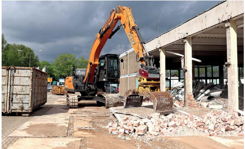
*Die sensible Hydraulik bietet ein direktes Feedback und erlaubt mit dem Greifer einen punktgenauen Zugriff.*
