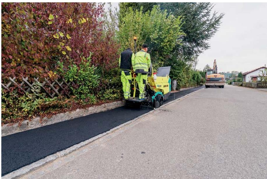
**Spezialität:** Die geringe Einbaubreite von 250 mm bis 1650 mm wird durch Reduzierbleche erreicht und unterscheidet den neuen Minifertiger von seinen Wettbewerbern. (Foto: Ammann)
