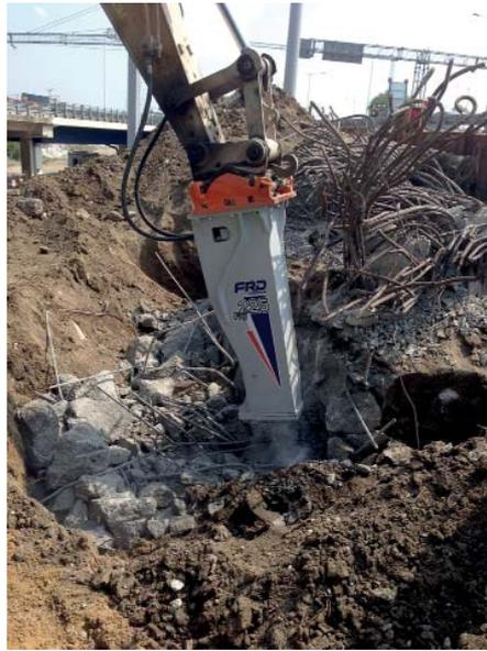
**Stemmarbeit:** Ein Hydraulikhammer FXJ beim Rückbau der Brückenfundamente. (Fotos: FRD)
