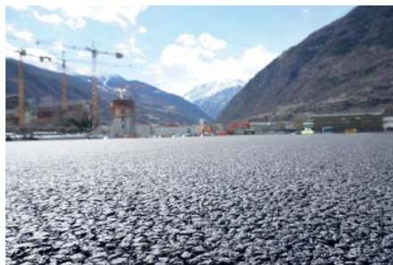
**Perfektes Resultat.** Der fertige Sickerasphalt auf dem Parkplatz in Visp.
