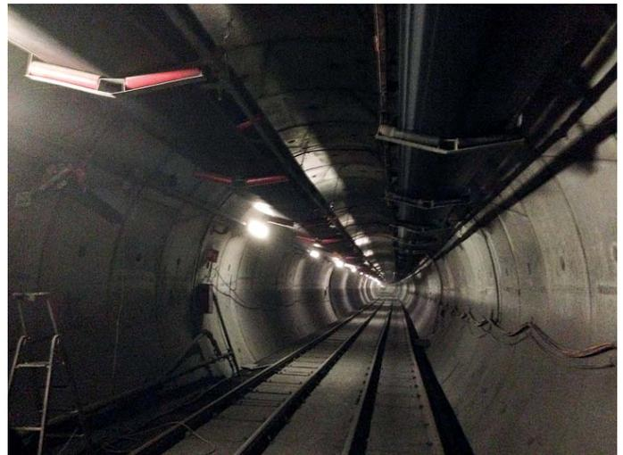
**Die aktuellen Tunnelarbeiten im Baulos „Mauls 2-3“:** Der Zulaufunnel führt in eine große Kaverne, von dort werden der Erkundungsstollen (r. mit Gleisbetrieb) und die Haupttunnel aufgefahren. Vier Ventilatoren mit 3,5 MW Leistung fördern 200 m<sup>3</sup> Luft pro Stunde in das Tunnelsystem.
