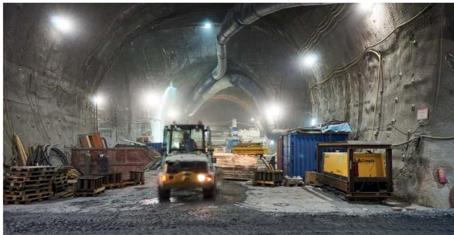
Das Kufenmodell des Kompressors wandert mit dem Baustellenfortschritt mit. Air & Plus bietet als eine Option einen Abgas-Partikelfilter. (Foto: CompAir)
