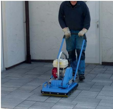
Großformatiger Betonplatten mit einer verhältnismäßig geringen Stärke lassen sich mit einem Rollenrüttler wie dem VPR 450 schonend in die Bettung drücken. (Foto: Weber MT)
