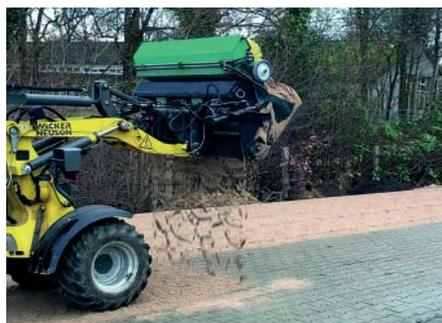
Mit dem Besander wird der Sand exakt und gleichmäßig dosiert auf der Fläche verteilt.
