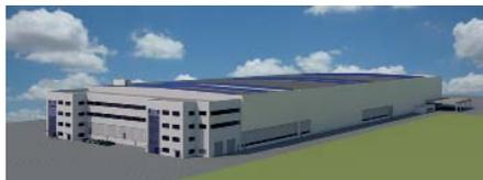
**Nach Fertigstellung** wird das neue Logistikzentrum für die Produktion eine Gesamt-Abmessung von rund 245 x 96 m und eine Höhe von rund 22 m erreichen.
