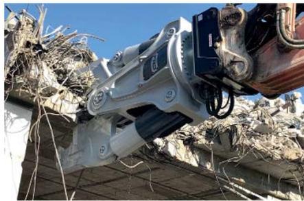
**Beißt sich durch:** die 6 t schwere Betonschere V50 beim Brückenrückbau.
