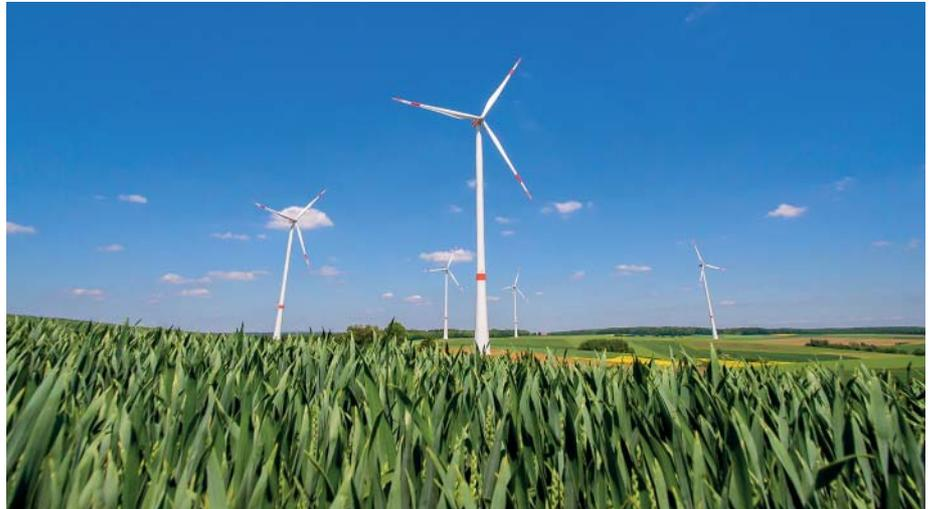
**Der Hybridturm 2.0** benötigt weniger Material, gewährleistet aber gleichzeitig höchste Standsicherheit. Anpassungen im Fundamentdesign, dem Innenausbau sowie eine neue Turmsegmentierung und Geometrie machen das Hybridturm-System insgesamt noch wirtschaftlicher. (Foto: Max Bögl Wind)
