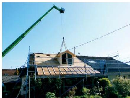
**Der Einbau einer Dachgaube** erfolgt einfach mit der angebauten Winde.
