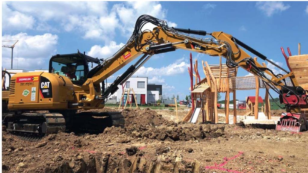
**Der Kurzheck-Minibagger Cat 308 E CR** beim Ausheben der Fundamente für die Doppelseilbahn. (Foto: Zeppelin Rental)
