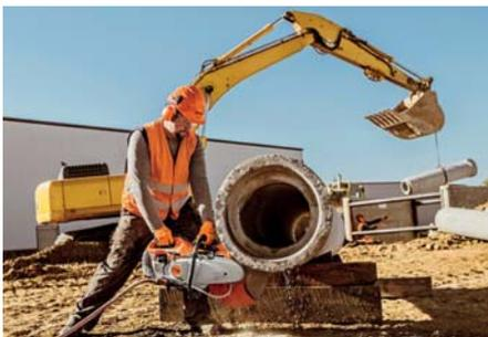
**Ran ans Rohr:** Der neue Trennschleifer ermöglicht eine erweiterte Verstellung des Scheibenschutzes. So lassen sich Schneidarbeiten an der Rohrunterseite besonders einfach erledigen. (Foto: Stihl)
