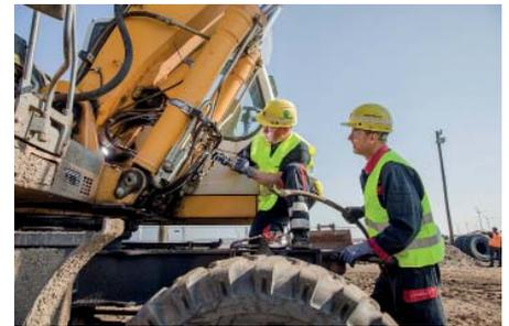
In Notfällen waren die Servicetechniker des Hydraulikspezialisten schnell auf der Baustelle. Sie vermaßten die Schlauchleitungen und fertigten Ersatz an. (Fotos: Hansa-Flex)
