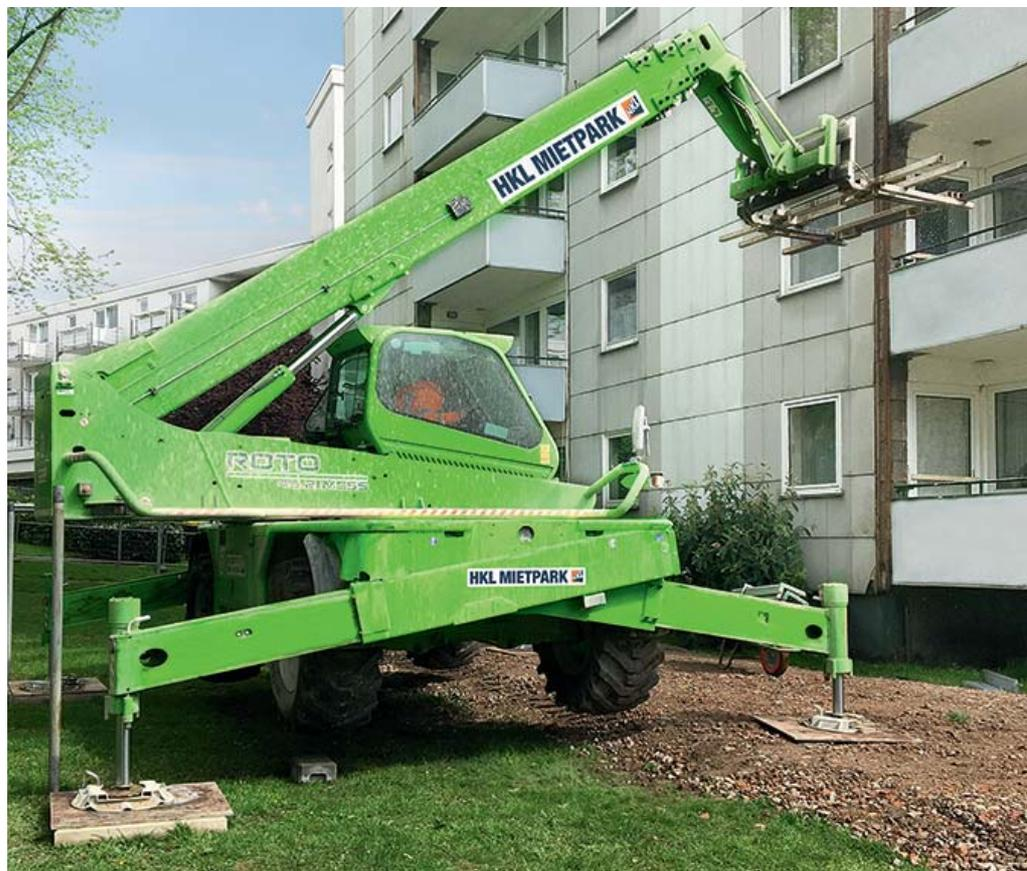
*Der Roto 45.21 Teleskopstapler aus dem HKL-Mietpark stützte die Bodenplatten der Balkone und transportierte sie direkt am Haus entlang ab. (Fotos: HKL Baumaschinen)*
