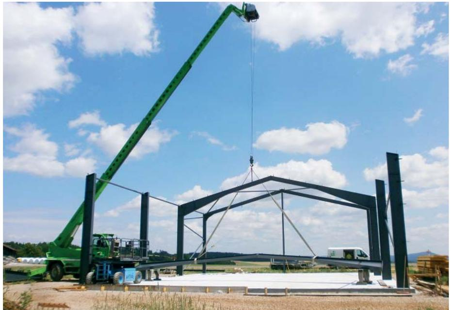
**Teleskoplader als Zimmererkran:** Beim Holzhallenbau punktet der Roto MCSS mit seinem drehbaren Oberwagen und vier einzeln vertikal und horizontal teleskopierbare Abstützungen. (Fotos: Günther)
