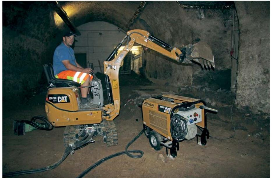
**Christian Antes** muss mit dem elektrisch angetriebenen Mikrobagger im Weinkeller 60 cm ab Oberkante beziehungsweise 120 m<sup>3</sup> Boden entfernen. (Fotos: Zeppelin)
