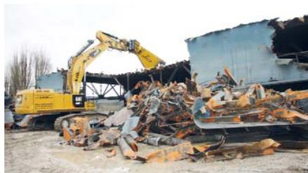
**Der Cat-Bagger von Peter Kolb** ist für Härtefälle wie die Schiersteiner Brücke konzipiert. Er muss massive und tonnenschwere Stahlteile umschlagen.
