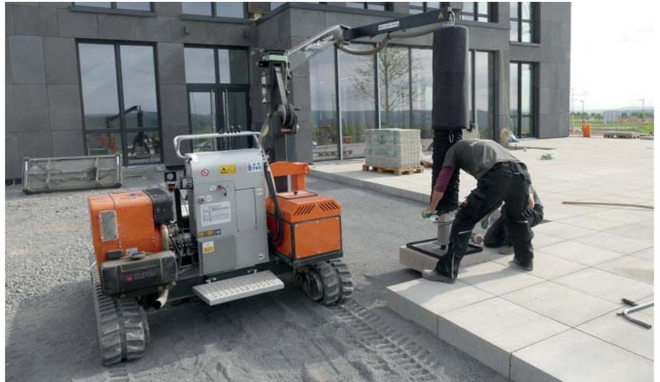
**Das Vacu-Pallet-Mobil** verbindet Materialtransport und leichtes Materialhandling durch die Vakuumschlauchhebetechnik. (Foto: Optimas)
