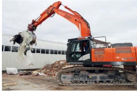
**Mit dem Demarec-Sortiergreifer** lässt sich das Abbruch-Material sortieren und zügig verladen
