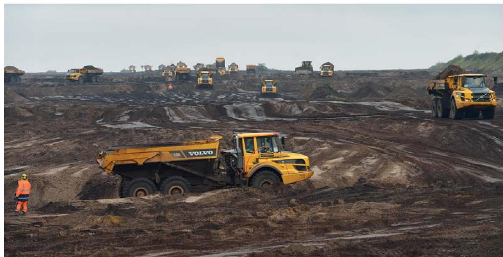
**In Spitzenzeiten waren bis zu 140 Geräte im Einsatz,** die rund 100.000 m<sup>3</sup> pro Tag bewegten: über 100 Muldenkipper (Dumper), die das Erdreich transportierten, schwere Bagger und Raupen sowie weitere Maschinen. (Foto: Volvo CE Deutschland)
