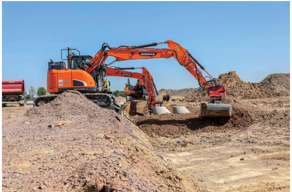
Die 3D-Maschinensteuerung von Topcon ermöglicht es den Gutseel-Baggern, auf einen Rutsch exakt terrassiert auszuschachten. (Fotos: Topcon)
