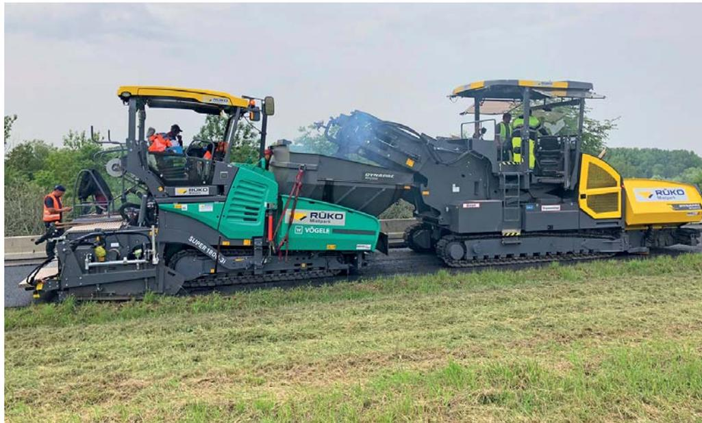
**Enger Zeitrahmen:** Der Beschicker sorgte mit einer Kapazität von 4000 t/h für einen kontinuierlichen und erschütterungsfreien Einbau des angelieferten Asphalts. (Foto: Ruko)
