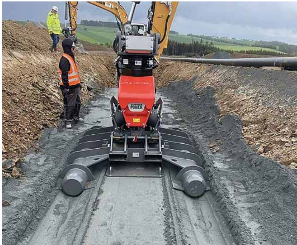
Flexibles Anbauwerkzeug: Mit dem V8X3WA-Duo Verdichter mit Erdkabel-Verlegesystem wurde eine Lücke im MTS-Portfolio geschlossen. (Fotos: MTS)
