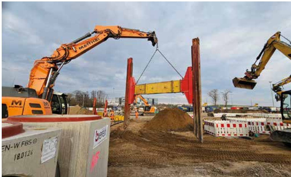
Persönliche Einweisung: Mithilfe des TWF-Beraters wird der flexible TWF-Gleitschienenverbau positioniert und so Fehler beim Einbau vermieden. (Foto: TWF Tiefbautechnik GmbH)
