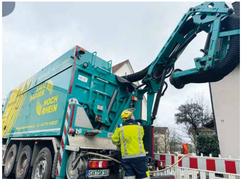
Schnell positioniert: Die Mitarbeiter von Saugbagger Hochrhein bringen ihren DINO12 in Einsatzbereitschaft. (Fotos: MTS)
