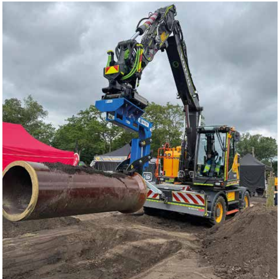
Exakte Positionierung: Mit dem Rohrmaster können Rohre schnell und präzise verlegt werden. (Foto: Tibatek)
