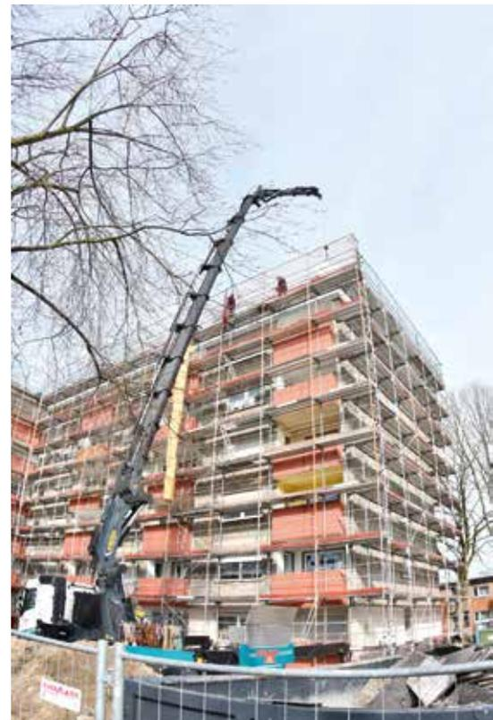
**Enorme Reichweite:** Der Palfinger-Kran PK 165.002 TEC7 mit seiner hydraulischen Hubhöhe von fast 40 m steckt auch die schwierigsten Aufgaben gut weg. (Foto: Palfinger)
