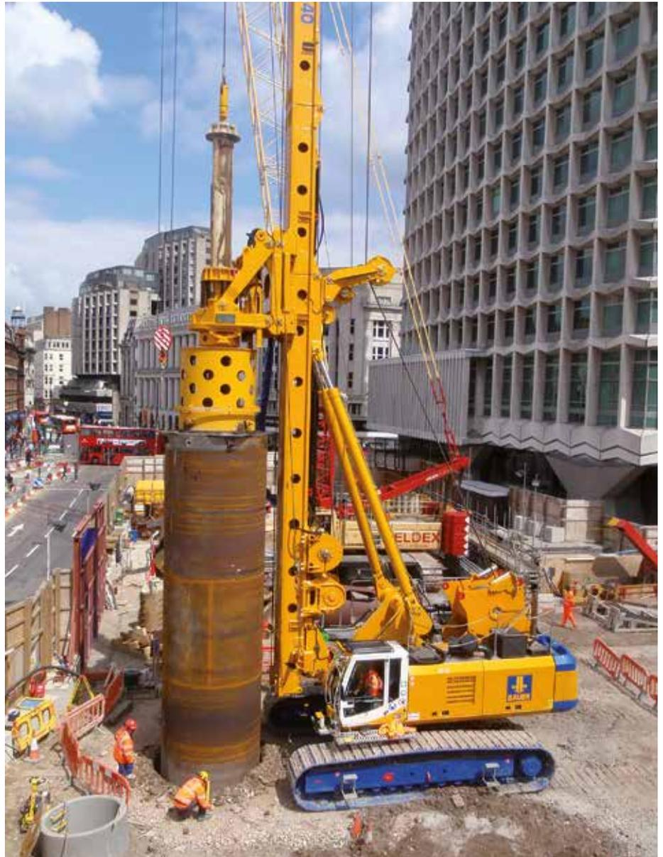
**Großprojekt:** Für die Tottenham Court Road Station stellte Bauer 10.000 m<sup>2</sup> überschneitene Pfahlwand, rund 6.400 m<sup>2</sup> Schlitzwand sowie sieben verrohrte und bis zu 64 m tiefe Pfähle her.
