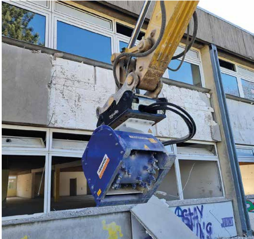
**Sanierung eines Schulgebäudes:** Dank der millimetergenau einstellbaren Frästiefe kann die Vorsatzschale aus Beton sortenrein von der Dämmschicht gelöst und das Fräsmaterial entsorgt werden. (Foto: Kemroc)
