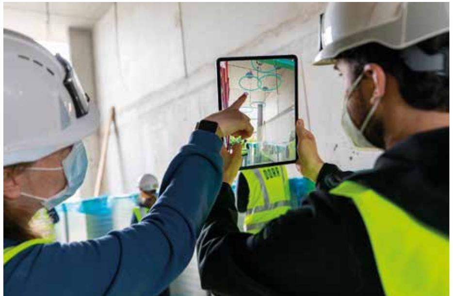
**Blick in die Zukunft:** Nutzung der BIM-Modelle auf der Baustelle in der Augmented Reality App „GAMMA AR“. (Foto: Porr)
