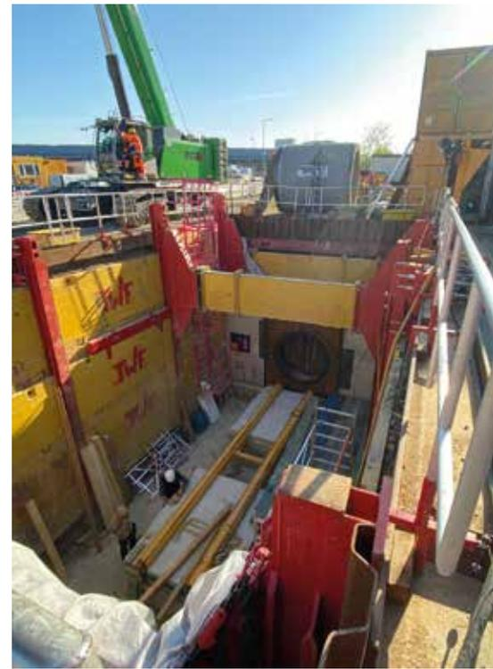
**Umverlegung von Medien:** Pressgrube für Vortrieb DN 2200 mit TWF Gleitschienenverbau am Bahnübergang Buckower Chaussee im Berliner Ortsteil Marienfelde. (Foto: Max Bögl)
