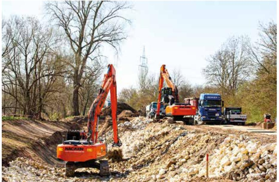
**Renaturierung:** Mit zwei Hitachi ZX250 LCN fertigt die Nacken GmbH einen künstlichen Flussarm am Neckar. Beide Baumaschinen sind mit einer Leica-Baggersteuerung ausgerüstet. (Foto: Kiesel/Jasmin Hanf)
