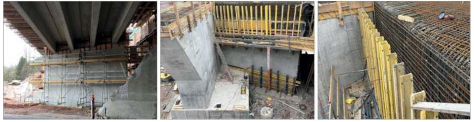
**Ersatzneubau mit Bauphasen** und Bewehrungsführung der Einspannung in die Widerlagerwand.
