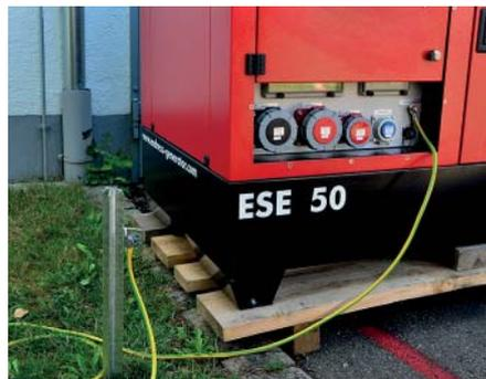
*Ausführungsbeispiel eines Erdungsanschlusses eines „großen“ Stromerzeugers*
