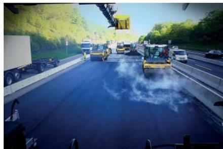
**Der *Thermalprofilensor des Pave-IR*** erfasst mit Infrarot-Technologie präzise die Temperatur über eine Breite von bis zu 13 m.
