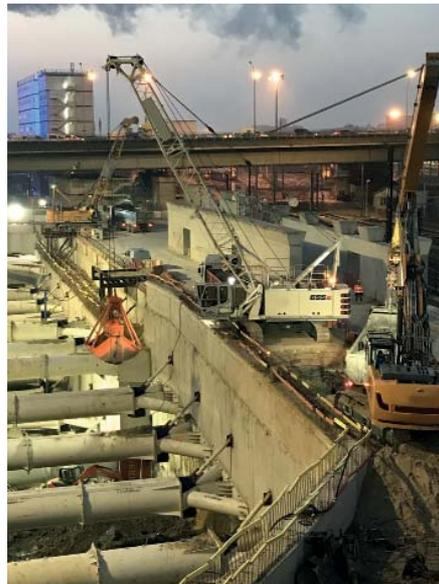
**Für Aushub aus großen Tiefen** ist ein Seilbagger mit Zweischalengreifer das Mittel der Wahl. Aus der hochfahrbaren Kabine kann der Fahrer mit direkter Sicht auf seinen Arbeitsbereich sicher arbeiten.
