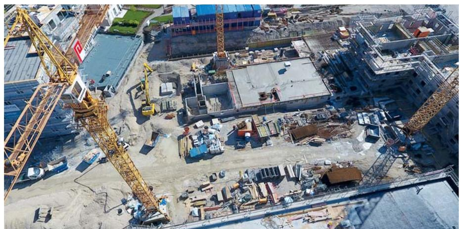
**Musterbaustelle Schäringstraße in München:** Das Monitoring mit der Drohne zeigt die Zustände des zeitabhängigen BIM mit der Baustelleneinrichtung.
