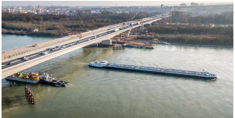
**Aktuell läuft der Verkehr beider Richtungsfahrbahnen** über die erste Hälfte der neuen Rheinbrücke. Sie ist Teil eines neuen Bauwerks mit zwei getrennten Brückenhälften. (Foto: Andreas Schlote)
