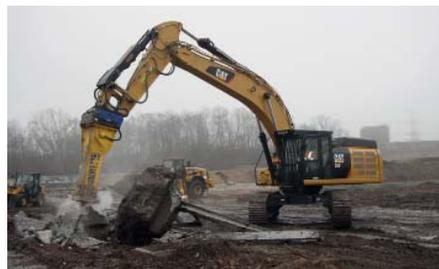
**Die Baumaschinen-Flotte** muss 375.000 m<sup>3</sup> Boden bewegen, um das Geländeprofil für Straßen, Plätze und Gebäude herzustellen. Hinzu kommen Rückbau sowie Boden- und Bauschutttaufbereitung.
