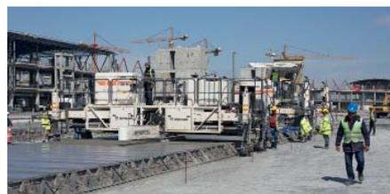
**Rollbahnen in Betonbauweise.** Drei Gleitschalungsfertiger stellen sicher, dass die Flächen den hohen Punktbelastungen wartender Flugzeuge standhalten.
