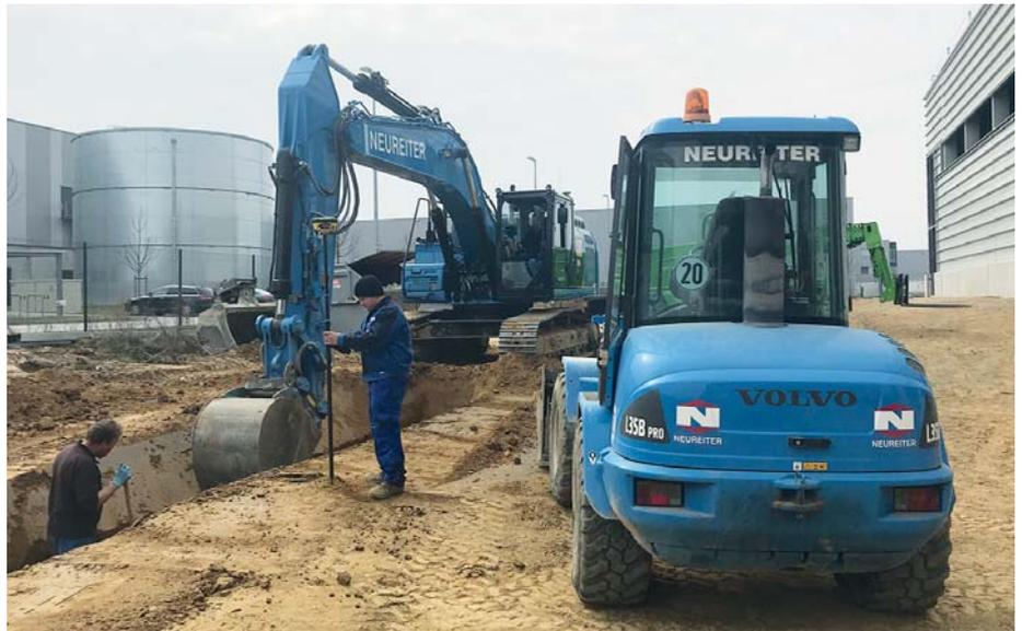
Zur Absteckung und zum Aufmaß oder zur Dokumentation setzt Neureiter einen Leica Icon Rover sowie auf den eingesetzten Baggern 3D Dual GNSS-Baggersteuerungen ein. (Foto: Leica Geosystems)
