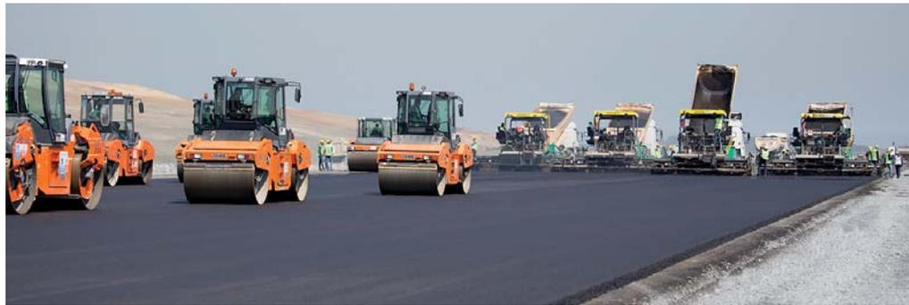
**Teamwork steigert die Qualität:** Die insgesamt zwölf Fertiger arbeiten „heiß an heiß“. Dadurch sind die Nähte wesentlich besser gegen eindringendes Wasser geschützt und halten Belastungen länger stand. Anschließend verdichten Walzenzüge die hydraulisch gebundene Tragschicht.
