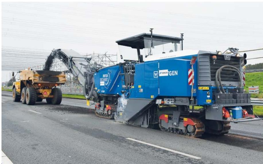
Die automatische, präzise Steuerung der Fräsmaschine spart Ressourcen und Material und beschleunigt den Prozess. (Fotos: Topcon Positioning)
