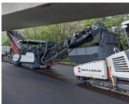
**Berührungslos und ohne Kollisionsgefahr:** Drei Lasersensoren messen permanent den Abstand zwischen Beschicker und Fertiger. Das System stoppt den Fertiger automatisch, sobald der Mindestabstand unterschritten wird.
