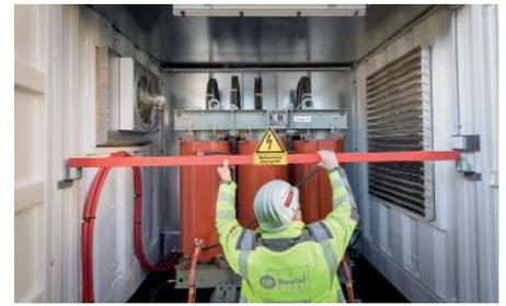
**Nach der Inbetriebnahme** werden die Zugänge zur Mittelspannung mit Schlössern gesichert.
