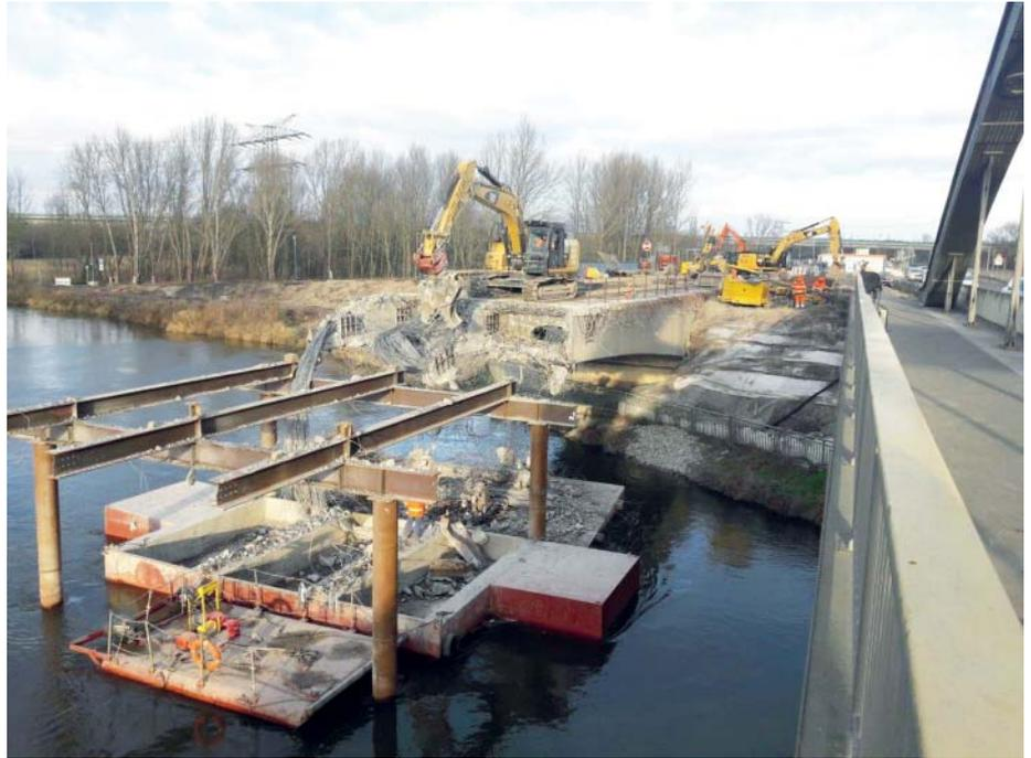
**Bei beiden Brücken** waren zunächst die Bestandsbauwerke abzubauen, um mit den Arbeiten an den Neubauten zu beginnen. (Foto: GP Verkehrswegebau)
