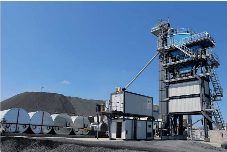
**Intelligentes Baukastensystem:** Die transportable Asphaltmischanlage Benninghoven Eco in Containerbauform ist schnell umsetzbar und einfach zu transportieren.
