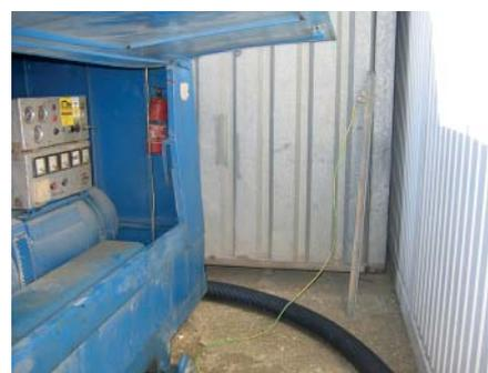
*Funktionsunfähige Erdung eines Stromerzeugers*
