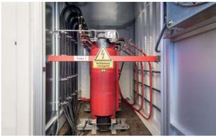
**Die Baustelle und die Radiologie** werden von zwei separaten Transformatoren mit Niederspannungsstrom versorgt.
