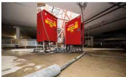
**Zuverlässige Technik:** Zeppelin Rental ist für die Elektro-Baustelleneinrichtung für sechs der neun Baufelder verantwortlich und ist mit über 200 Stromverteilern vor Ort.
