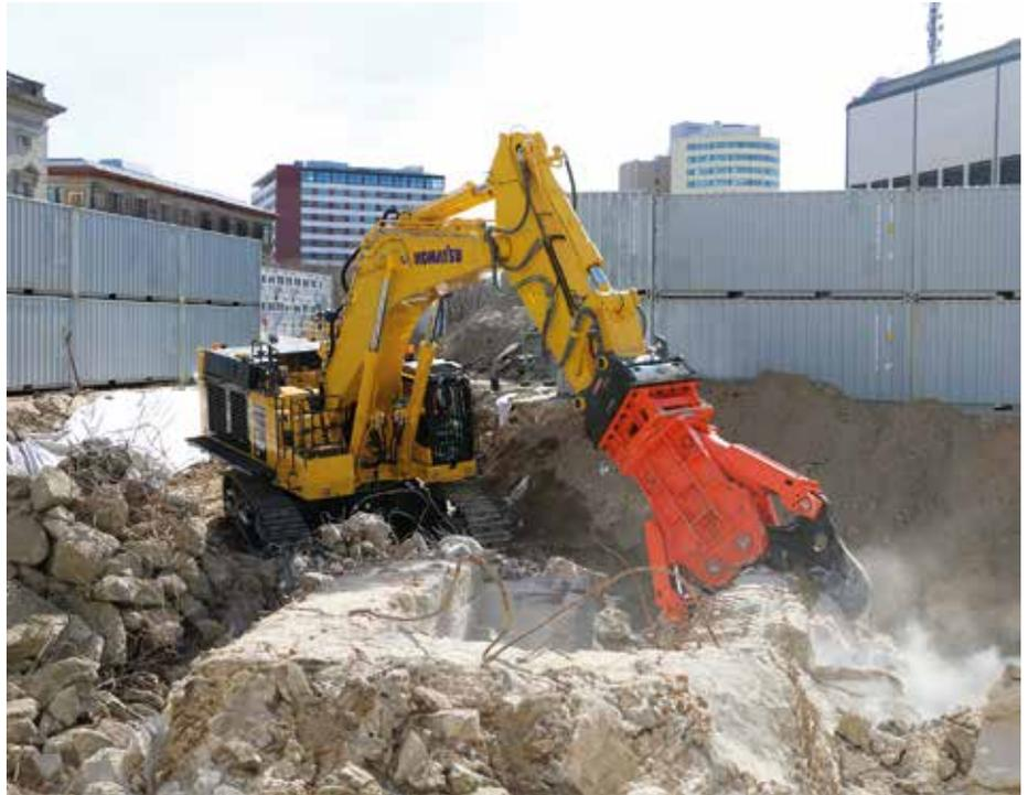
**Kräftiges Duo:** Der 100 t-Bagger PC 950 LC-11 wurde für den Bunkerabriss am Potsdamer Platz mit einer 10 t schweren NPK Betonschere SV100 XR ausgestattet. (Foto: Schlüter für Baumaschinen)
