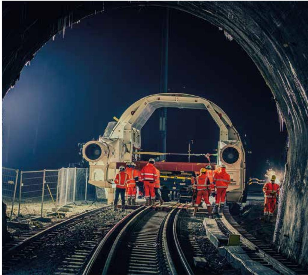
**Exakt geplant:** Die SPMT-Transportereinheit mit den aufgenommenen Geräteträgern Einfahren in den Tunnel. (Foto: Eisele AG)
