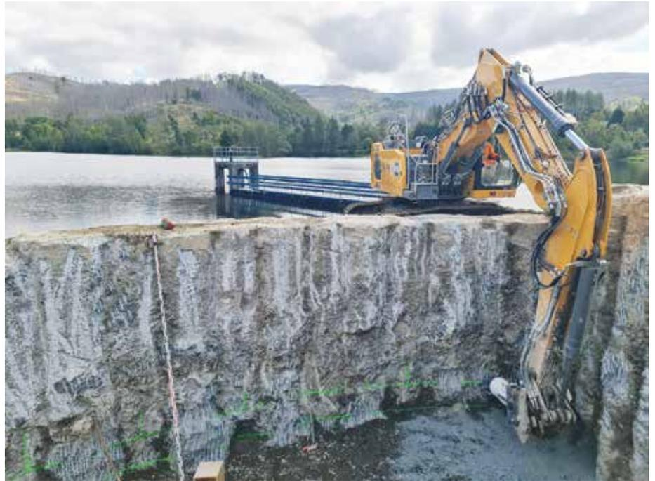
**Leistungsstark:** Ein 24-t-Bagger und ein Powertool-Antrieb KRX 70 von Kemroc beim Bearbeiten einer Bohrpfahlwand. Mit Stahlbetongurten versteift, bildet sie den Kern des Staudamms bei der Sösetalvorsperre im Harz. (Foto: Kemroc)
