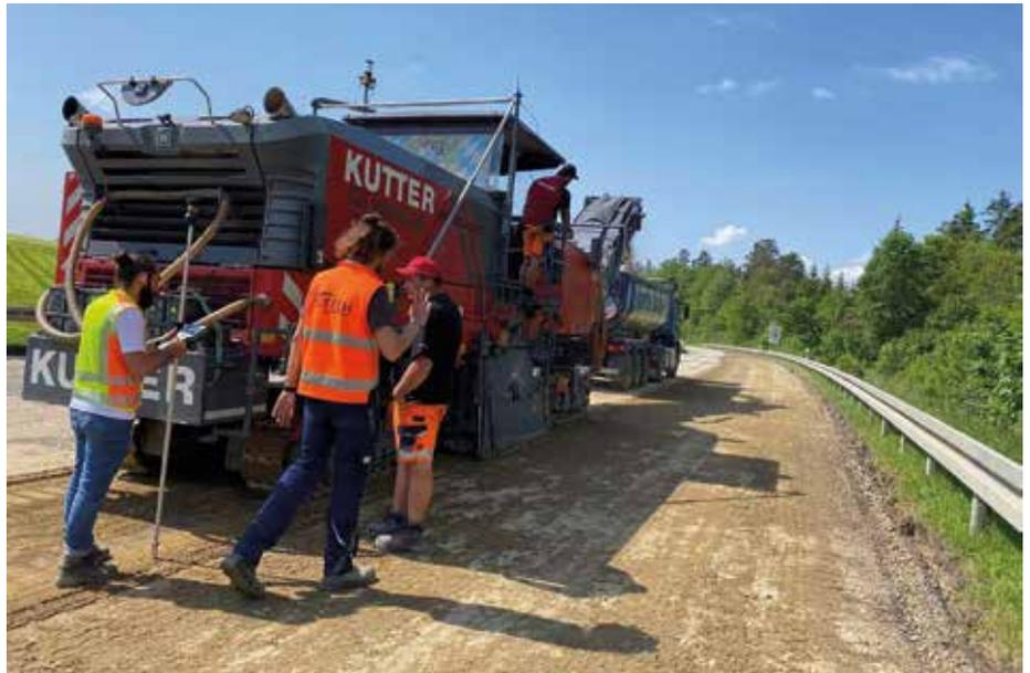
**Präzise:** Die Kiestragschicht wird mit Trimble PCS900 millimetergenau nach dem Geländemodell ausgefräst. (Foto: Friedrich Stingel GmbH)
