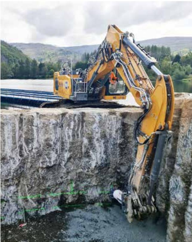
Bei Osterode im Harz wird die Vorsperre der Sösetalsperre saniert. Im Zuge dessen erhält sie eine neue Dammdichtung in Form einer Bohrpfehlwand, die im Sohlen- und Kopfbereich mit zwei Gurten aus Stahlbeton versteift wird. Dank eines leistungsstarken Baggers mitsamt effizienter Anbaufräse gelingt das Vorhaben präzise und innerhalb des vorgegebenen Zeitfensters.
