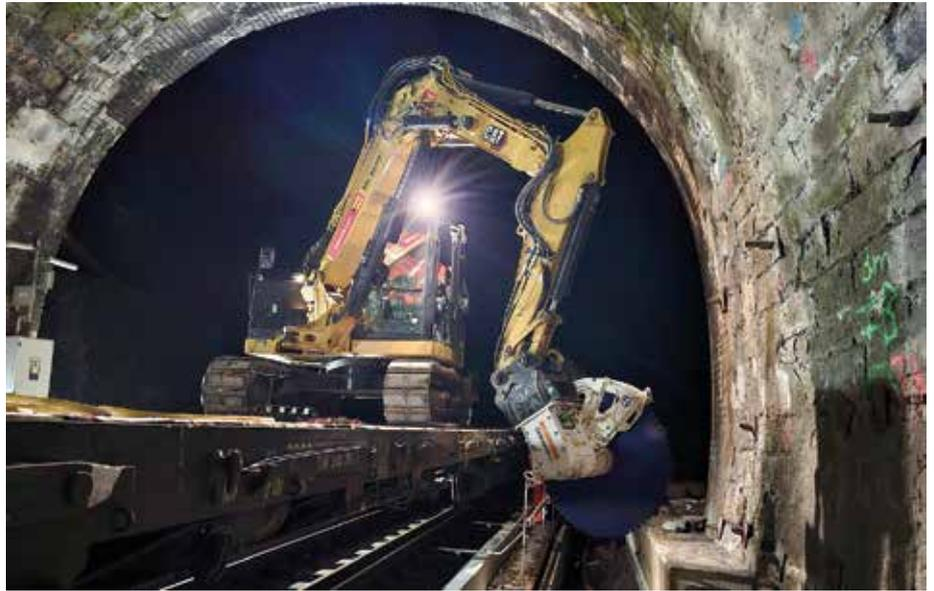
**Geniale Lösung:** Ein mit Diamantsäge ausgestatteter Bagger fährt auf einem Plattformwagen in den Elleringhauser Tunnel ein. Der Maschinist stellt den Bagger quer zur Tunnelrichtung auf und positioniert in Abständen von 150 cm die Diamantsäge, um Beton-Kabelkanäle am Tunnelfuß zu zerschneiden. (Foto: Kemroc)
