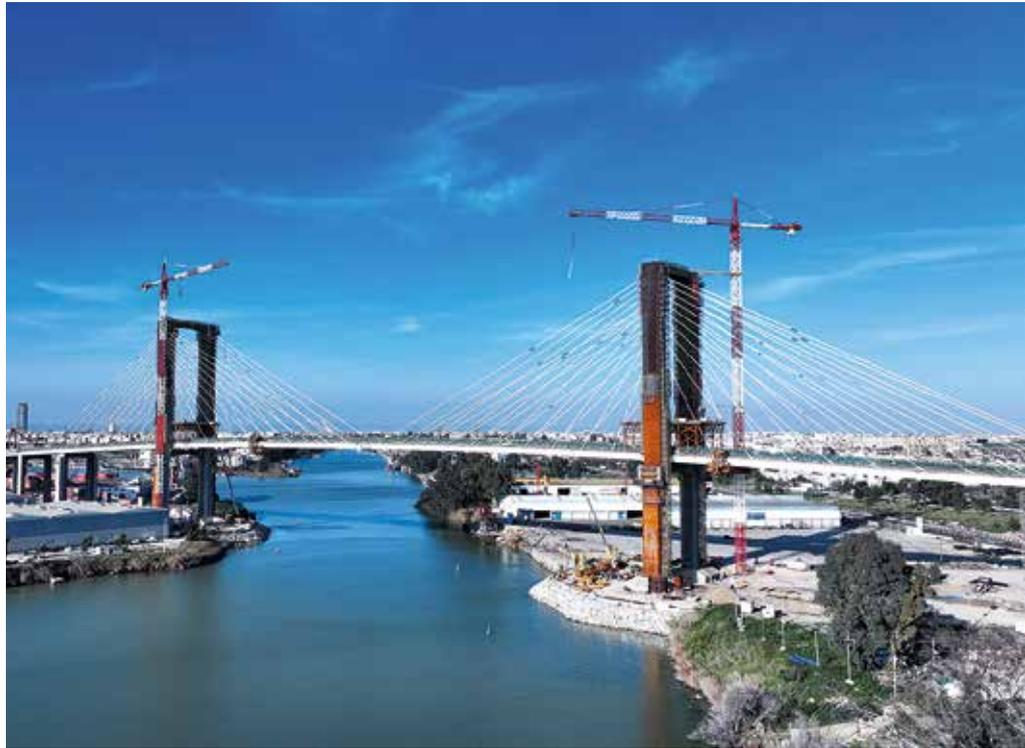
**Sanierung in Sevilla:** Insgesamt 80 Schrägseile tragen die drei Fahrspuren der „Puente Quinto Centenario“. Im Rahmen der Bauarbeiten werden die Seile getauscht und die Brücke um eine zusätzliche Fahrspur erweitert. (Foto: Liebherr)
