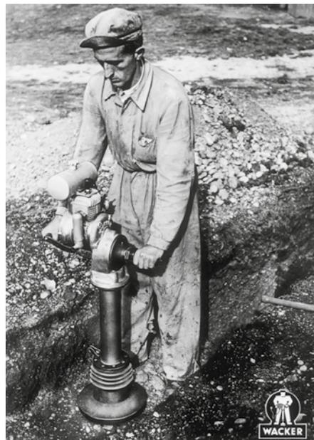
1952: Neue Möglichkeiten für den Einsatz von Stampfern ergeben sich durch den Einbau von Verbrennungsmotoren.
