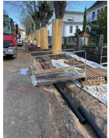
**Kurzer Prozess:** Durch das berührungslose Absaugen des Erdreichs können unterirdische Leitungen innerhalb weniger Stunden freigelegt werden.
