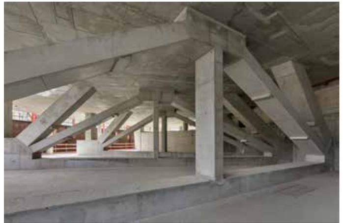
**Tragende Rolle:** Große Sprengwerke sorgen dafür, dass der untere Teil des Gasometers als stützenfreier Konferenzbereich ausgestaltet werden kann.
