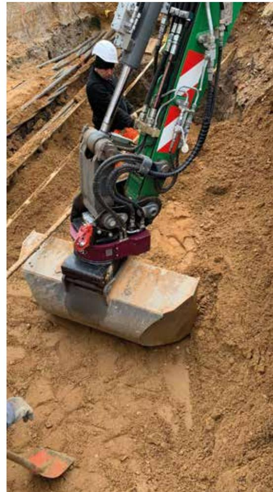
**Millimeterarbeit:** Beim Neuverlegen einer Gasleitung in 2 m Tiefe konnte das Material dank des Drehantriebs Roto Top um die anderen Leitungen herum herausgearbeitet werden. (Foto: Holp)
