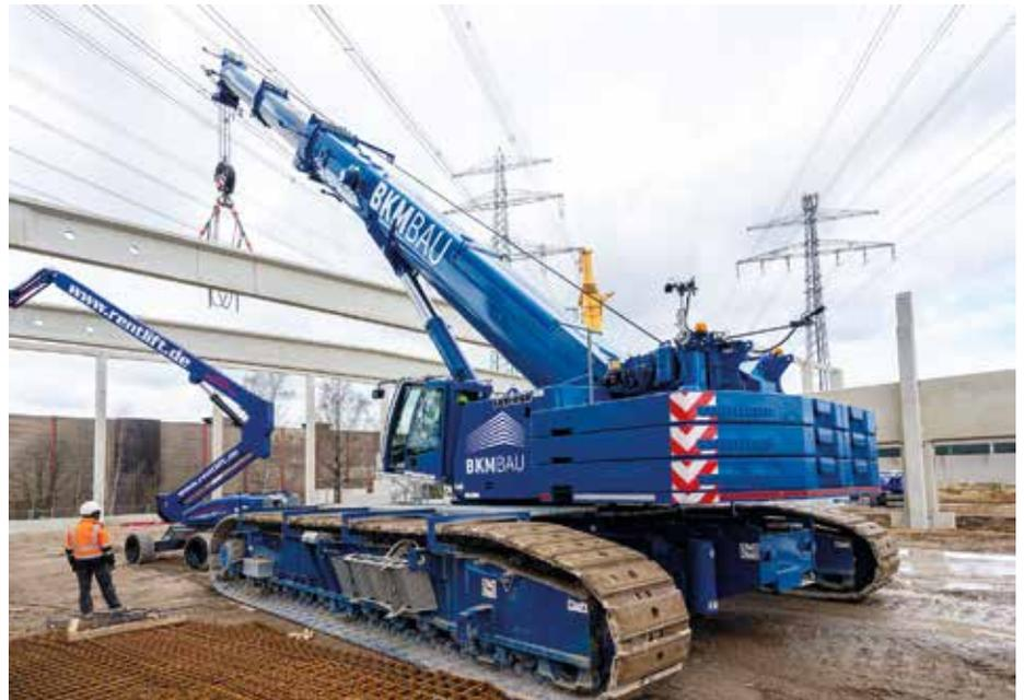
**Stramme Leistung:** 900 Betonfertigteile hat der LTR 1220 auf seiner Baustelle in Norderstedt teilweise knapp unter den Kabeln zweier Freileitungen montiert. (Fotos: Liebherr)
