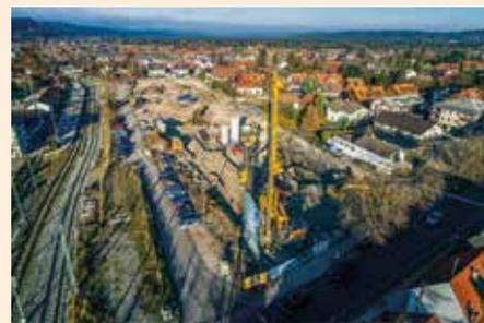
**Tief hinunter:** Bei der Erstellung der Baugrube für das neue Loisach Quartier in Wolfratshausen werden 5.500 m<sup>2</sup> statische Mixed-in-Place-Wand bis in eine Tiefe von 22,6 m hergestellt. (Foto: Bauer Group)
