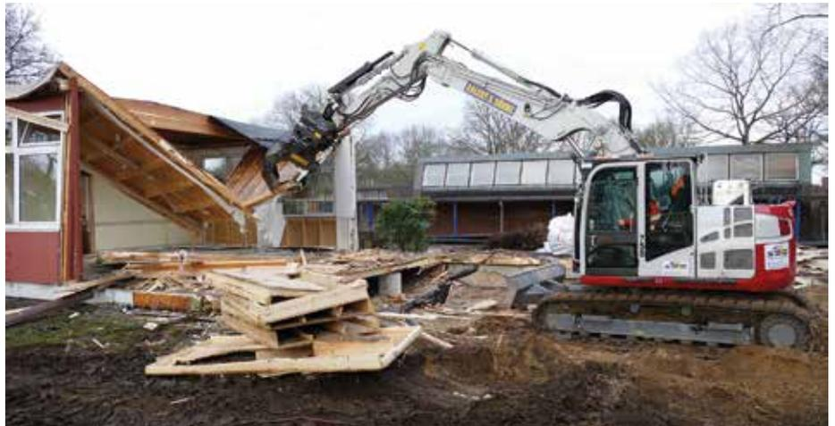
**Platz für Neues:** Der Takeuchi TB 2150 R beim Rückbau eines Schulgebäudes in Hamburg. An gleicher Stelle entsteht anschließend ein Neubau mit modernen Klassenräumen. (Foto: Wilhelm Schäfer GmbH)
