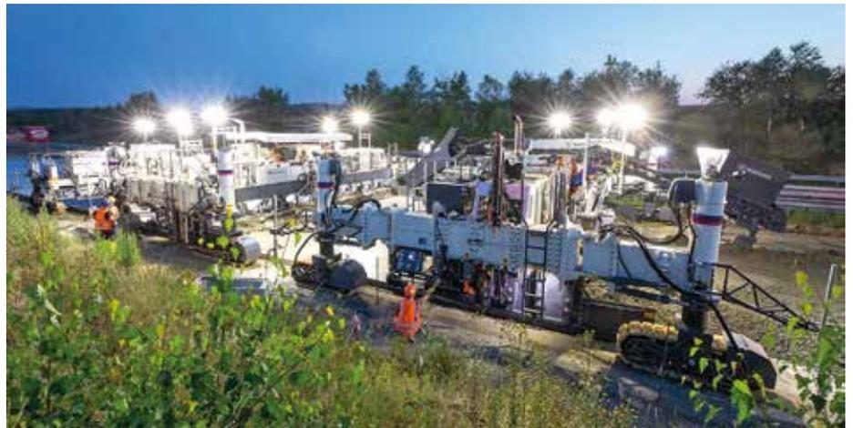
**Betonfertiger-Einbauzug:** Zwei Gleitschalungsfertiger SP 154(i) und das Nachbehandlungsgerät TCM 180(i) von Wirtgen sanieren die Autobahn D1 in Tschechien. (Foto: Wirtgen Group)
