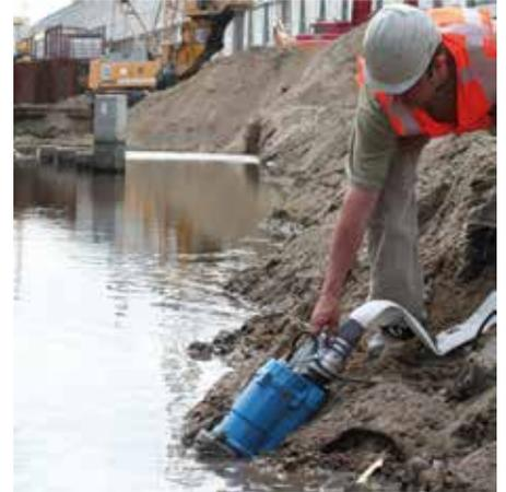
**Flexibel:** Bei langen Strecken helfen Booster-Adapter, die Wasserleitung mit mehreren Pumpen zu verlängern. (Foto: Tsurumi)
