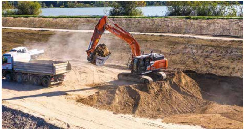
**Zuverlässig:** Auf einer Länge von 12 km hebt der ZX300-7 das neue Flussbett der Krens mit aus, legt Böschungen und Mäander an. (Foto: Kiesel GmbH)
