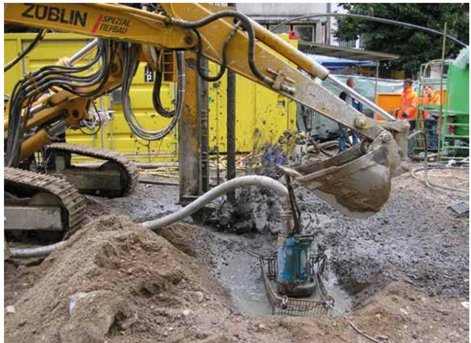
**Abrasives Fördermedium:** Auf einer Baustelle in Köln werden Boden und Zementsuspensionen mit Hilfe einer schweren Sandpumpe von Tsurumi entfernt. (Foto: Tsurumi)
