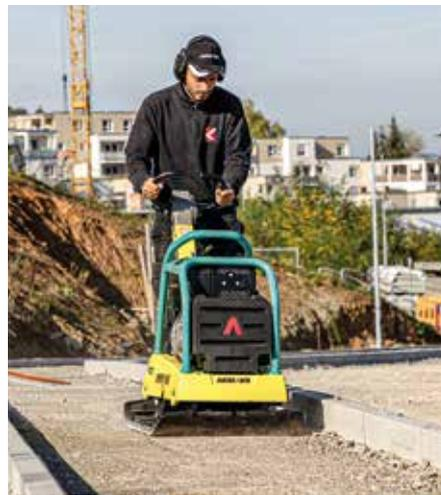
**Exakte Arbeit:** Dank hydrostatischer Steuerung lässt die APR 40/60 sich auch an engen Stellen leichtgängig führen. (Foto: Ammann)
