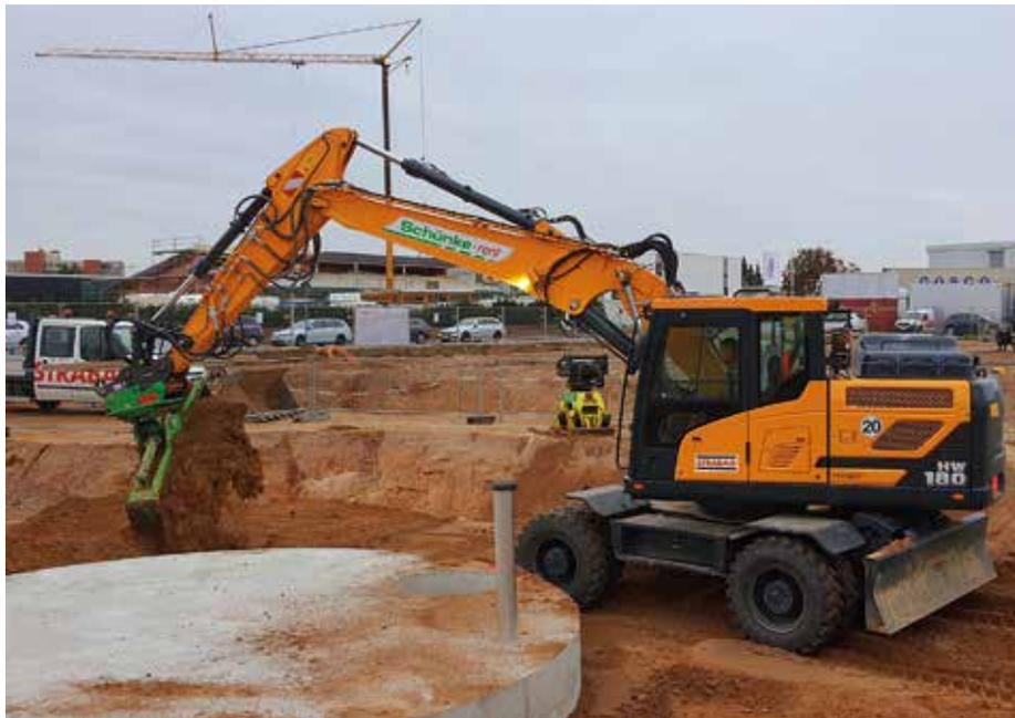
**Tiefbau-Einsatz:** Der Hyundai HW180 erledigt Erdarbeiten an den Löschwasserzisternen für das neue Gewerbezentrum in Rodgau-Weiskirchen. (Foto: HCEEIOBA)
