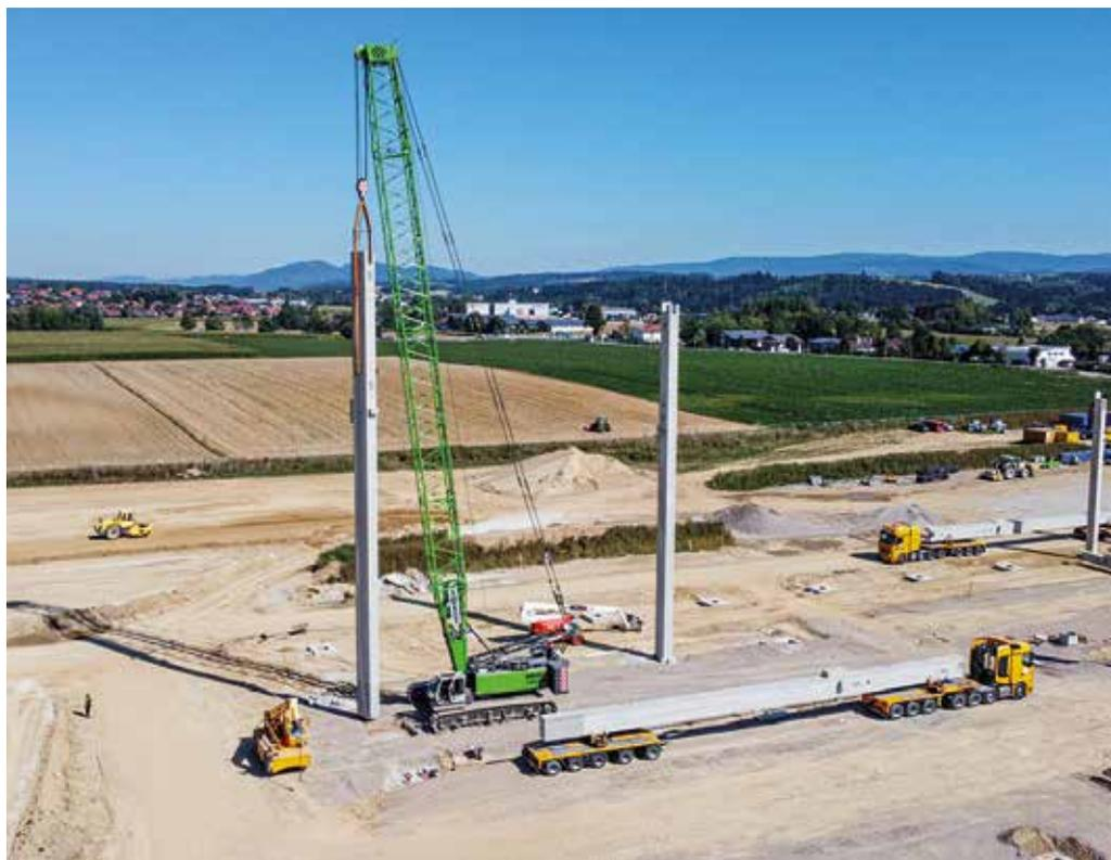
**Beweglich:** Der 180 t-Raupenkrane 5500 E fungiert beim Setzen der mehr als 27 m hohen Stahlbetonstützen auch als Pick & Carry-Maschine. (Foto: German Popp)
