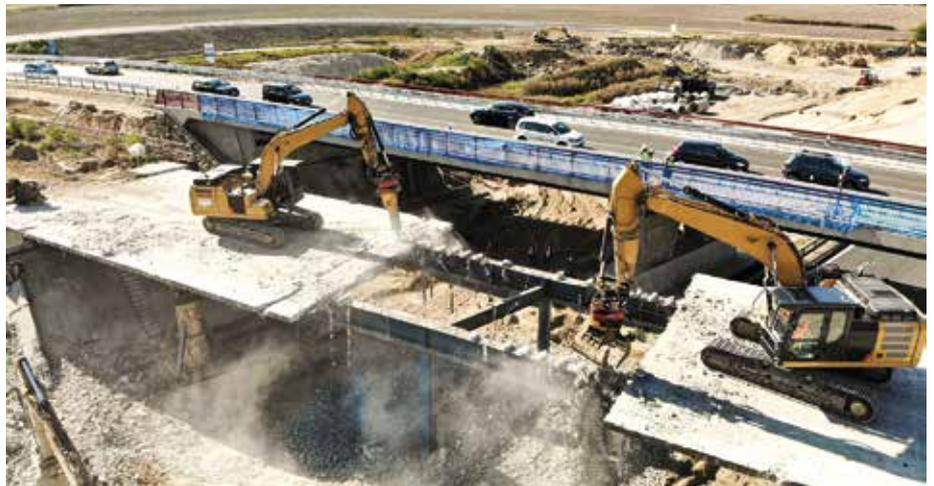
**Eingespieltes Team:** Zwei Großbagger von Bückert Bau beim Abriss der Überbauverbundplatte der Autobahnbrücke an der A10 bei Berlin. (Foto: Lehnhoff)
