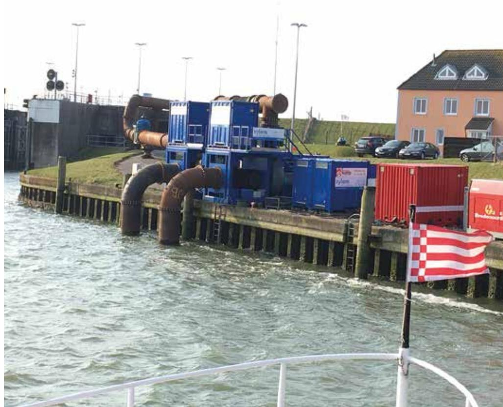
**Wasser Marsch:** Zwei Flygt C3800-Pumpen bei der Trockenlegung einer Kammer des Sperrwerkes Büsum. (Foto: Xylem)
