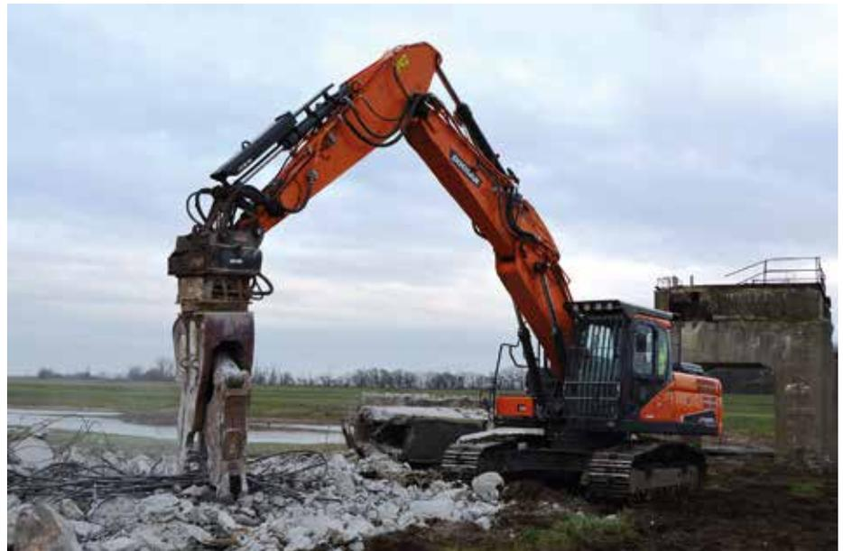
Mit 600 m<sup>3</sup> Beton musste es der Kettenbagger DX255LC-5 beim Abbruch einer Rohrbrücke in Torgau aufnehmen. (Foto: Doosan)
