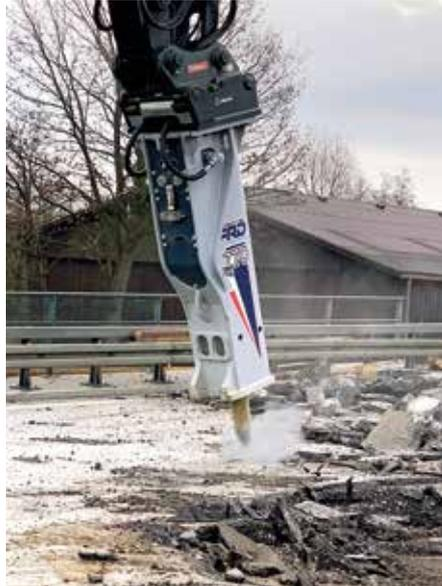
**Bei der Sanierung der A9** bricht ein FRD Hydraulikhammer Fxj 770 die Fahrbahndecke auf. (Foto: FRD)
