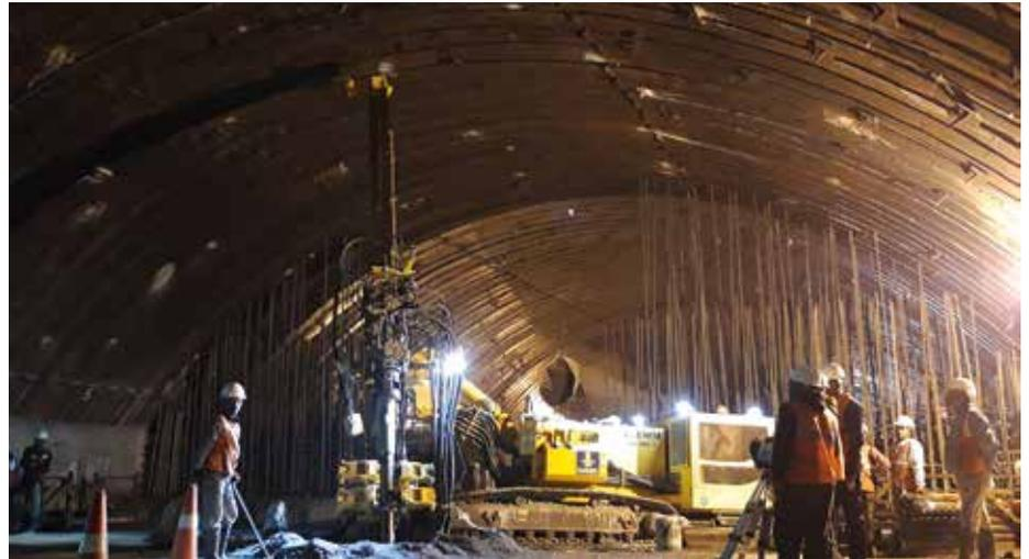
**Bis zu fünf Bohrgeräte** gleichzeitig setzt die Bauer Spezialtiefbau GmbH auf der Baustelle des Wasserkraftwerk Punatsangchhu-2 in Bhutan ein. (Foto: Bauer Group)
