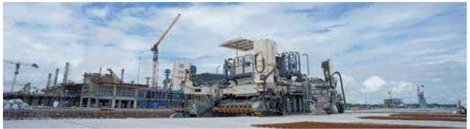
**Vier Wirtgen Betonfertiger** übernehmen auf dem YIA den präzisen und wirtschaftlichen Einbau der Betonflächen. (Foto: Wirtgen)
