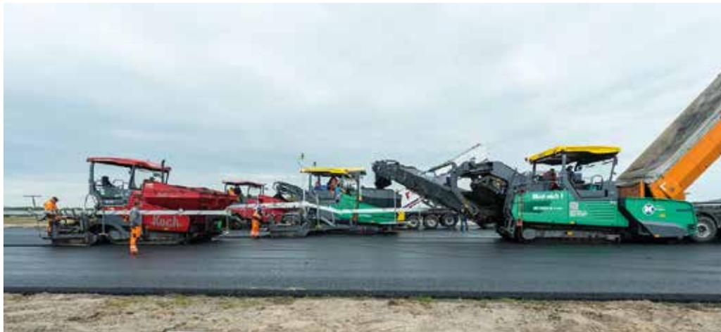
**Drei Vögele Fertiger** arbeiten heiß an heiß, die Mischgutversorgung steht dank Witos Paving Plus. (Foto: Vögele)
