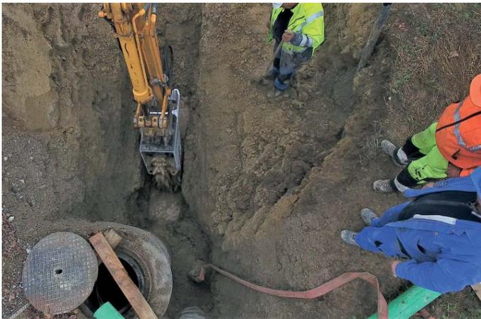
**Beim Herausfräsen** der bis zu 5 m tiefen Kanalgräben entstanden fast senkrechte Grabenwände. Dadurch sanken die Kosten für Abtransport und Neuverfüllung um ein Vielfaches.
