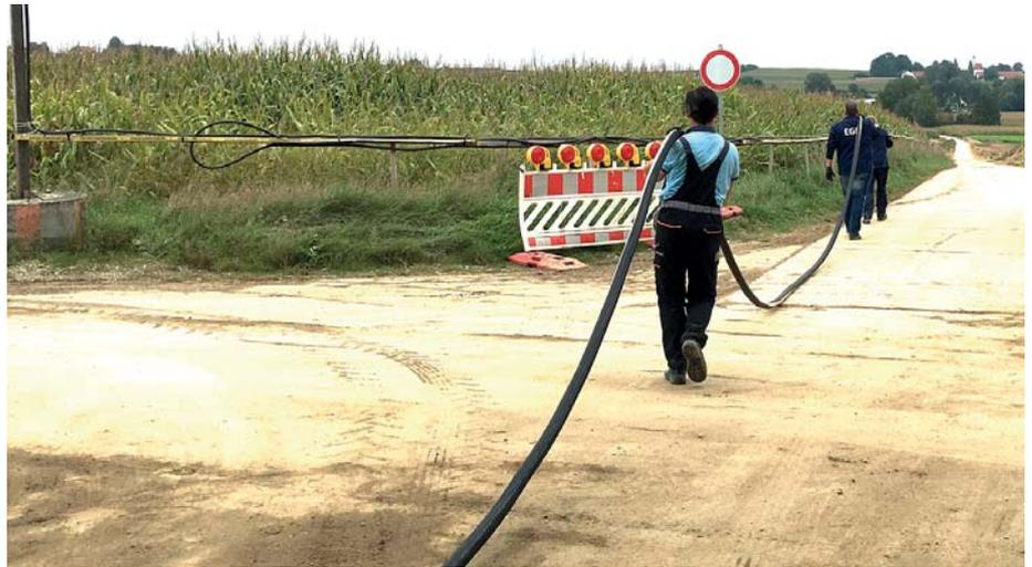
*Der Transport und die Handhabung sind aufgrund des um bis zu 60 Prozent geringeren Gewichts einfacher, das Auslegen bedarf weniger Personals und geht schneller*
