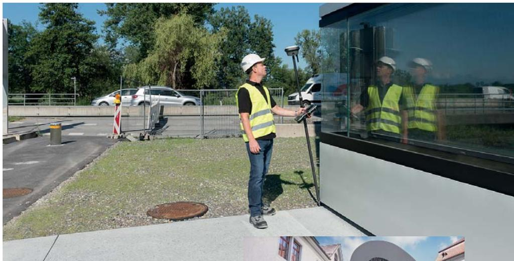
**Mit dem GS18 T** muss weder für das Aufmaß noch für die Absteckung die Dosenlibelle eingespielt werden. (Fotos: Leica)
