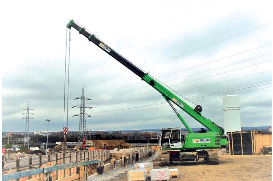
Der Raupenkran 643 R hilft unter anderem beim Bau der Pfahlwände für das Tunnelbauprojekt. (Foto: Rüko)
