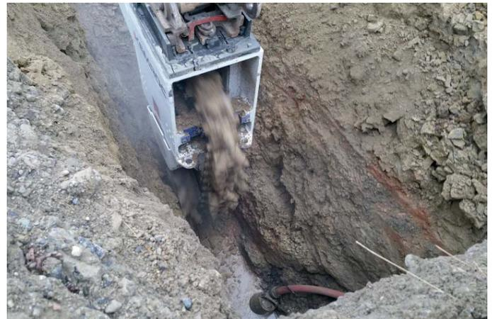
**Das Fräsgut ist feinkörnig**, homogen und lässt sich sofort wieder einbauen – das spart zusätzlich Kosten für Abtransport und frisches Material. (Fotos: Kemroc)
