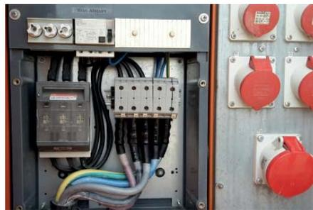
**Der Anschluss mit AlCu-Pressanschlussbolzen** in einem Endverteiler verdeutlicht die Flexibilität der Adern, die auch enge Platzverhältnisse meistert.
