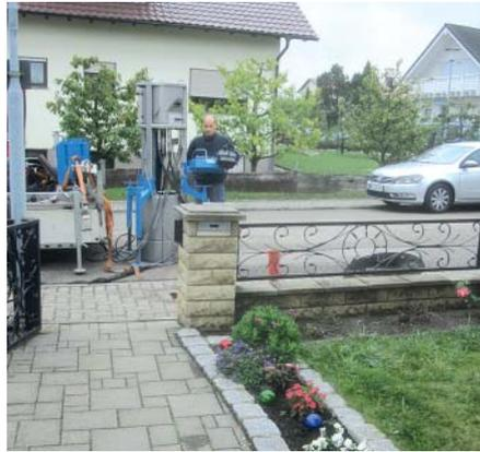
**Einsatz des Grundopit K**, mit dem Hausanschlussleitungen für Gas und Wasser aus einem kreisrunden, spannungsfreien „Keyhole“ von maximal 650 mm Durchmesser grabenlos verlegt werden.
