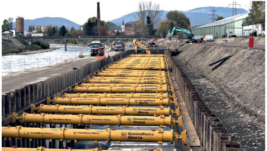
Beim Bau des zentralen Speicherkanals kommen 100 Hydraulikstreifen von Groundforce zur Sicherung der Baugrube zum Einsatz. (Fotos: Groundforce)
