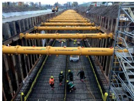
**Klassische Wanderbaustelle:** Während unter der Ausschalung gearbeitet wird, wird hinten die Baugrube mit den Stützen gesichert, die weiter vorn bereits wieder ausgebaut worden sind.
