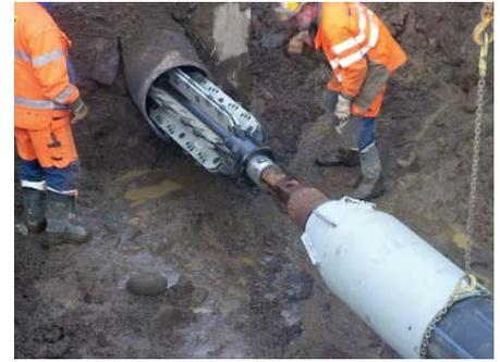
**Das statische Berstlining-Verfahren** mit Grundoburst-Systemen ist perfekt für die nachhaltige grabenlose Erneuerung von schadhaften Altrohren in gleicher Trasse.
