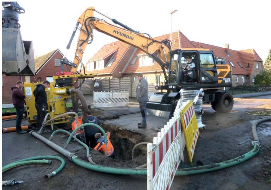
**Bei innerstädtischen Tiefbau** eignet sich die Kombination zum beschädigungsfreien Freisaugen von Versorgungsleitungen, zur Herstellung von Suchschlitzen oder Graben- und Kopflöchern sowie zur Entschlammung von Baugruben. (Fotos: Wienäber)
