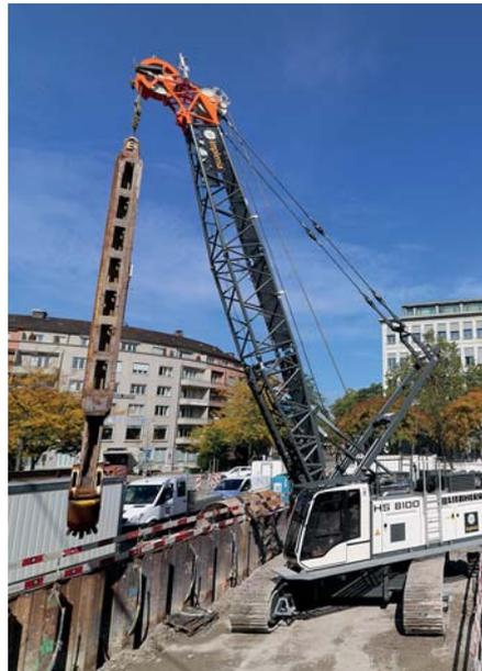
**Arbeiten mit Fingerspitzengefühl:** Der HS 8100 HD bewegt sich beim Erstellen der Schlitzwände mit seinem Greifer teilweise in einem Abstand von nur 20 cm von der Fassade der denkmalgeschützten Gebäude. (Fotos: Liebherr)
