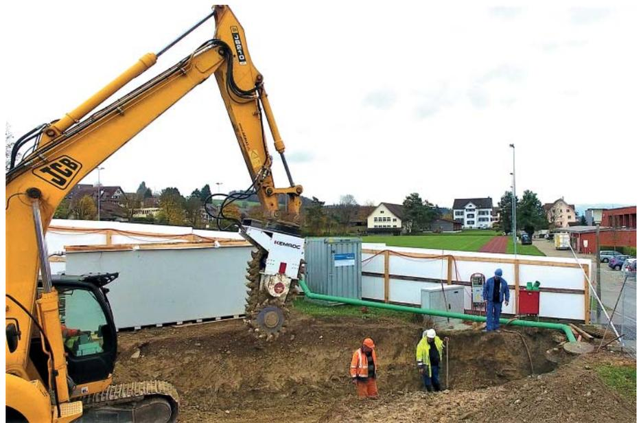
**Mit einer Kettenfräse am 22-t-Bagger** wurden für ein großes Wohnbauprojekt die Baugrubensohle profiliert, Fundamente ausgefräst sowie Kanalgräben ausgehoben.
