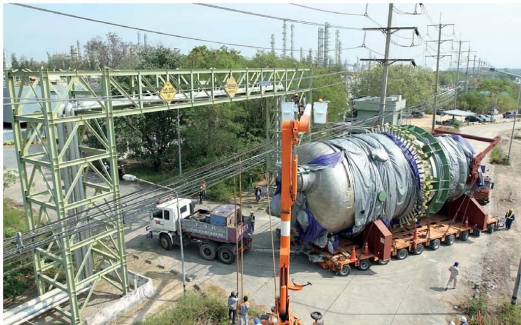
**Anspruchsvolle Transporte:** Ein 227 t schwerer Reaktor unterquert auf THP-Achslinien eine Stromleitung.
