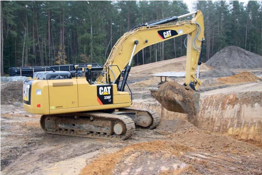
**140.000 m<sup>3</sup> Bodenbewegungen sind nötig** – die Maschinensteuerung unterstützt die Massenbewegung.
