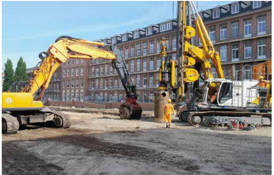
Aushub effizient verwenden: Für die Klinikum Oldenburg AÖR hat die Gollwitzer Family die Baugrube für den Erweiterungsbau des Klinikums erstellt. (Fotos: Gollwitzer)
