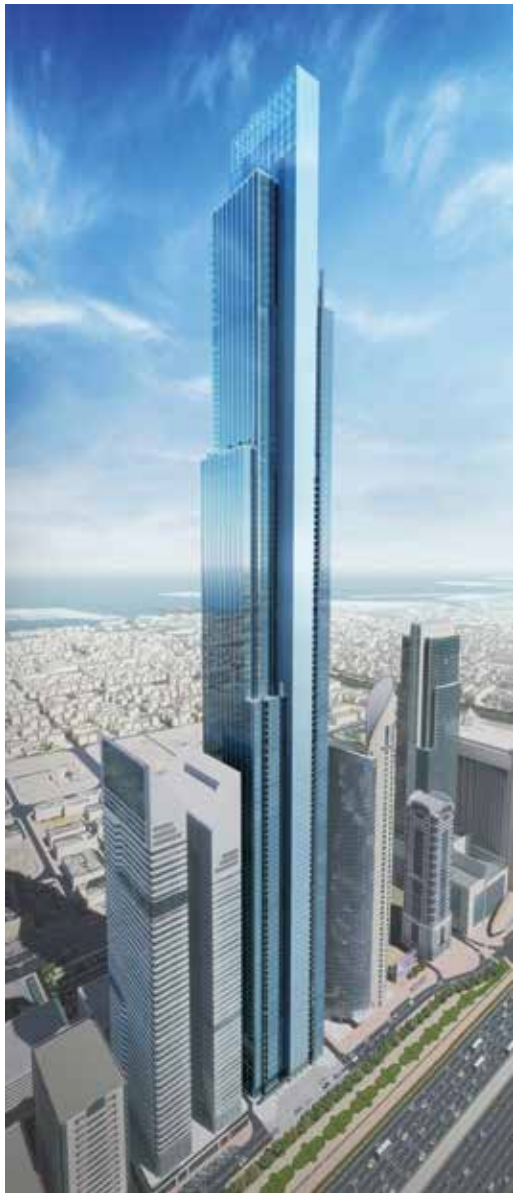
Hoch hinaus: Der Bau des Azizi-Towers, der der zweithöchste Turm der Welt sein wird, soll innerhalb von vier Jahren abgeschlossen sein. (Grafik: Azizi Developments)
