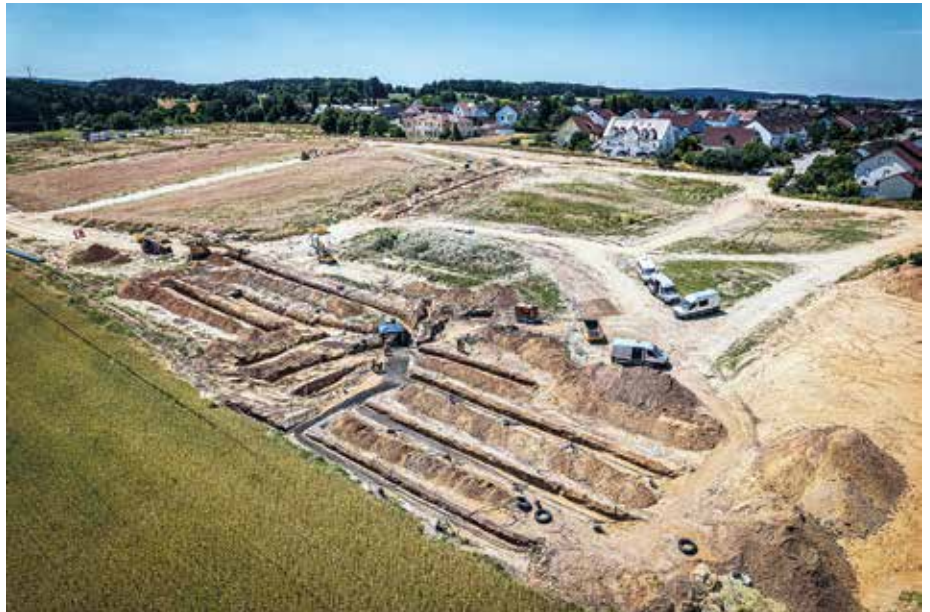
Zukunftsgewandt: Für das Neubaugebiet „Kellerbergbreite“ in Schrobenhausen hat Bauer Resources eine Erdwärmesondenanlage und ein kaltes Nahwärmenetz für insgesamt 64 Wohngebäude errichtet. (Fotos: Bauer)
