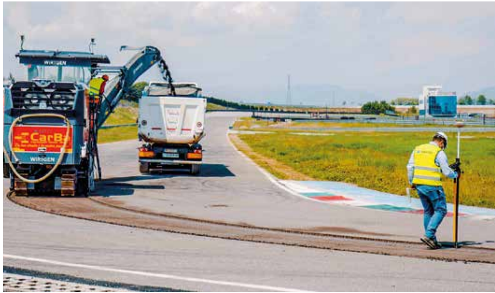
Exakte Angaben: Die Fräse liefert die wichtige Grundlage für den perfekten Fahrbahnaufbau. Mit der Topcon Maschinensteuerung wird millimetergenau nach den Modellvorgaben abgefräst. (Foto: Topcon)
