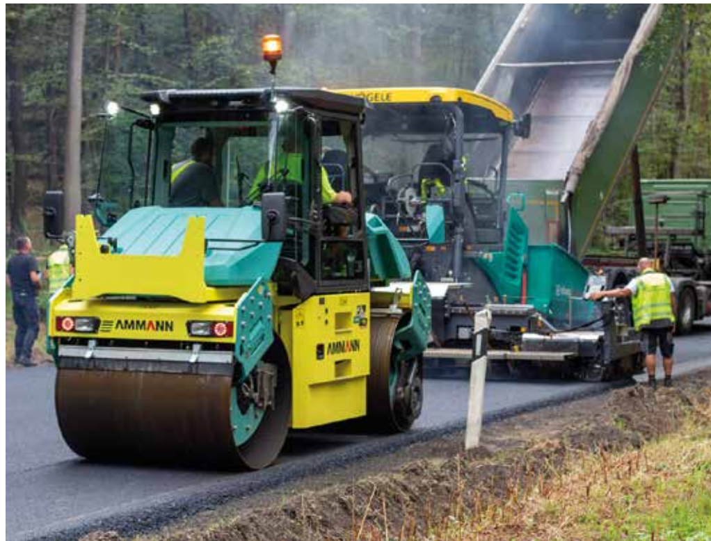
Unterbrechungsfreies Arbeiten: Dank der groß dimensionierten Wasser- und Kraftstofftanks der ARP 75 sind lange Einsatzzeiträume möglich. (Foto: Ammann)
