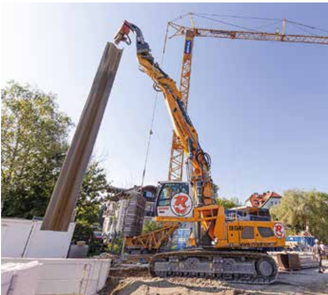
Dank seiner Hakenhöhe von 15 m ist der Raupenbagger R 956 in der Lage, auch große Spundwände zu heben. (Foto: Liebherr) Seite 46
