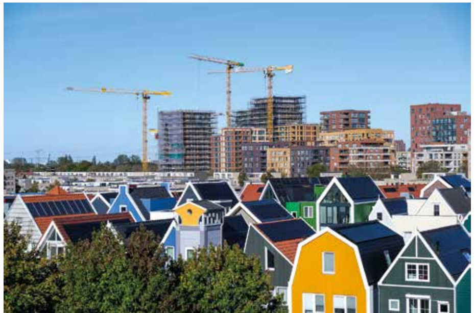
Perfekte Wahl: Die MDT-Topless-Turmdrehkrane von Potain punkten bei Baustellen mit begrenztem Platz, wie beim Wohnungsbauprojekt De Zaanse Helden in Zaandam. (Foto: Manitowoc)
