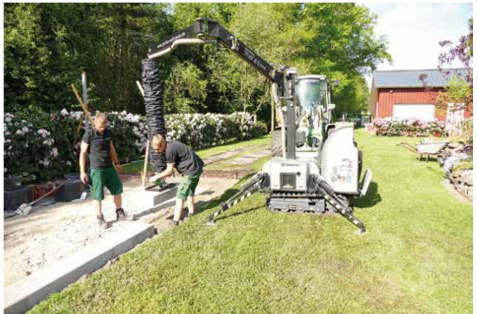
Hilfestellung: Mit dem Optimas Vacu-Mobil-Allrounder lassen sich auch 140 kg schwere Elemente leicht verlegen. (Foto: Optimas)
