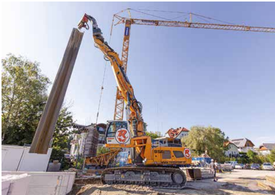
Beachtliche Reichweite: Dank seiner Hakenhöhe von 15 m ist der Raupenbagger R 956 in der Lage, auch große Spundwände zu heben. (Foto: Liebherr)
