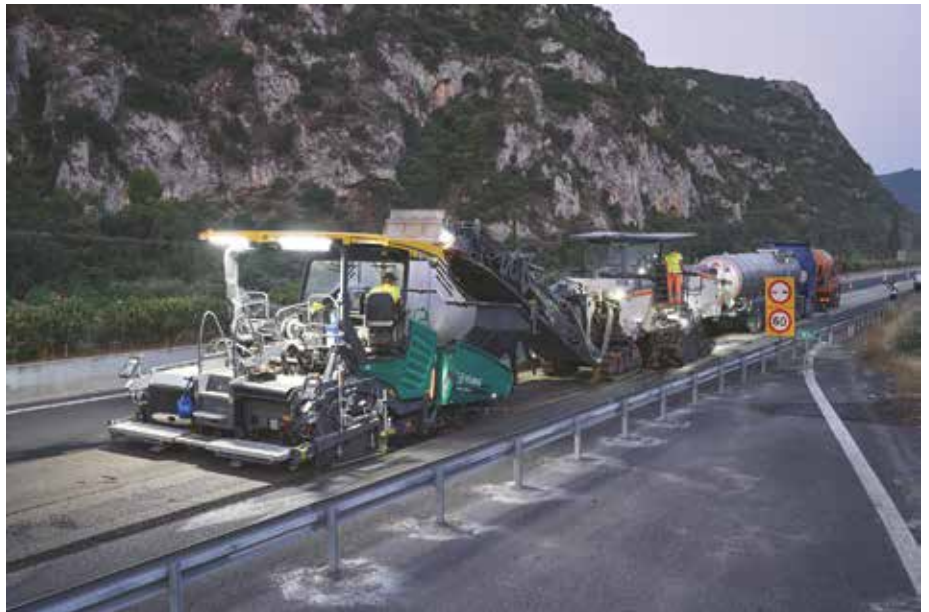
Kurzer Prozess: Bei der Sanierung eines Autobahnabschnitts in Griechenland wurde das Material in einem Arbeitsgang ausgefräst, aufbereitet, an den Fertiger übergeben und direkt vor Ort profil- und lagegerecht eingebaut. (Fotos: Wirtgen)
