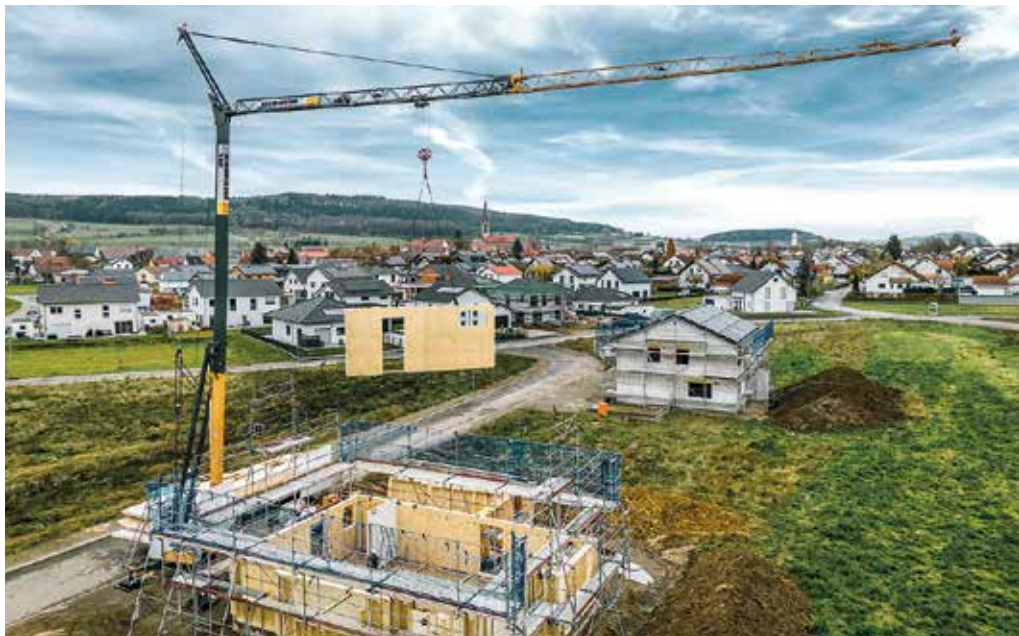
Flexibel einsetzbar: Die L-Krane von Liebherr sind prädestiniert für Hausbauten, Renovierungen und Dacharbeiten, wie hier der 25 L beim Heben von Fertigelementen. (Foto: Liebherr)
