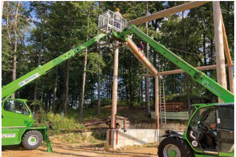
Soziales Engagement: Um Stroh und Heu besser lagern zu können, hat der Münzinghof in Zusammenarbeit mit HKL einen Unterstand errichtet, der als neue Lagerhalle dienen soll. (Foto: HKL)
