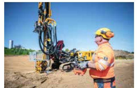
Leistungsfähig: Bohrgeräte der Klemm Bohrtechnik GmbH stellten Löcher für 119 Erdwärmesonden in bis zu 60 m Tiefe her.
