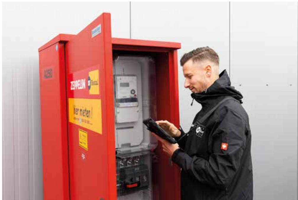
Clevere Lösung: Mit Smart Metering von Zeppelin Rental lassen sich Strom und Gas auf der Baustelle oder im Büro- und Produktionsgebäude digital zählen. Die Verbräuche sind jederzeit und überall abrufbar. (Foto: Christina Czybik / action press)
