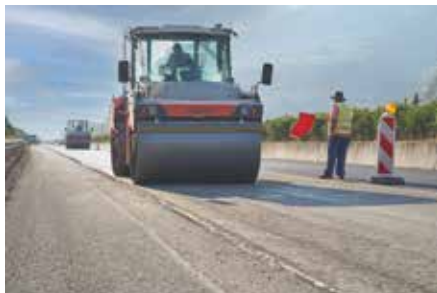
Dauerhaft stabil: Zwei Tandemwalzen verdichteten das eingebaute Material mit insgesamt sieben Übergängen.
