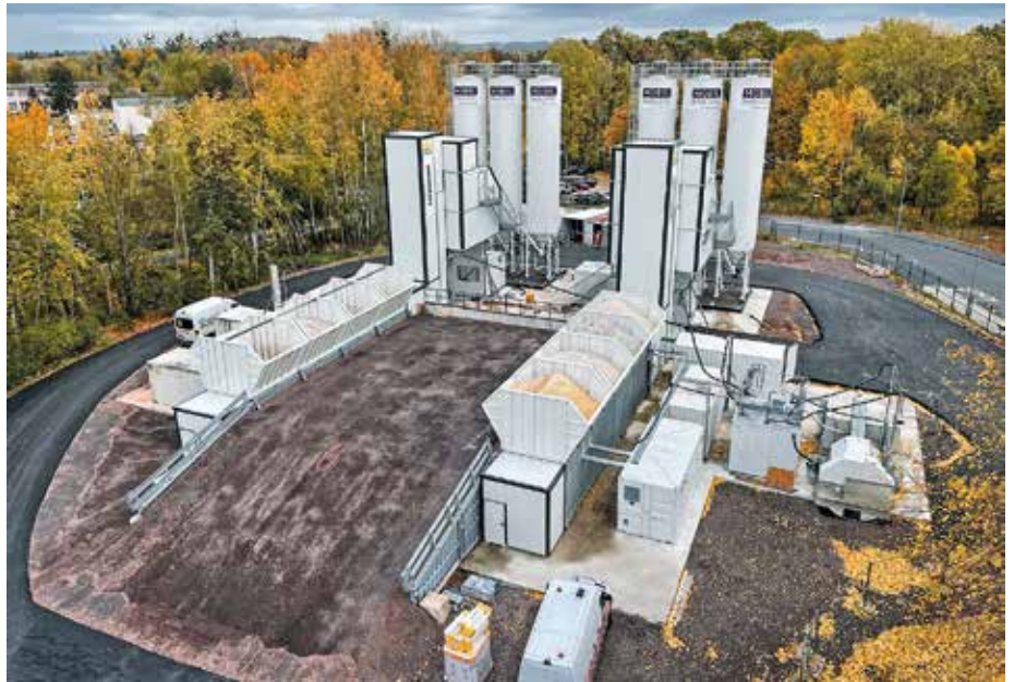
Mobile Lösung: Die Doppel-Betonmischanlage von Liebherr kann ohne weiteres von einer Baustelle zur nächsten Baustelle umgesetzt werden. (Foto: Liebherr)
