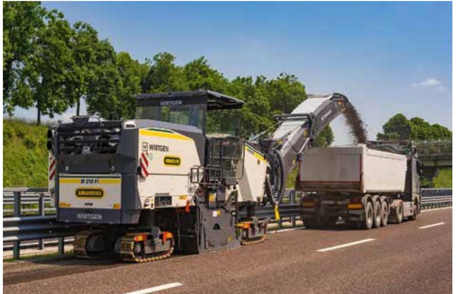
**Drei Großfräsen** W 210 Fi „fütterten“ 45 Muldenkipper bei der Instandsetzung der A31 in Italien mit Fräsgut. (Foto: Wirtgen)
