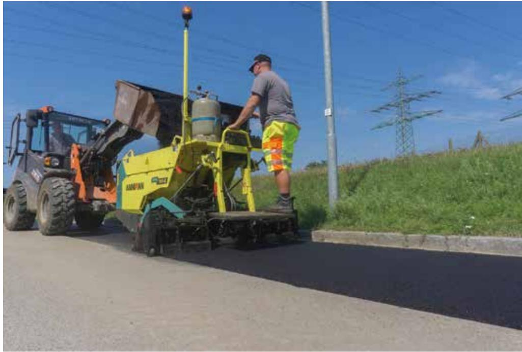
Der Minifertiger AFW 150-2 verfügt über eine Materialbunkerkapazität von 0,6 m<sup>3</sup>.
