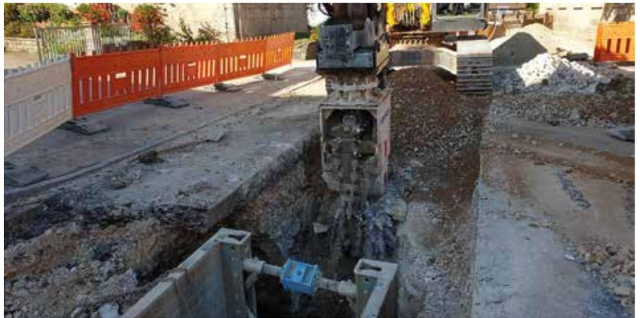
Beim Kanalbau in Steinsfeld bewährte sich eine Kettenfräse im inhomogenen Material. (Foto: Kemroc)
