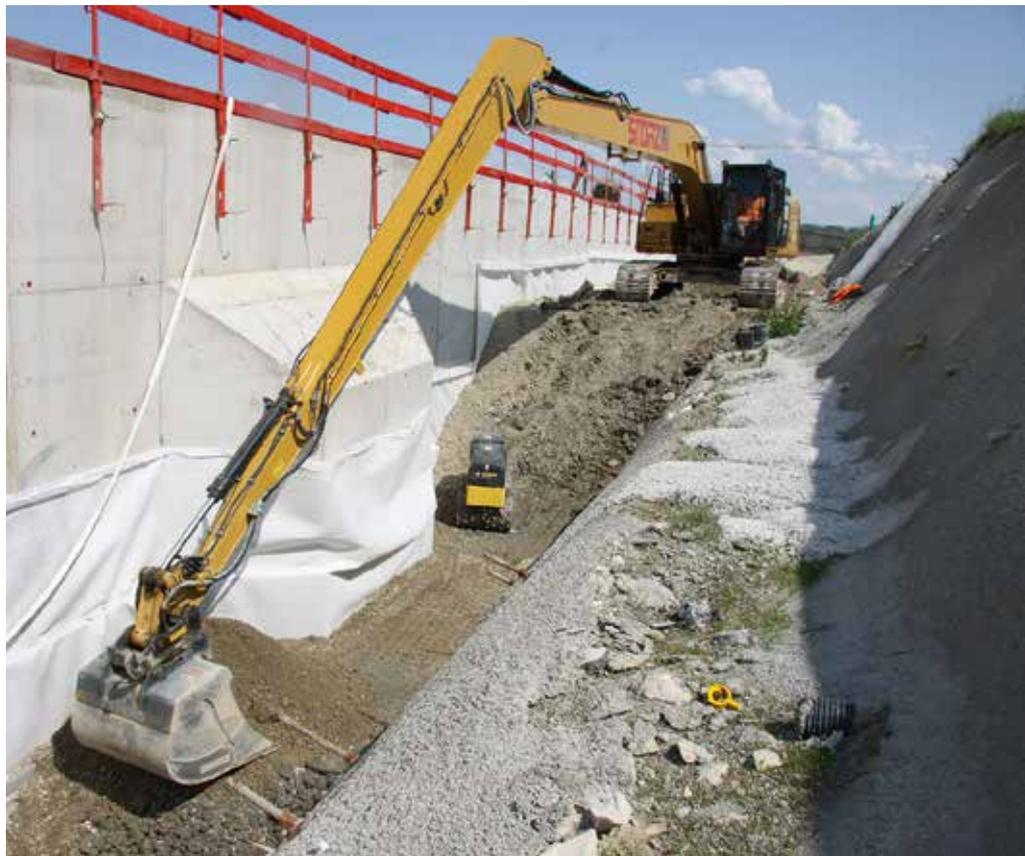
**Mit einer Reichweite von 18 m** übernimmt der Kettenbagger 326FSLR beim Bau des Wagershauser Tunnels eine Schlüsselfunktion. (Foto: Caterpillar/Zeppelin)
