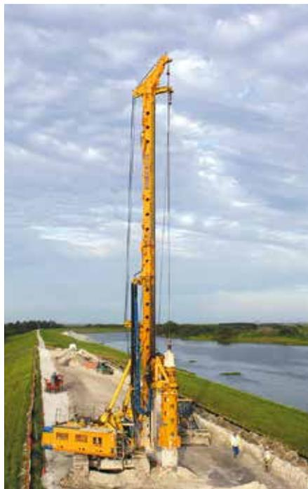
**Der Herbert-Hoover-Deich** wird durch eine rund 13,5 km lange Dichtwand gesichert. Foto: Bauer Group
