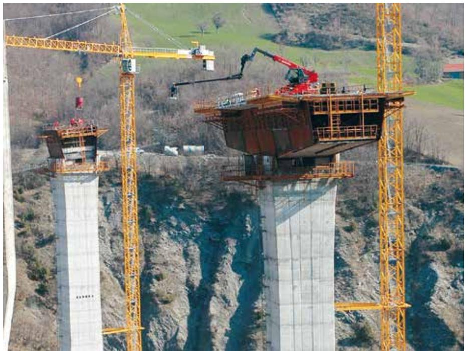
**Im Brückenbau** erweitert der Teleskoplader mit 2D Arbeitsbühne den Arbeitsradius um plus 11,6 und minus 10,4 m.
