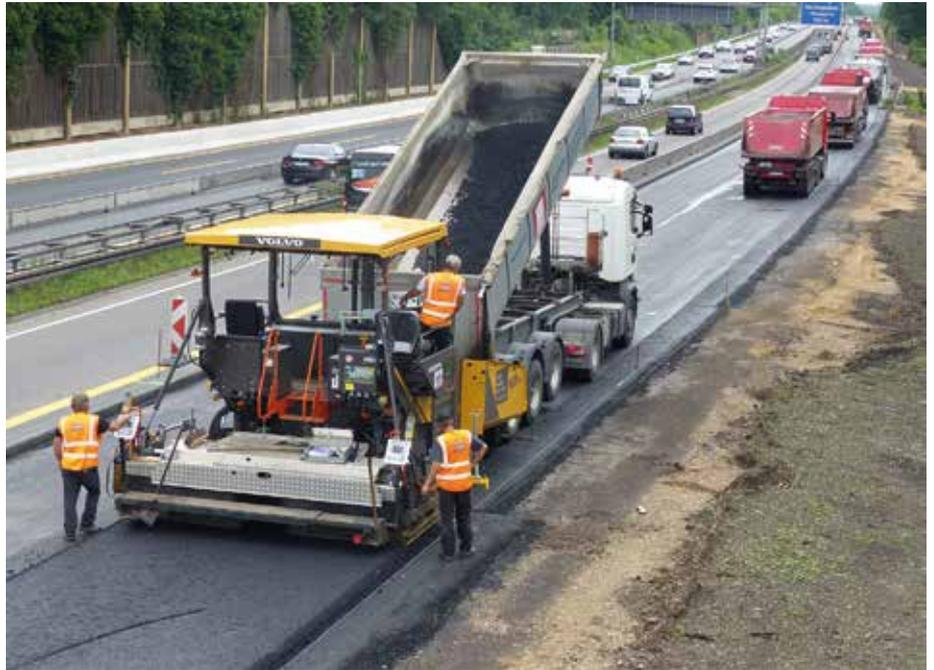
**Innerhalb von zwei Minuten** hat der P6820D den Inhalt eines 27 t-Sattelzuges eingebaut. Die Lkw stehen Schlange, um einen kontinuierlichen Einbau zu ermöglichen.
