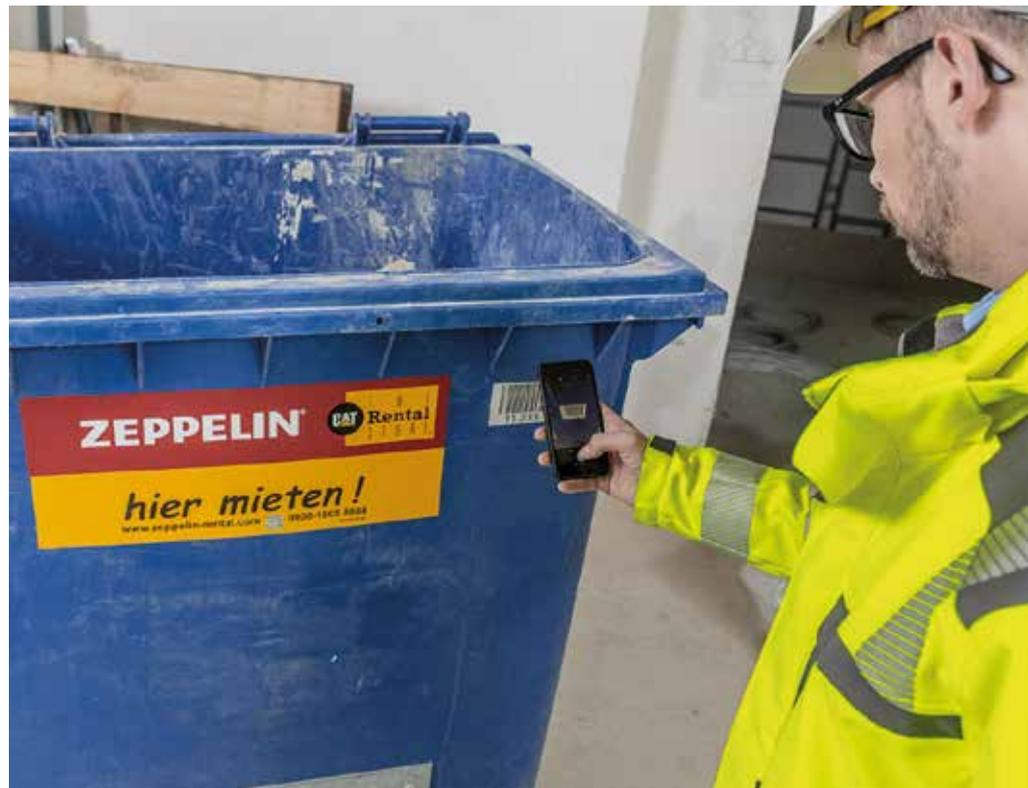
**Verursachergerechte Entsorgung:** Die Sammelbehälter werden mithilfe von Barcodes exakt einem Gewerk zugeordnet. (Foto: Reiner Freese)
