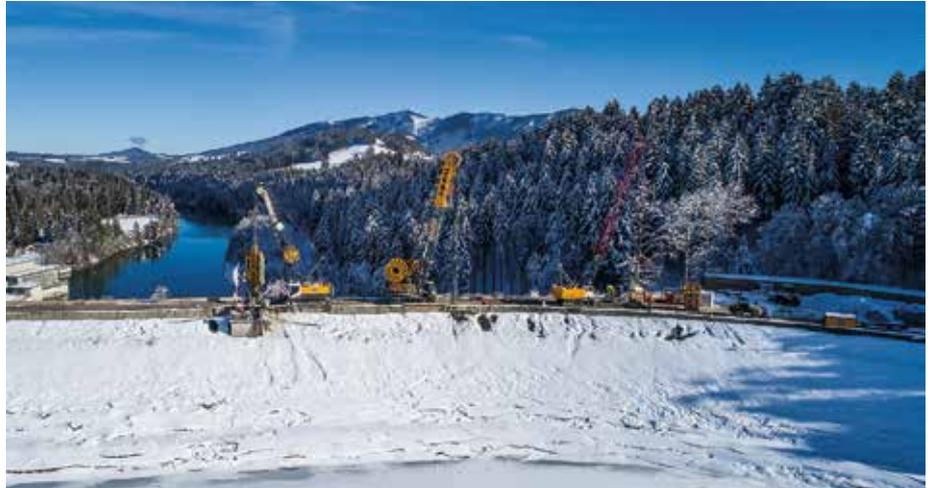
**Im 24-Stunden-Betrieb** hat Bauer die 13.500 m<sup>2</sup> große Schlitzwand zur Abdichtung des Damms hergestellt. (Foto: Bauer Group)
