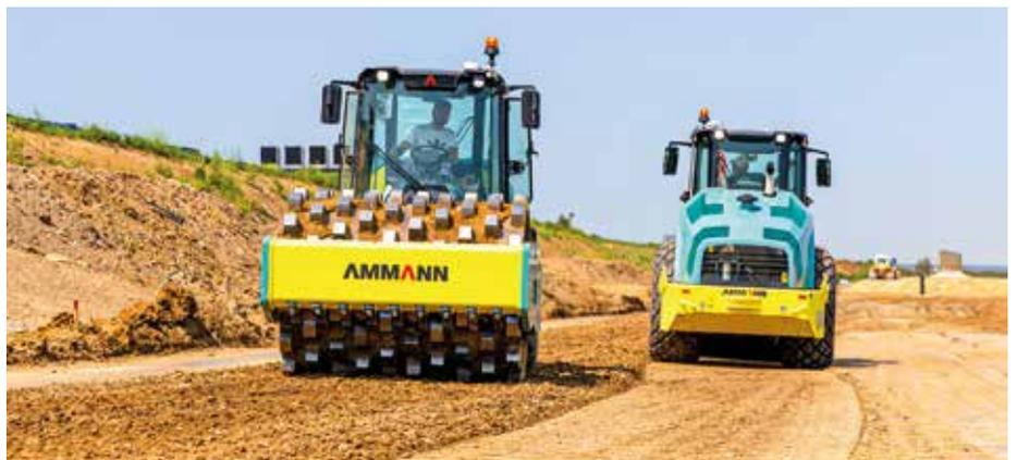
**Die Walzenzüge** der ARS-Baureihe sind beim Bau der ICE-Strecke bei Stuttgart mit dem Dokumentationssystem Q Point ausgestattet.
