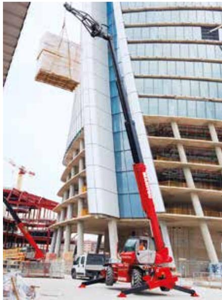
**Drehbare Teleskoplader** erreichen eine Arbeitshöhe von über 30 m und Hubkapazitäten bis zu 9 t. (Fotos: Manitou)
