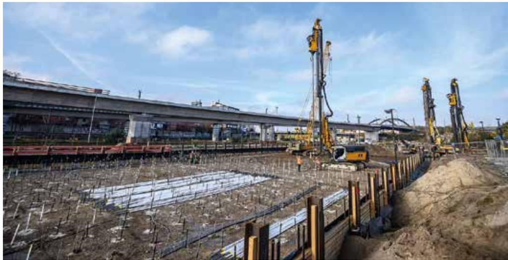
**Mittels Silikatgelsohle (LWS-Sohle)** wird die rund 16.000 m<sup>2</sup> große Baugrube im neuen Berliner Quartier Heidestraße abgedichtet. (Foto: Bauer Group)
