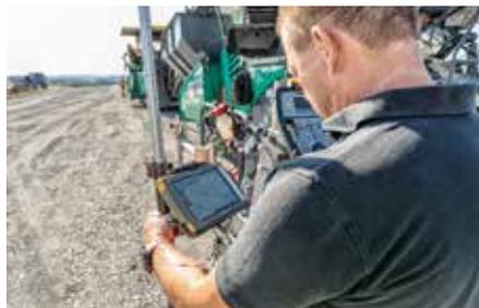
**Perfektes Ergebnis:** Die Kontrolle mit dem Topcon-Roverstab bestätigt den gelungenen Einbau.
