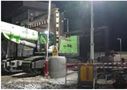
**Maßarbeit:** Das Befahren der Rampe und die Gleisquerung musste wegen der geringen Höhe mit einteleskopiertem Unterwagen erfolgen. Mit dem Ausleger in der Waagerechten ergab sich eine Gesamtlänge von 15,29 m.
