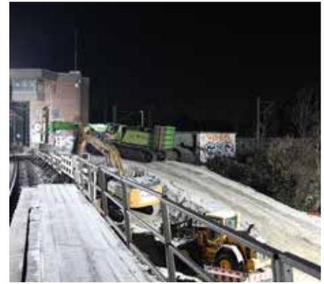
**Steil:** Aufgrund der engen Situation musste eine Rampe mit einer Steigung von 35 % errichtet werden, die der Kran erfolgreich meisterte.
