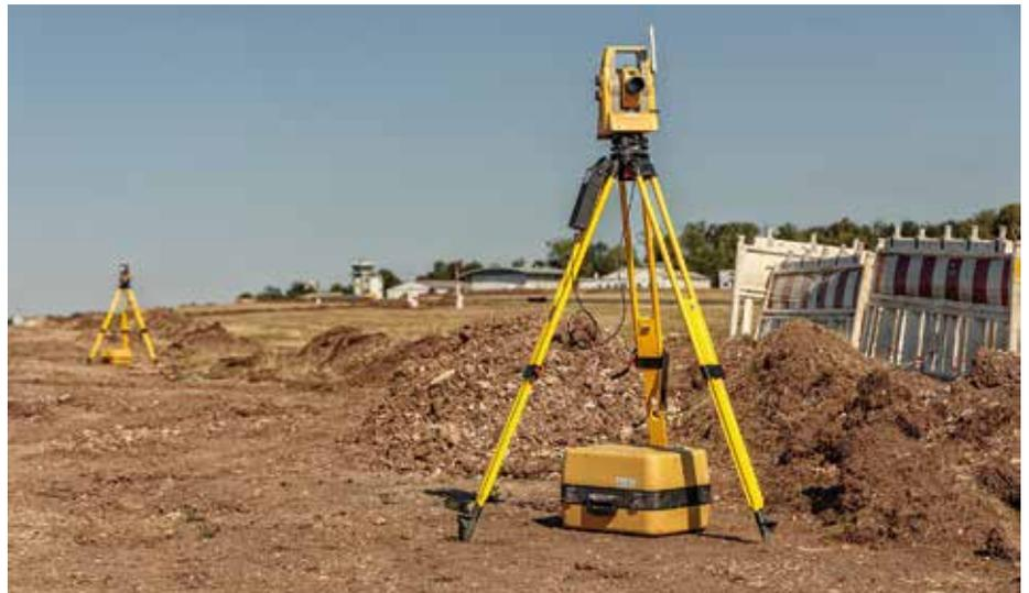
**Alles unter Kontrolle:** Drei Topcon-Tachymeter steuern den Sanierungsprozess am Flughafen Coburg fortlaufend und exakt nach Sollmodell. (Topcon Deutschland Positioning GmbH)
