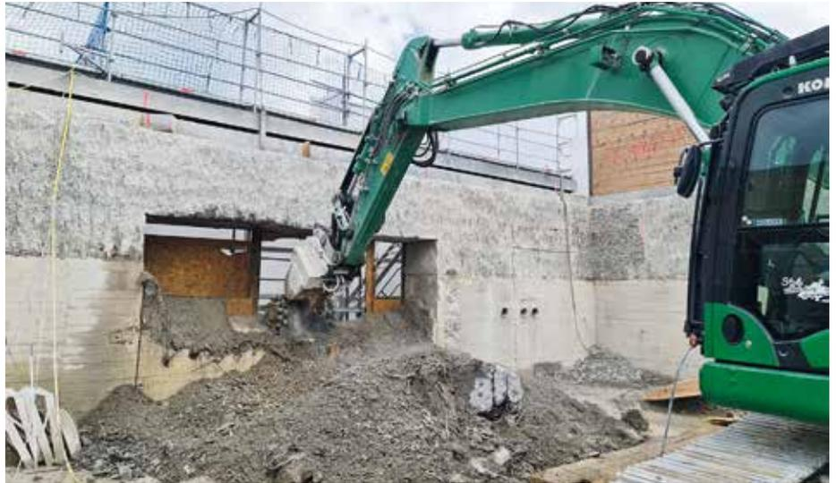
**Umwidmung:** Aus einem Weltkriegsbunker in Hamburg-Winterhude wird Wohnraum. Mannshöhe Fensteröffnungen entstanden durch Verwendung einer Seilsäge, der Kemroc-Querschneidkopffräse KR 165 und einer Abbruchscherer am 35-t-Kettenbagger. (Foto: Kemroc)
