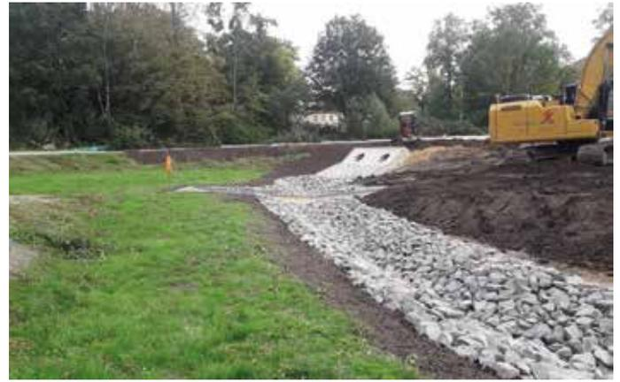
**Bauvorhaben Lehnshede:** Bei einem Projekt in Visselhövede nutzte die Firma Eimer Bau Moba-3D-Steuerungen für Aushubarbeiten und Profilierung der Böschung mit dem Bagger (Dual-GNSS). Zudem erfolgten die Herstellung der Sohle und das Vorbauen des Schotters in der Umfahrung mit der Raupe (Dual-GNSS) und des Feinplanums der Umfahrung mit dem Grader (Tachymeter). (Fotos: Moba)
