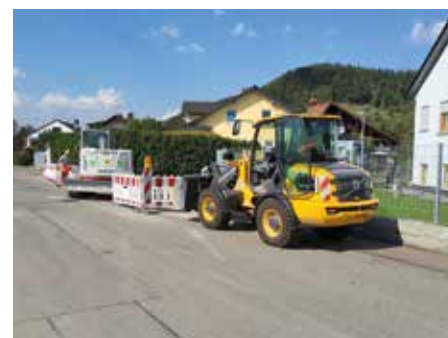
Praxistauglichkeit bewiesen: Bei der NETZbaustelle in Rangendingen hat Leonhard Weiss ausschließlich elektrisch angetriebene Maschinen eingesetzt. (Foto: Leonhard Weiss)
