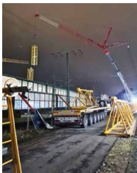
Perfektes Zusammenspiel: Während je ein Team von BKL tagsüber die Teile vormontierte, führten zwei weitere Teams nachts die Hebearbeiten sowie den finalen Aufbau der beiden Obendreher durch.
