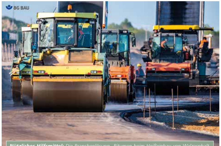
Nützliches Hilfsmittel: Die Branchenlösung „Bitumen beim Heißeinbau von Walzasphalt“ ist veröffentlicht worden. (Foto: i-Stockr / Getty Images)
