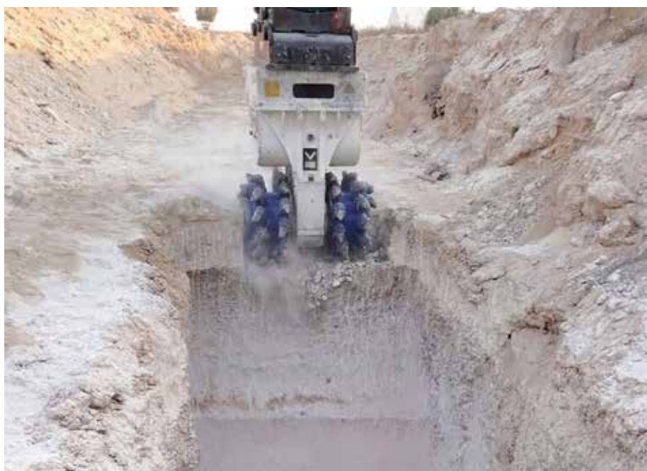
Zuverlässige Leistung: Die Querschneidkopffräse Kemroc KR 120 hat sich beim Schneiden von Hartkalkstein in Dubai bewiesen. (Fotos: Kemroc)
