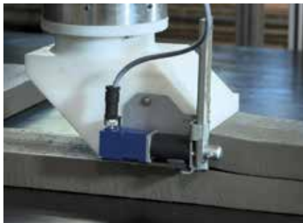
Großes Potenzial: Der Beton-3D-Druck nimmt Fahrt auf. (Foto: TU Dresden, Institut für Baustoffe)
