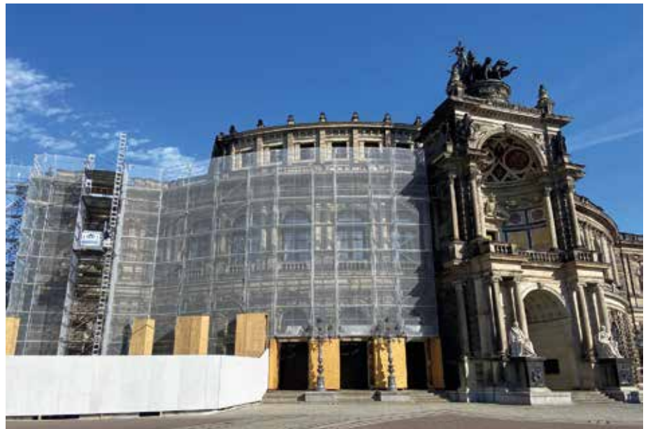
Zügiger Baufortschritt: Die Transportbühne Geda 500 Z/ZP wird bei der Sanierung der Dresdener Semperoper zum Transport von Material und Personen eingesetzt. (Foto: Geda GmbH)
