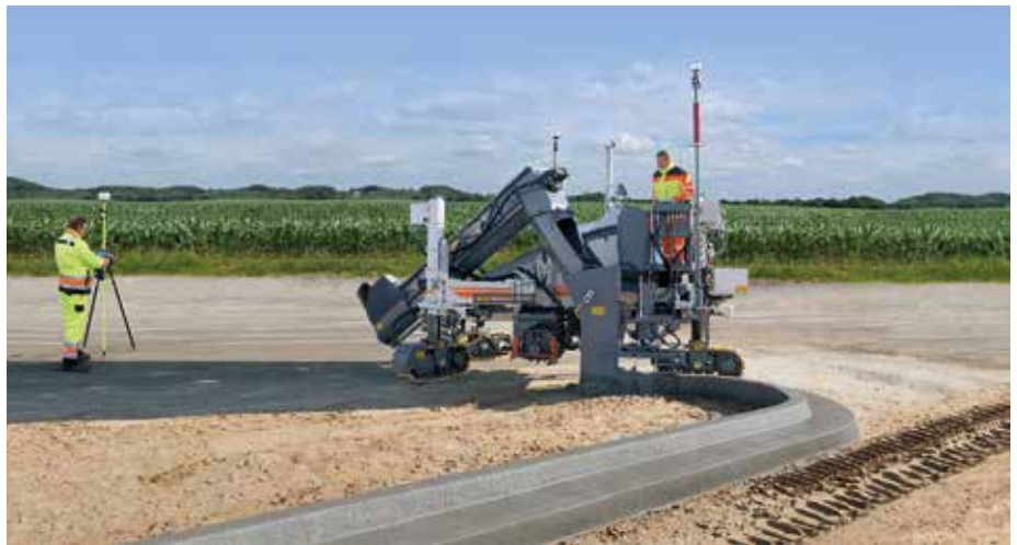
Meilenstein: Die leitdrahtlose Steuerung mit 3D-System wird erstmals beim Bau der ICE-Strecke Frankfurt-Köln im Jahr 1999 eingesetzt. (Fotos: Wirtgen)
