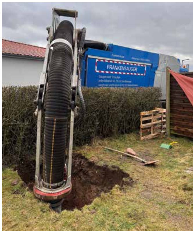
Hecken bleiben stehen: Reparaturen an im Garten verlegten Leitungen kann der Saugbagger ohne Beschädigungen der Gartenanlage ausführen. (Foto: MTS)
