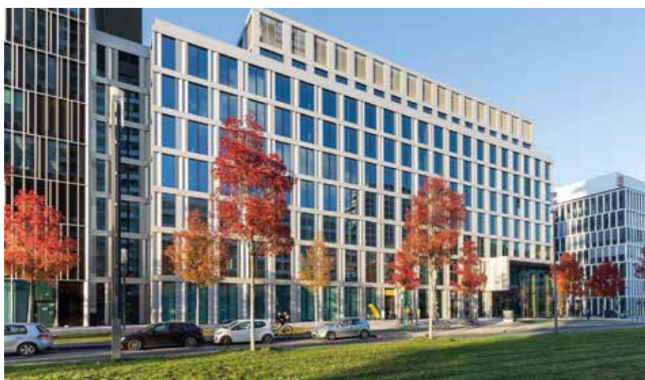
Innovativ: Die Porr hat neue Büroräume im „Timber Pioneer“, Frankfurts erstem Bürogebäude in Holz-Hybrid-Bauweise, bezogen. (Foto: UBM)
