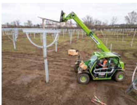
Neubau: Eine Teleskopmaschine von HKL übernahm Transportarbeiten bei der Errichtung eines Solarparks in Brandenburg.
