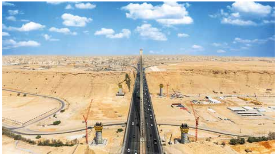
Großprojekt bei Riad: Die Wadi-Laban-Brücke wird um zwei neue Schrägseilbrücken ergänzt und soll die Reisezeit in diesem Abschnitt um 75 % verkürzen. (Foto: Wolffkran)
