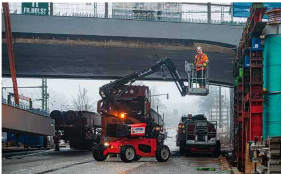
Sanierung: Mehrere HKL Arbeitsbühnen unterstützten bei Arbeiten an der Berlinertordammbrücke in Hamburg. (Fotos: HKL)
