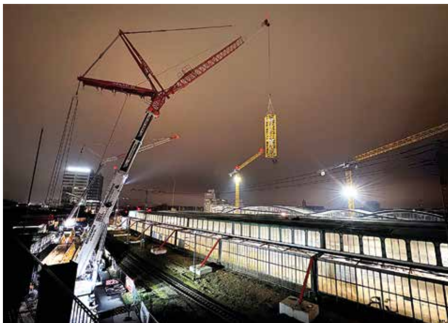
Termingerechter Aufbau: Gerüstet mit einem 49 m Wippausleger und Y-Abspannung hebt ein GMK6450-1 die bis zu 16,8 t schweren Kranteile über die Störkante in Form einer Speiseleitung hinweg in das Bahnhofsgebäude. (Fotos: BKL)
