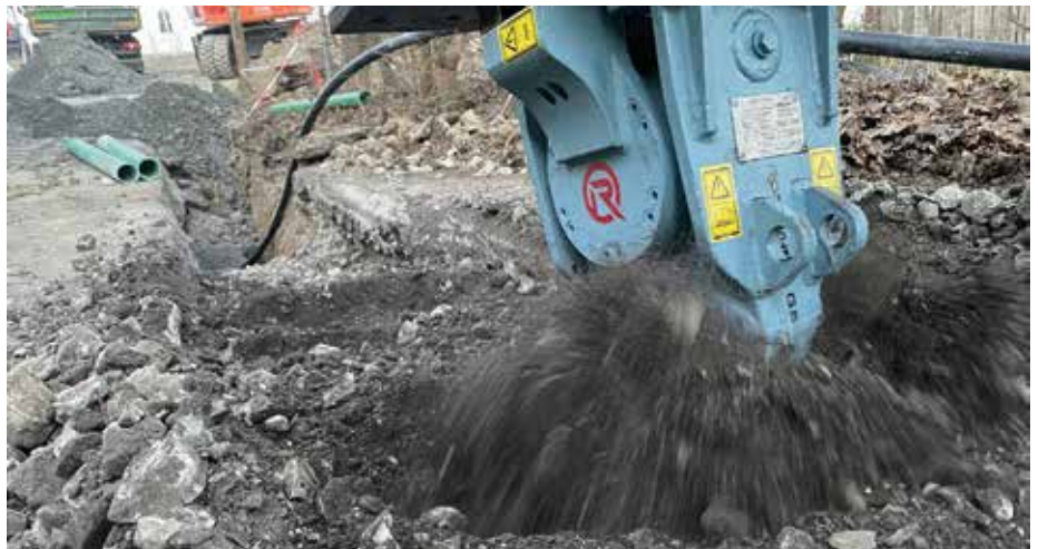
Gezieltes Abfräsen: Im Zuge eines Neubauprojekts musste ein rund 150 m langer Graben hergestellt werden. Mit der Rockwheel G5 konnte eine Breite von 50 cm erreicht werden, ohne unnötig viel Material zu lösen. (Foto: Rockzone)
