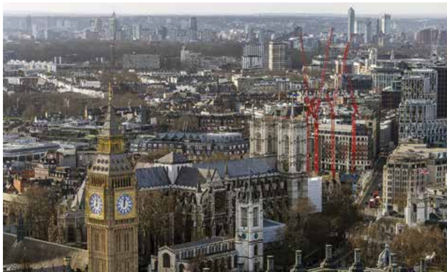
Für Wolffkran zählt das Projekt 1 Victoria Street zu den technisch anspruchsvollsten Baustellen im Zentrum Londons. (Foto: Neil McAleer Photography)
