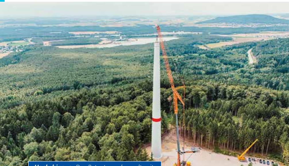
Hoch hinaus: Der Betonturm der weltweit höchsten Serien-Windenergieanlage an Land bei Sengenthal ist fertiggestellt. Die Anlage wird eine Nabenhöhe von 199 m erreichen. (Foto: Firmengruppe Max Bögl, Florian Paul)
