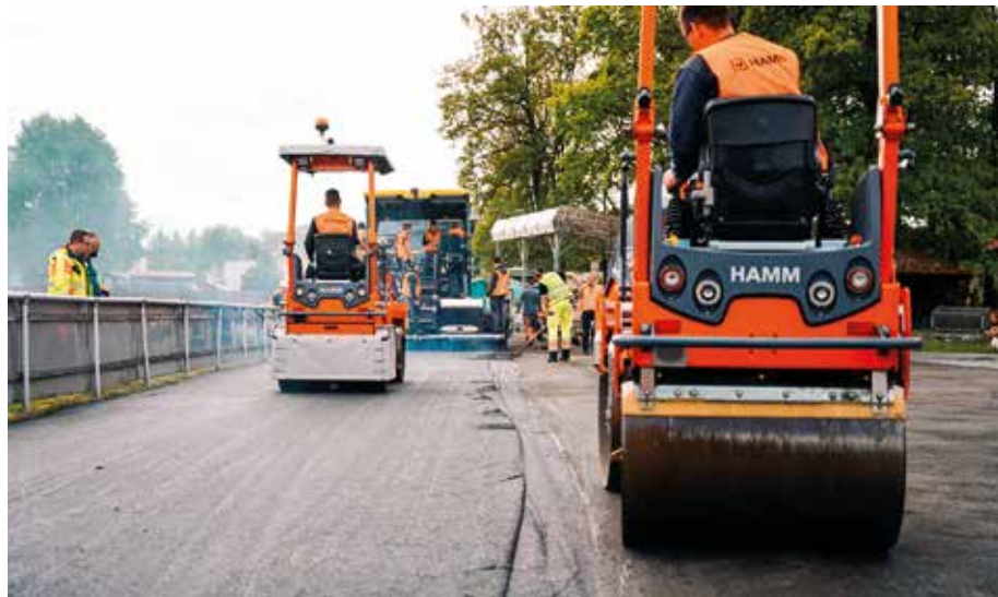
Selbst ist der Azubi: Die Teilnehmenden der Azubi techdays bedienen die beiden Hamm Walzen, um die Fläche zu verdichten und für eine hochwertige Asphalt-Oberfläche zu sorgen. (Fotos: Wirtgen)
