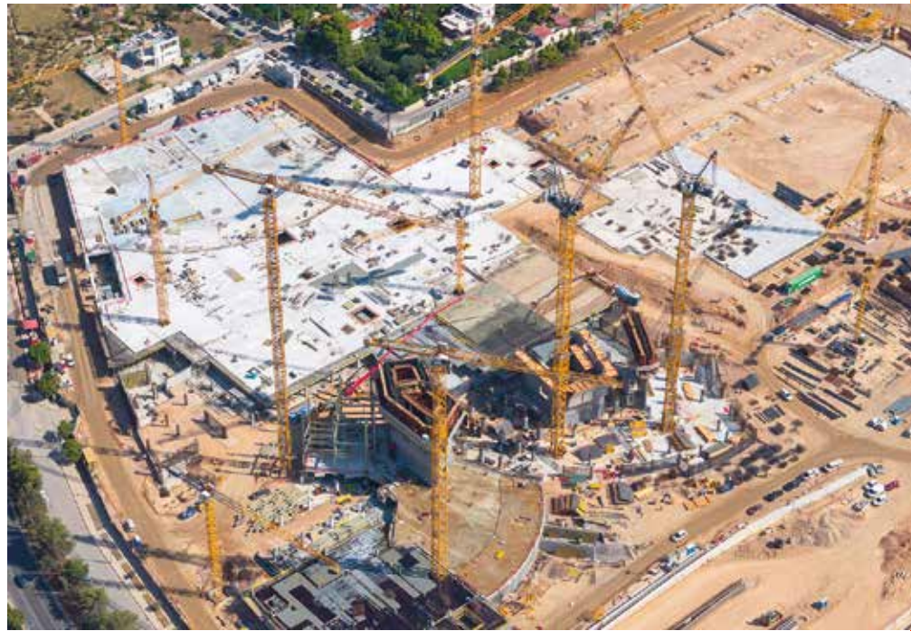
Ambitioniert: Die Bauarbeiten haben im März 2025 begonnen und sollen bis Dezember 2028 abgeschlossen sein.
