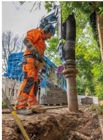
Typische Saugbagger-Aufgabe: Das schonende Freilegen von Wurzelwerk.
