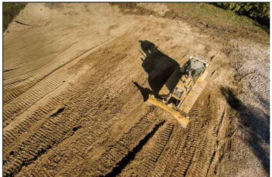
Vereinfachter Workflow: Mittels Drohnen erfasste Daten erleichtern Designänderungen, die innerhalb weniger Stunden vor Ort überprüft, genehmigt und umgesetzt werden können (Fotos: Trimble)
