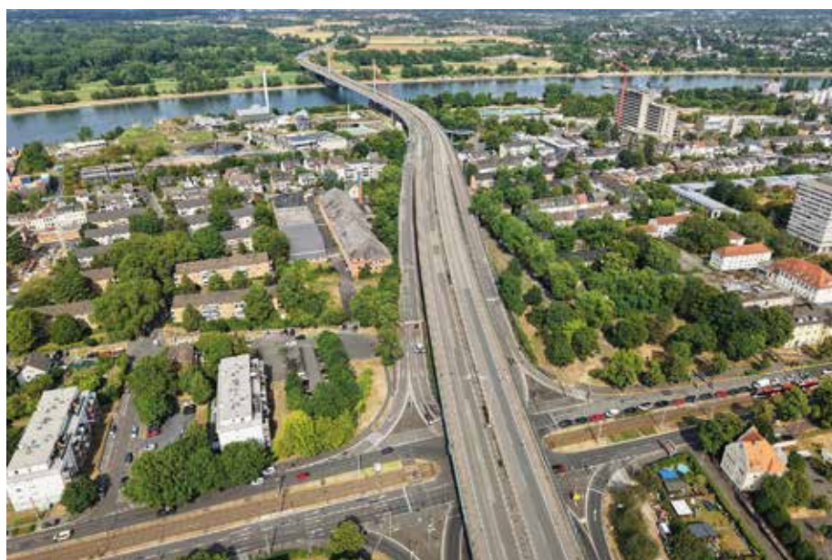
Großprojekt: Die Hagedorn Unternehmensgruppe übernimmt den Rückbau der A 565-Vorlandbrücke in Bonn. (Foto: Hagedorn)
