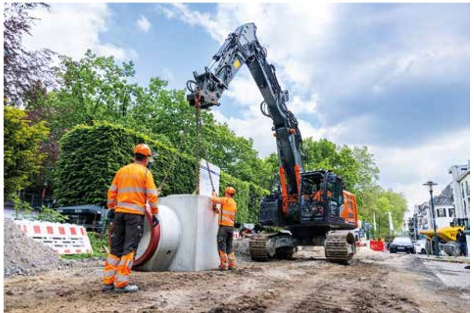
Vernetzt: Innerstädtische Baustelle mit dem KTEG 375USLC-7 mit Leica-Steuerung und KTEG CoPilot im Einsatz. (Fotos: Kiesel)
