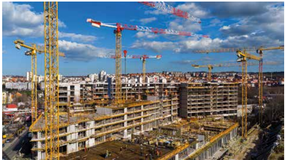
Kranensemble: Acht Potain-Topless-Krane und ein Selbstaufstellkran, werden beim Bau des Nemanjin-Grad-Komplex, am Stadtrand von Belgrad, eingesetzt. (Foto: Manitowoc)
