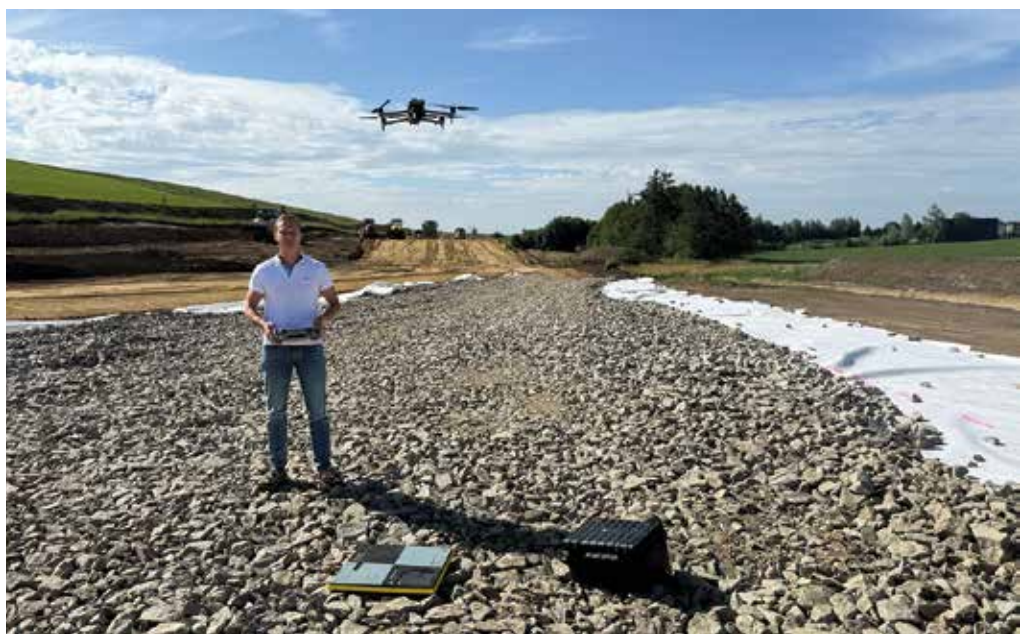
Hocheffizient: Aus den durch die Drohne vom Typ DJI Matrice 4 Enterprise generierten Geländeprofile wurden über das mit Trimble Business Center die Daten für 3D-Maschinensteuerungen der gemischten Flotte erzeugt. (Foto: Sitech)
