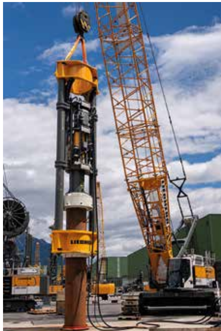
Flexible Lösung: Der Aufsteckmäkler mit Hammer H 10 von Liebherr für Rammarbeiten. (Foto: Liebherr)
