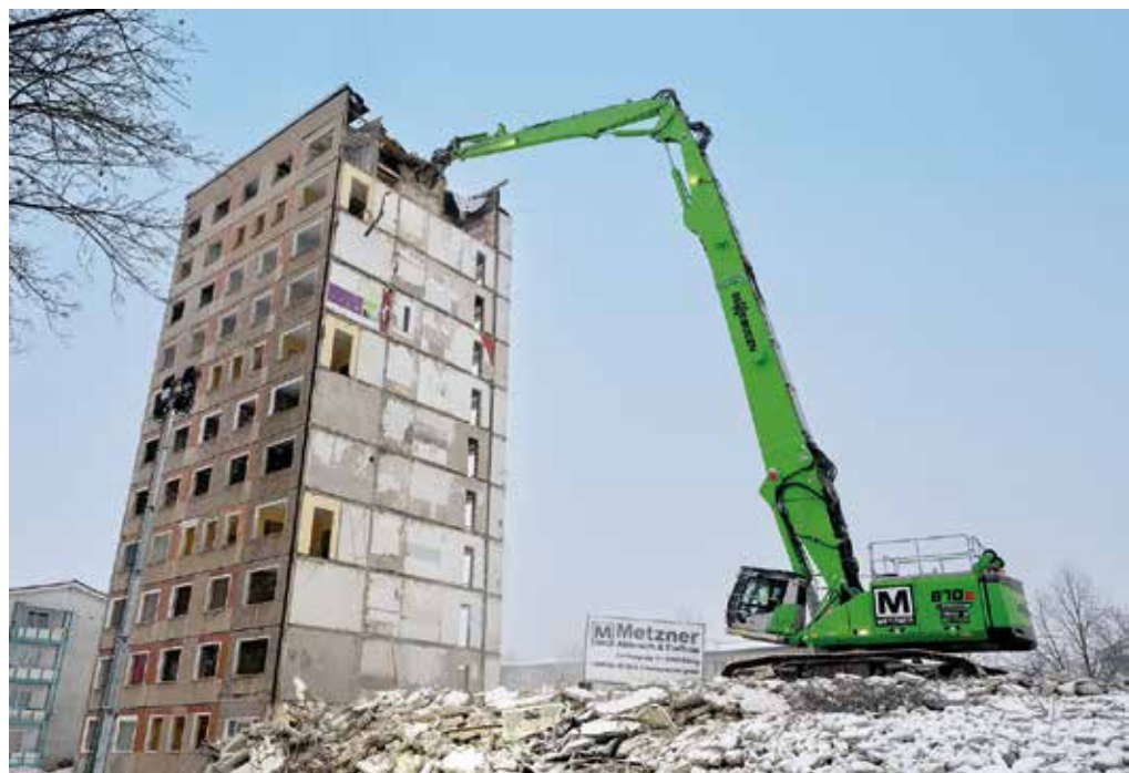
Kontrollierter Rückbau: Der Sennebogen 870 E Demolition Longfront Bagger gewährleistet den sicheren und präzisen Abbruch des innerstädtischen Plattenbaus. (Fotos: Stefan Hanke)
