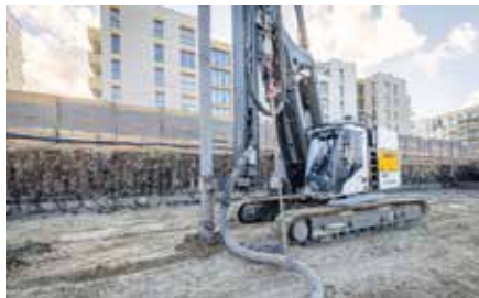
Reichlich Arbeit: Mit Vollverdrängerwerkzeug erstellt das LRB 19 insgesamt 1.772 Gründungspfähle.
