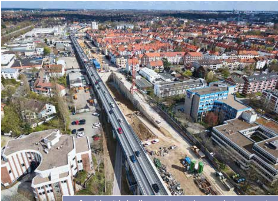
Großprojekt Südschnellweg: Viele Jahre lang war der hannoversche Stadtteil Döhren durch die Stadtautobahn geteilt. Dies ändert sich bis 2030 durch den Bau eines 1.100 m langen Straßentunnels. (Foto: Porr)
