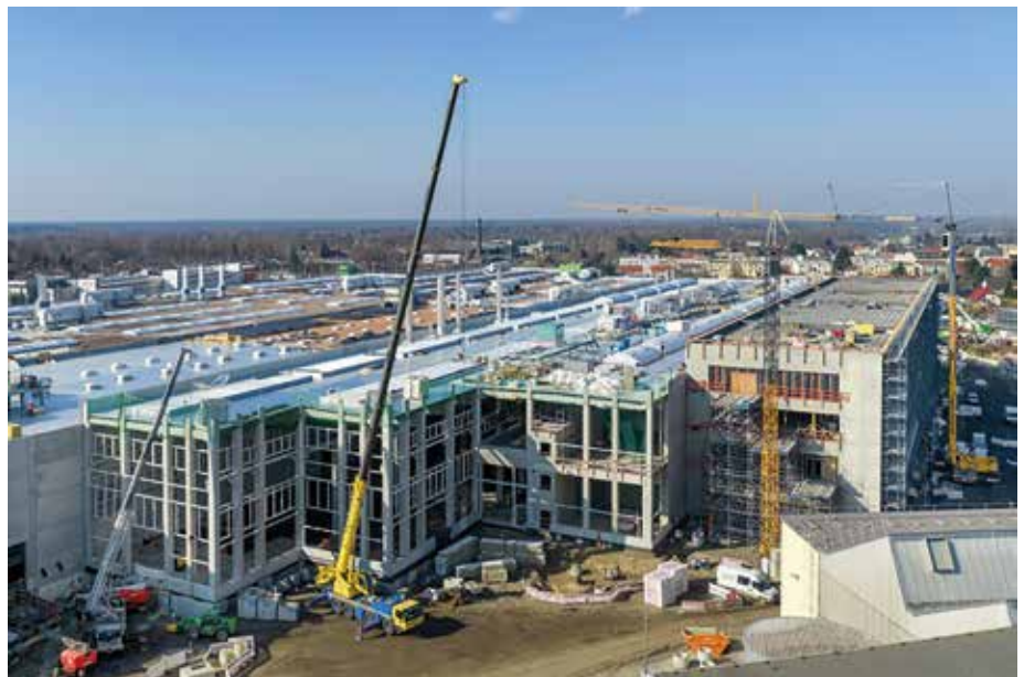
Großprojekt in Cottbus: Während der Bauphase für das ICE-Instandhaltungswerk kamen neben dem Mobilbaukran MK 140-5.1E (rechts im Bild) auch LTM-Mobilkrane, Schnelleinsatz- und Obendreherkrane von Liebherr zum Einsatz. (Foto: Liebherr)
