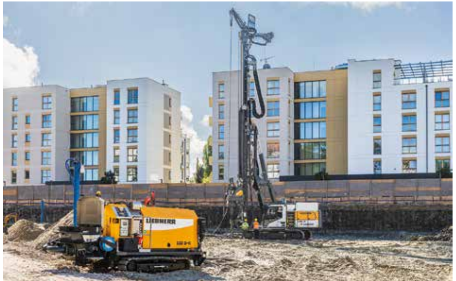
Perfekt für Pfahlgründungen: Das Duo, bestehend aus dem Ramm- und Bohrgerät LRB 19 und der Raupenbetonpumpe 110 D-K von Liebherr, im Einsatz für ein Wohnbauprojekt in Danzig. (Foto: Liebherr)
