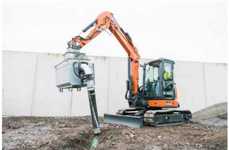
Hilfreiches Tool: Mit dem kleinsten Saugbagger der Welt lassen sich Kabel, Rohre und Baumwurzeln schonend freilegen. (Foto: Kiesel)
