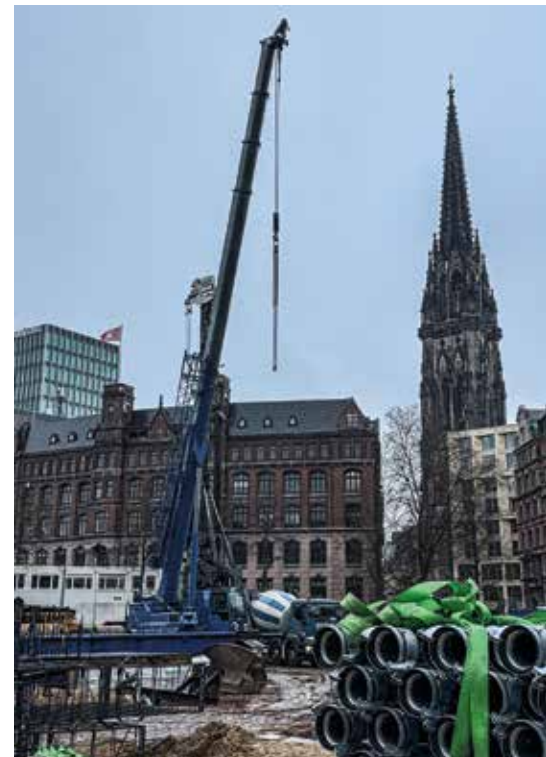
Zuverlässig: Die Batteriekapazität des elektrischen Teleskop-Raupenkran SCE800TB-EV reicht für einen Arbeitstag, nachts wird er geladen. In den ersten beiden Monaten seines Einsatzes hat der Kran ohne technische Ausfälle gearbeitet. (Fotos: Sany)
