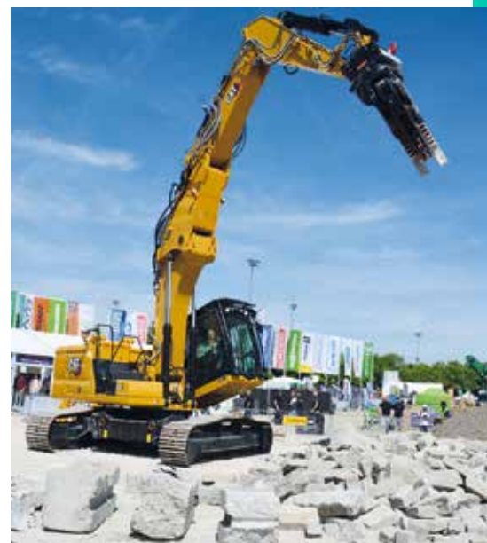
Flexibles Fahrwerk: Der Cat-Kettenbagger 330 UHD zeigte sein Können in der Crushing-Zone. Er bietet hohe Standfestigkeit im Rückbau und kann ohne Sondergenehmigung transportiert werden. (Foto: Zeppelin)
