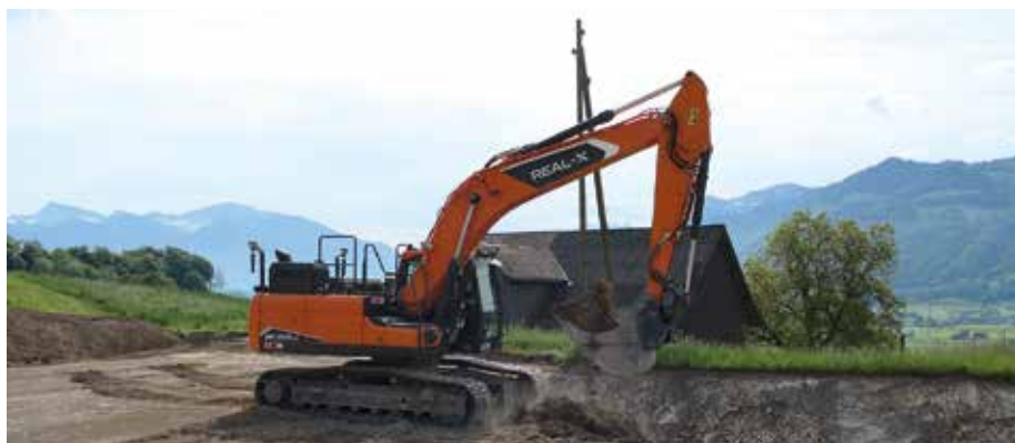
Geschichtsträchtig: Der autonom arbeitende Develon-Real-X-Kettenbagger DX225LC beim Praxiseinsatz im ehemaligen Steinbruch der Kibag im schweizerischen Tuggen. (Foto: Develon)
