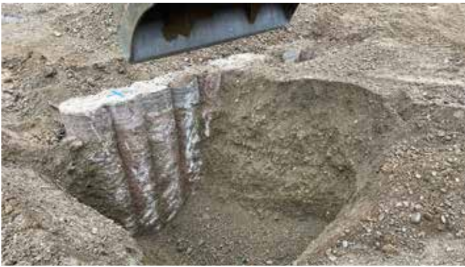
Deutlich weniger Emissionen: Eine Pfahlwand aus R-Beton mit 100 % recycelter Gesteinskörnung.
