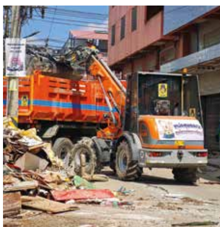
Aufräumarbeiten: Teleskopschwenklader TSL 9075 von Paus unterstützen nach der schweren Flut in Südthailand. (Foto: Paus)
