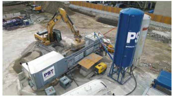
Projektspezifische Rezeptur: In der mobilen Mischanlage wurde der Beton nach Bedarf produziert und über bis zu 170 m lange Leitungen zu den Bohrgeräten gepumpt.
