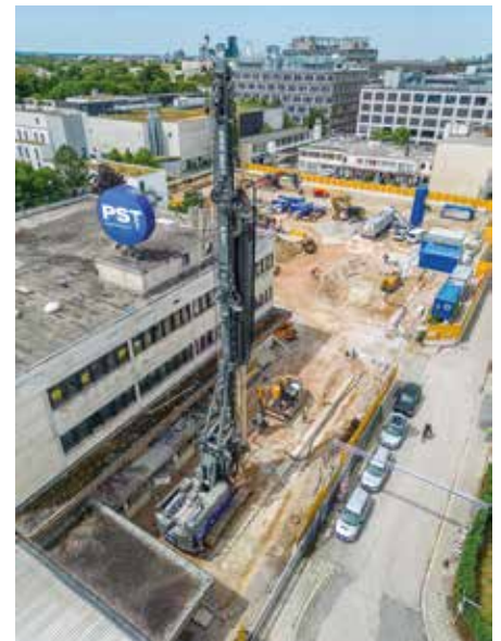
Pilotprojekt: Auf der Baustelle Levelingstraße in München verarbeitete das Team der PST Spezialtiefbau Süd GmbH rund 5.000 m 3 R-Beton 100 %. (Fotos: PST Spezialtiefbau Süd GmbH)
