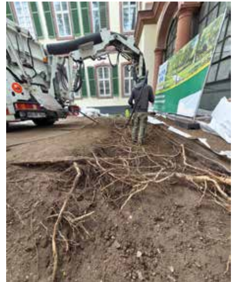
Häufig nachgefragt: Die Saugbagger Spengler GmbH hat im Garten des Bolongaro-Palasts das Wurzelwerk abgesenkt – ein Thema, das zunehmend an Bedeutung gewinnt. (Fotos: Saugbagger Spengler GmbH)
