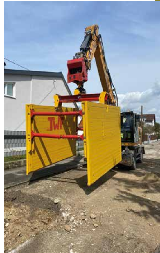
Gute Lösung: TWF-Standard-Box Typ 600 mit Verbaugreifer. (Foto: TWF Tiefbautechnik)
