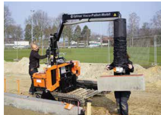
Rückenschonend: Mit dem Vacu-Pallet-Mobil können über 100 kg schwere Betonborde ohne den Einsatz von Muskelkraft eingebaut werden. (Foto: Optimas)
