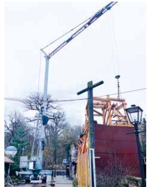
Kurze Bauzeit: Dank der hohen Umschlagleistung des Schnellmontagekrans CM 221A konnten die Eisbären im Zoo Hannover ihr Gehege schnell wieder beziehen. (Foto: BKL)
