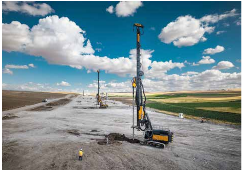
Single-Column-Mixing-Verfahren: Ressourcenschonend wird der anstehende Baugrund mit einem Bindemittel vermischt, nach dem Aushärten entstehen Einzelsäulen. (Fotos: Bauer Gruppe)
