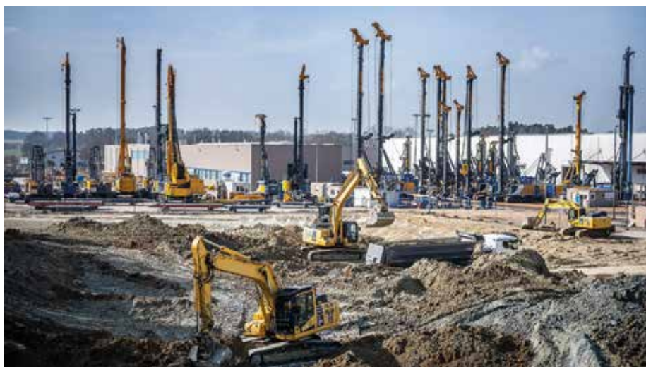
Investition: Die Bauer Maschinen GmbH baut den Standort Aresing aus. Für die Erdarbeiten wurde die Schwesterfirma Bauer Resources beauftragt. (Foto: Bauer Gruppe)
