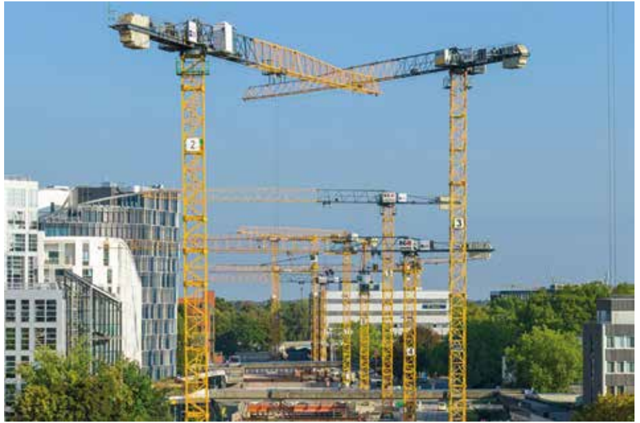
Mammutprojekt: Auf dem ersten Bauabschnitt für die neue Hamburger Linie U5 kommen aktuell 18 Liebherr-Turmdrehkrane zum Einsatz. (Foto: Liebherr)
