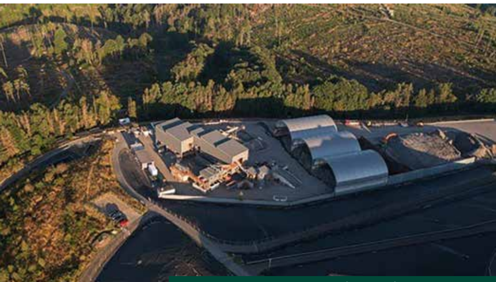
Versuchszentrum: In der Anlage für die Aufbereitung von Rostaschen am Entsorgungszentrum Leppe in Lindlar soll ein praxisnahes Karbonatisierungsverfahren getestet werden. (Fotos: refer GmbH)
