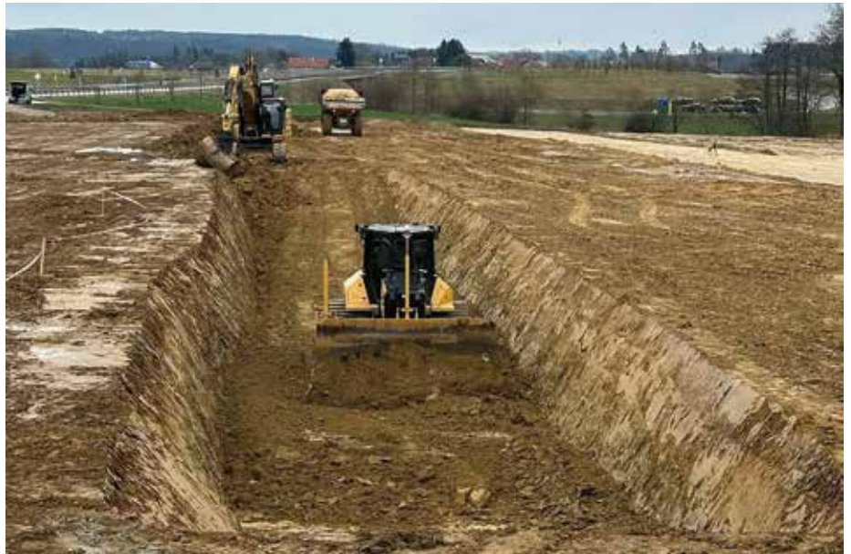
Deutliche Zeitersparnis: Erdarbeiten für den Neubau eines Logistikzentrums nach dem 3D-Modell. (Foto: Sitech)
