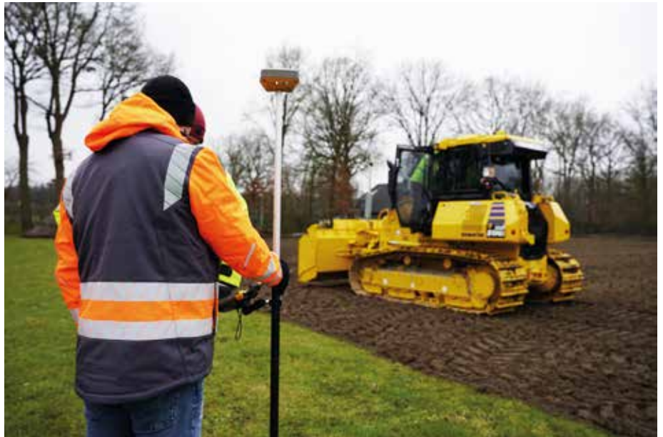
Hohe Genauigkeit: Auf einem Sportplatz in Lastrup sind Umbaumaßnahmen geplant. dxbau solutions unterstützt das GaLaBau-Unternehmen Borchers mit moderner GNSS-Technologie. (Foto: dxbau solutions)
