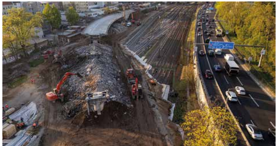
Operation am offenen Herzen: Die Westendbrücke ist eine der verkehrsreichsten Autobahnbrücken im Berliner Stadtgebiet. Der Abriss bedeutete eine Unterbrechung des Fern- und S-Bahnverkehrs. (Fotos: Jost Listemann | TIME:CODE:MEDIA)
