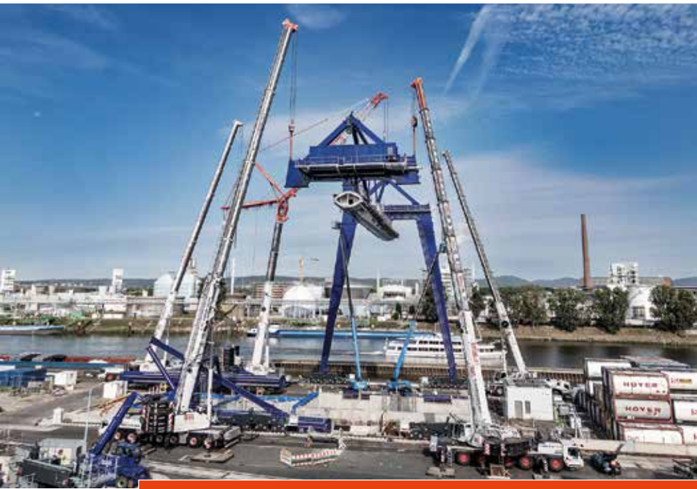
Perfektes Zusammenspiel: Die Kranfahrer von BKL arbeiteten in enger Abstimmung synchron zusammen und positionierten den 140 t schweren Hauptträger des Portalkrans sicher. (Fotos: Boris Golz/BKL)
