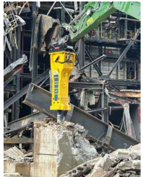
Los geht's: Die ersten Schläge des Epiroc HB 5800 auf dem Gelände des Kraftwerks Scholven. (Foto: Epiroc)
