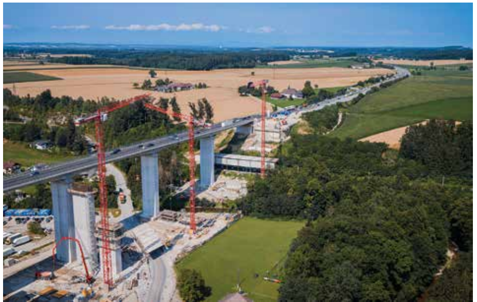
Imposantes Trio: Die Wolff Krane hoben beim Abriss der alten Brücke sowie beim Bau der neuen Tragwerke und Pfeiler bis zu 13 t schwere Lasten. (Foto: Wolffkran)
