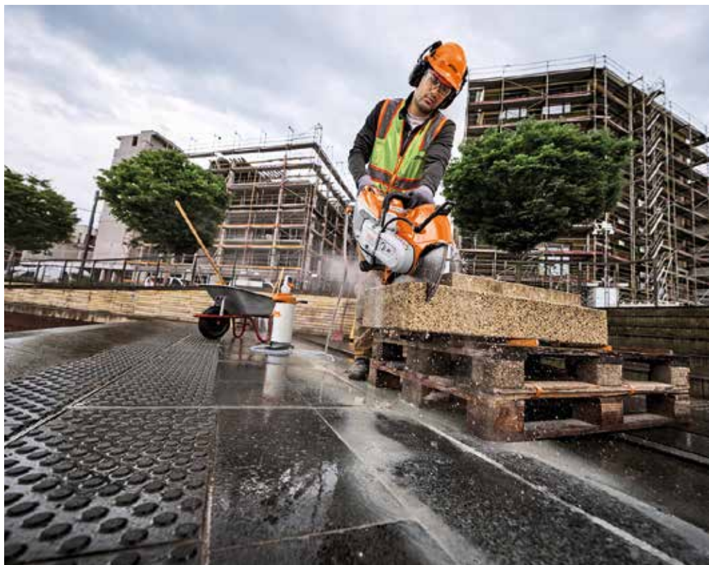
Kraftvoll: Mit einer mechanischen Leistung von bis zu 4,2 kW ist der neue TSA 500 der derzeit leistungsstärkste Akku-Trennschleifer im Stihl-Portfolio. (Foto: Stihl)
