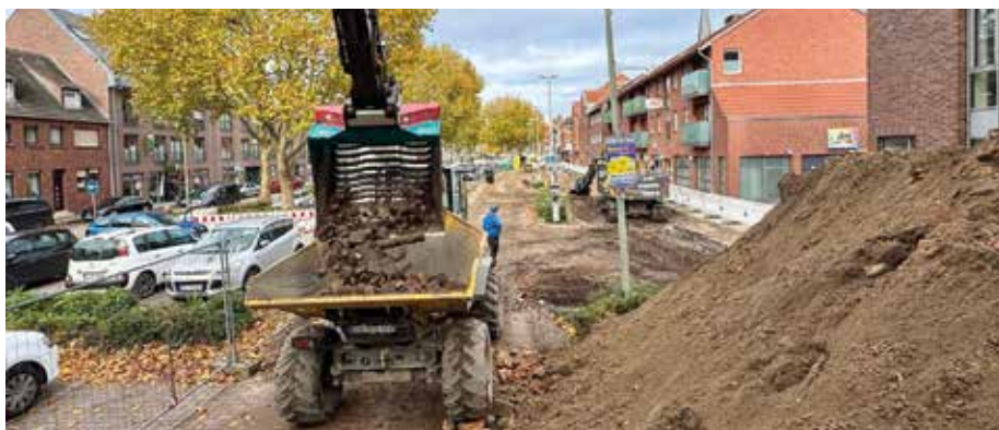
Gezielter Abtransport: Der ausgesiebte Grobanteil, Fremdkörper und Störstoffe werden separat abgelegt und entfernt.
