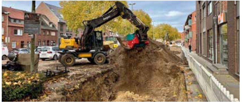
An Ort und Stelle: Der MaC-Rock Sieblöffel im Einsatz beim Aushub des Kanals – das Material wird direkt gesiebt und aufbereitet. (Fotos: Mac-Rock)
