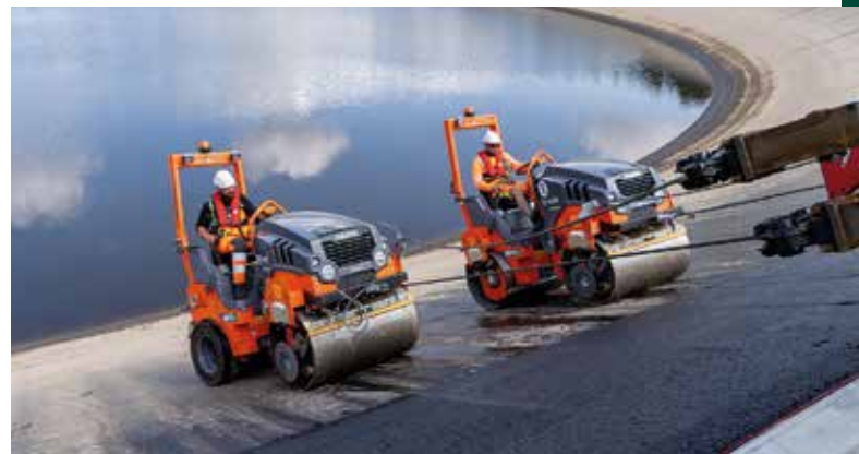
Einsatz in Schräglage: Sobald die eine Hamm Walze nach unten fuhr, wurde die zweite HD 12e automatisch nach oben gezogen. (Foto: Wirtgen)
