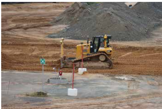
Unglaubliche Dimensionen: Eine Cat Raupe D6N unterstützt beim Anlegen eines Versickerungsbeckens mit einer Fläche von 70.000 m 2 . (Foto: Zeppelin)
