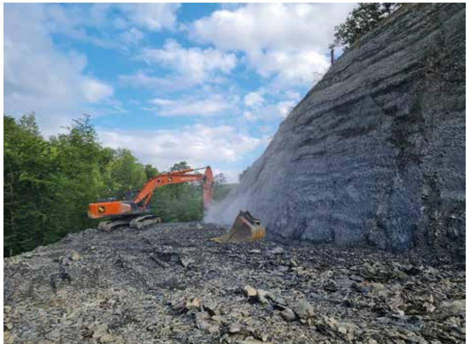
**Besonderer Fräsauftrag:** Die ebene Felswand wird präzise nach dem Geländemodell hergestellt. (Foto: PPS Pipeline Systems GmbH)
