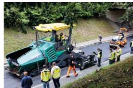
**Nachwuchs am Steuer:** Mithilfe des Fertigers Super 1900-5i bauten die Auszubildenden Trag- und Deckschicht ein.
