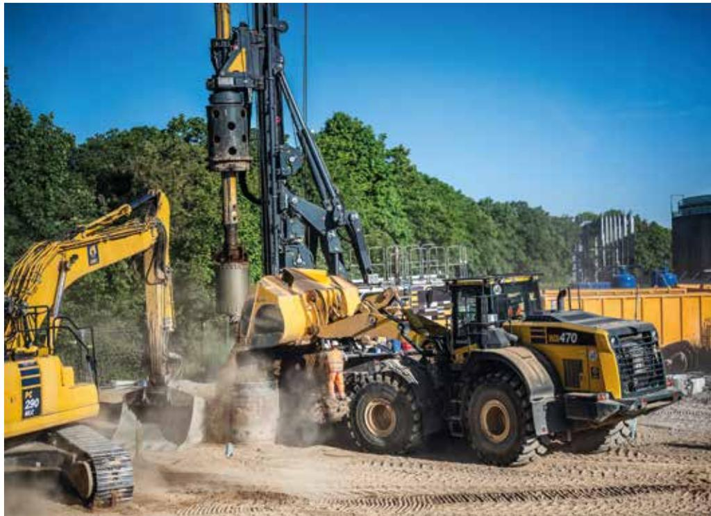
**Sanierung eines Areals bei Duisburg:** Mittels Austauschbohrungen wurde der verunreinigte Boden durch unbelastetes Material ersetzt. (Foto: Bauer Gruppe)
