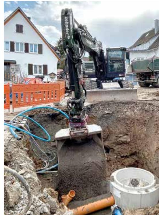
**Schnellere Abläufe:** Maximale Flexibilität der Endlosdrehung ermöglicht das Arbeiten in alle Richtungen, sodass wie hier auch von der Maschine weggearbeitet werden kann und der Bagger seltener versetzt werden muss. (Fotos: Holp)
