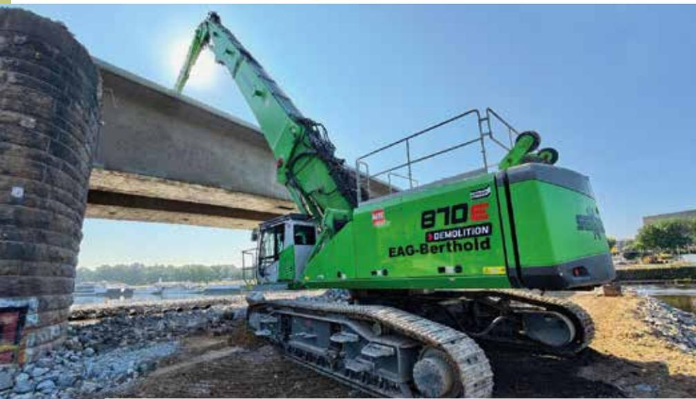
**Kraftvolle Ergänzung:** Der Sennebogen 870E Demolition ist beim Rückbau der Carolabrücke mit dem Hydraulikhammer GH-15 ausgestattet. (Foto: Schlüter)
