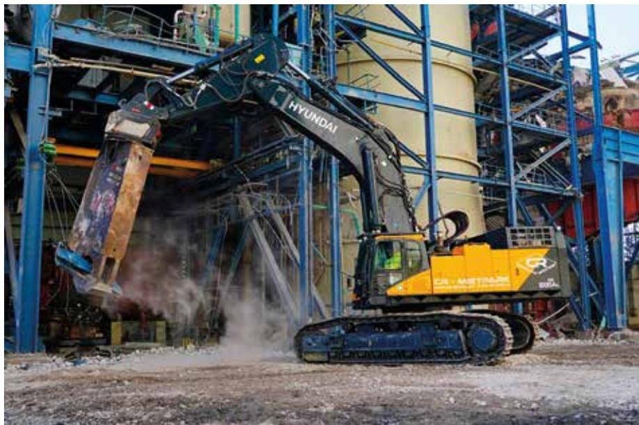
**Volle Kraft:** Der HX1000A und sein Kollege, der HX800, nehmen es beim Rückbau in Werne mit im 25.000 t Stahlschrott und 40.000 t Beton auf. (Fotos: Hyundai)
