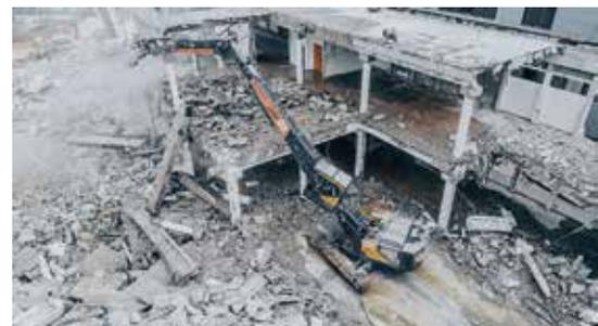
**Abbruch-Spezialist:** Der auf die Anforderungen des Kunden zugeschnittene Bagger kann ohne Sondergenehmigungen transportiert werden. (Foto: Echle)
