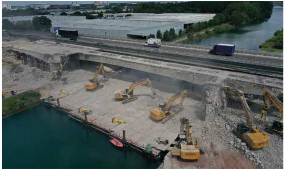
**Kraftvoll:** Die Cat-Flotte der F. Beissner GmbH beim Rückbau der Brücke „Wo2“ bei Wolfsburg. (Fotos: Epiroc)
