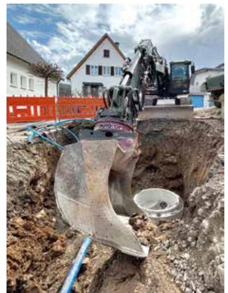
**Zielgenaues Verfüllen:** Durch den RotoTop und seine Endlosdrehbarkeit verlängert sich die tatsächliche Reichweite des Baggers.
