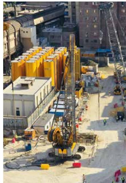
**Antike trifft Moderne:** Unweit der Pyramiden in Kairos Stadtteil Gizeh unterstützt ein Bauer MC 96 Seilbagger beim Bau der neuen U-Bahn-Station. (Foto: Bauer)
