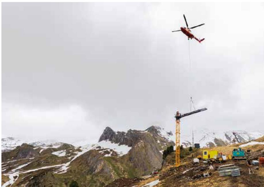
**BKL auf Höhenflug:** Innerhalb von einem Tag und 15 Helikopterflügen war die Baukranmontage im hochalpinen Gelände der Silvretta abgeschlossen. (Foto: BKL)
