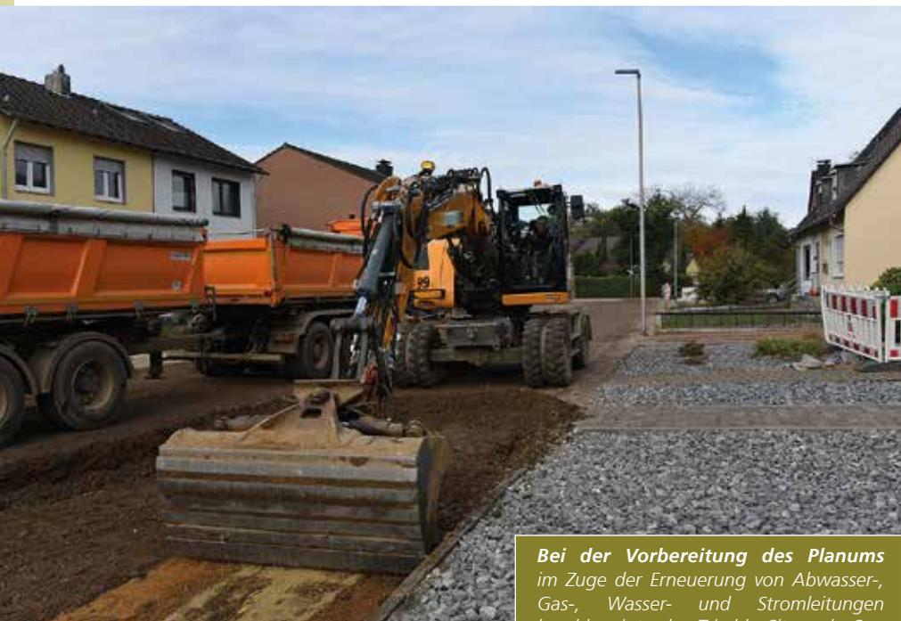
*Bei der Vorbereitung des Planums im Zuge der Erneuerung von Abwasser-, Gas-, Wasser- und Stromleitungen beschleunigte das Trimble Siteworks-System die Arbeiten spürbar. (Fotos: Trimble)*
