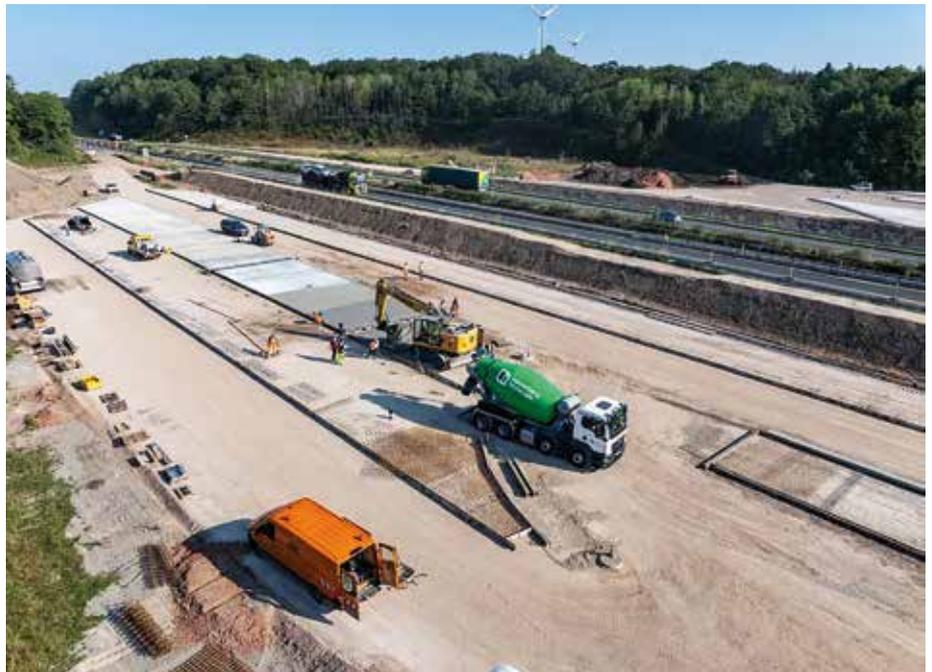
**Pilotprojekt:** Bei der Erneuerung der Fahrbahndecke an der unbewirtschafteten Rastanlage Potzberg wurde ausgelotet, ob sich Recyclingbeton als Rohstoff in größerem Umfang als bisher im Straßenbau einsetzen lässt. (Foto: Heidelberg Materials AG, Aleksej Keksel)
