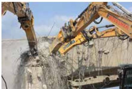
**Alles muss raus:** Unerbittlich schlagen die Epiroc-Hämmer auf die Brücke ein, die aufgrund von Betonkrebs einem Ersatzneubau weichen muss.
