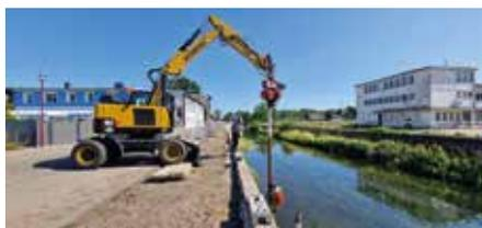
Der MX16G von Hydrema hat so viel hydraulische Kraft, dass er eine Müller-Ramme betreiben kann. (Foto: Hydrema)
