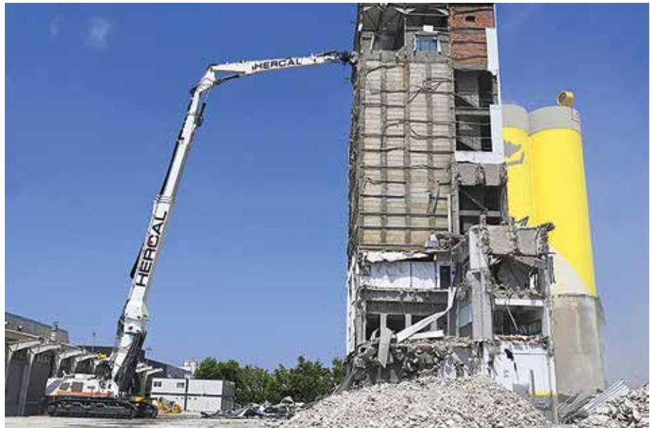
**Kurzer Prozess:** Der Liebherr R 980 Demolition-Bagger von Hercal wird beim Abbruch eines Stahlbetongebäudes in Barcelona eingesetzt, das aus 18 runden und zwei quadratischen Silos mit jeweils 37,5 m Höhe besteht. (Foto: Liebherr)
