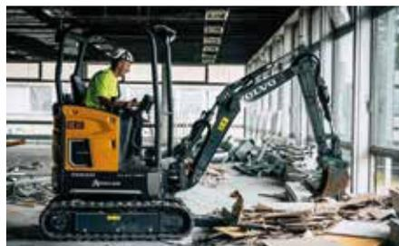
**Feinfühlig:** Der Volvo-Kompaktbagger ECR18 Electric entkernt innerhalb des Gebäudes. (Foto: Volvo CE)
