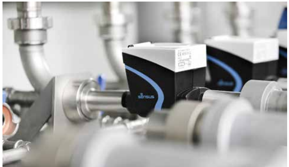
Hohes Einsparpotential: Der statische Wasserzähler iPERK mit patentierter Magnetfeldtechnologie. (Foto: Xylem)
