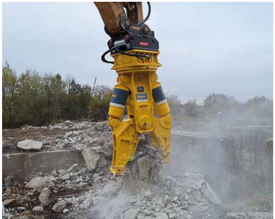
Schafft Platz: Die Kombi-Zange CC 3100 von Epiroc beim Rückbau des ehemaligen Heizhauses in Eisenberg. Hier soll später das Dienstleistungszentrum des Landratsamtes entstehen. (Foto: Epiroc)
