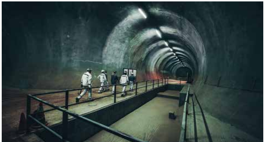
Logistisch anspruchsvoll: Der Umbau des Endlagers Konrad in 850 m Tiefe gestaltet aufwändig. (Fotos: Sandvik)
