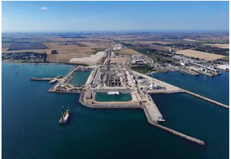
Logistische Meisterleistung: Das Tunnelportal Puttgarden auf deutscher Seite ist Teil des größten Infrastrukturprojekts Nordeuropas. (Foto: Femern AIS, Christian Hübner)
