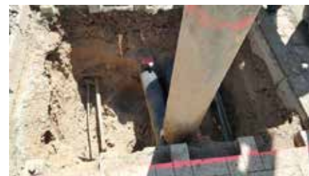
Saugen statt Baggern: Die freizulegende Infrastruktur wird geschont und nur eine minimal kleine Baugrube benötigt.
