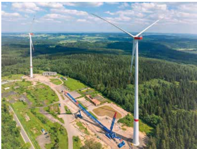
Regionale Energiewende: Der Windpark Prüm Air Station auf ehemaligem Militärgelände versorgt rund 13.000 Haushalte mit Strom. (Foto: RES)
