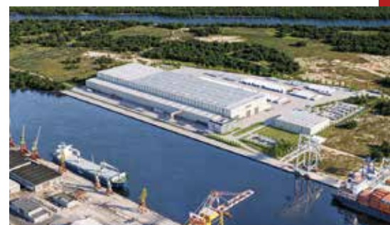
Energiewende: Die Porr bringt mit dem Bau einer Fabrik in Stettin die Offshore-Windenergie in Polen voran. (Foto: Industria Project)
