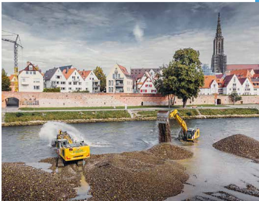
Vielfach fotografiert: Zwei Raupenbagger R 938 von Liebherr befördern vor dem Hintergrund des Ulmer Münsters rund 80.000 t angespülten Kies der Iller aus der Donau. (Foto: Liebherr)
