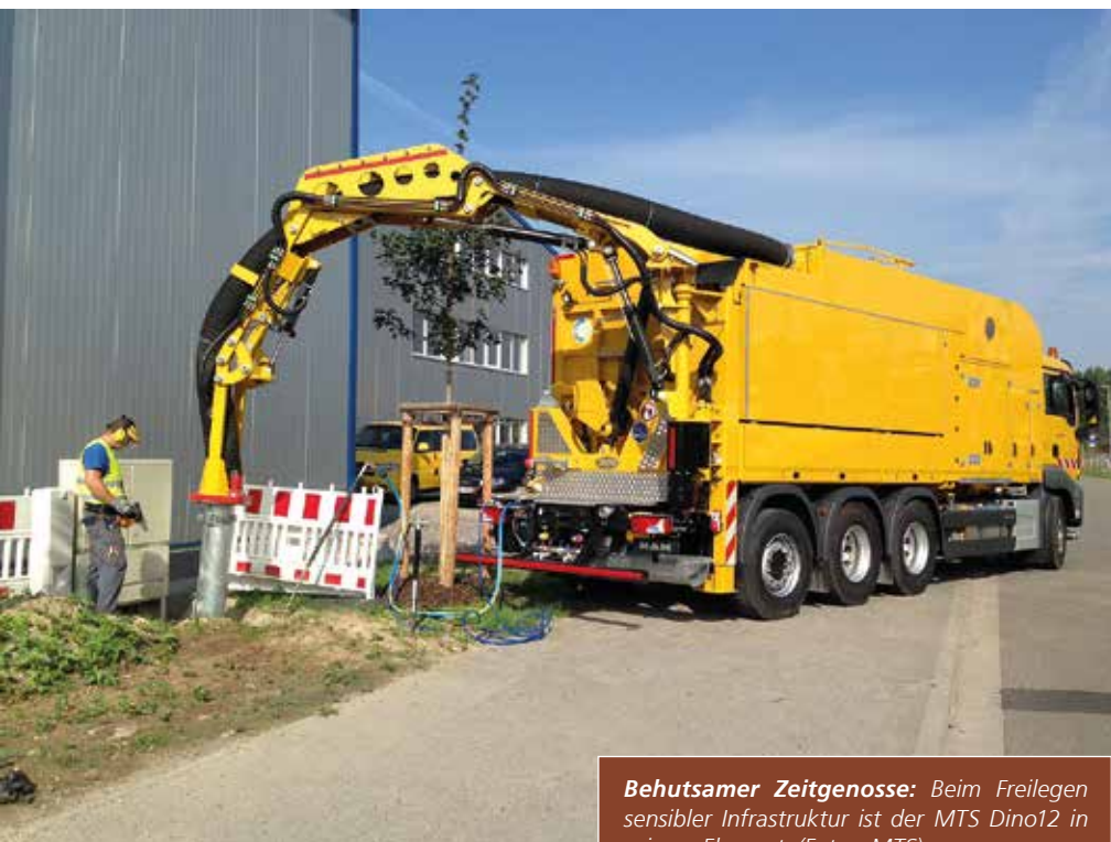
Saugen statt Baggern: Die freizulegende Infrastruktur wird geschont und nur eine minimal kleine Baugrube benötigt.
