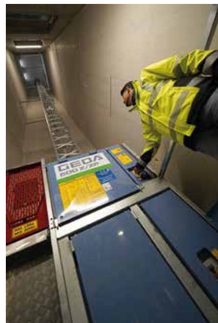
Pfiffige Lösung: Im Erweiterungsbau des Klinikums Passau erleichtert ein GEDA 500 Z/ZP den Materialtransport. (Foto: Beutlhauser)
