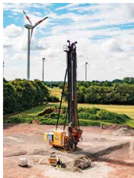
Nachhaltiges Handeln: Pfahlgründungen für den Windpark Stemwede mit schlanken Frankipfählen NG reduzieren den CO 2 -Ausstoß. (Foto: Porr)
