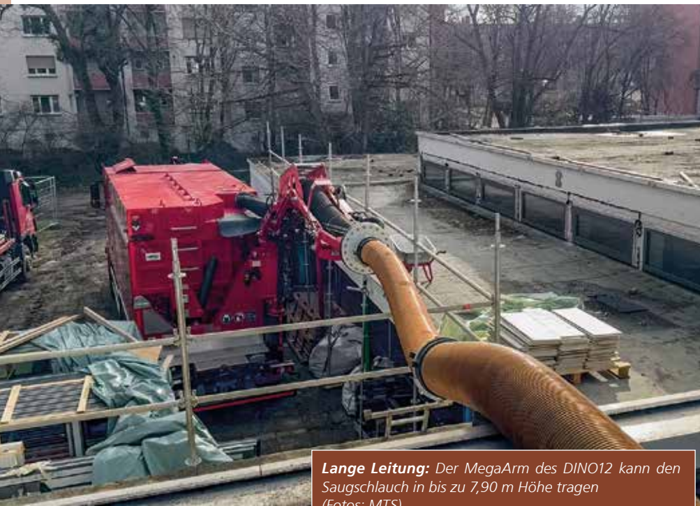
Kurzer Prozess: Der auf dem Flachdach verbackene Kies wird mit dem Spatel gelöst und direkt aufgesaugt.
