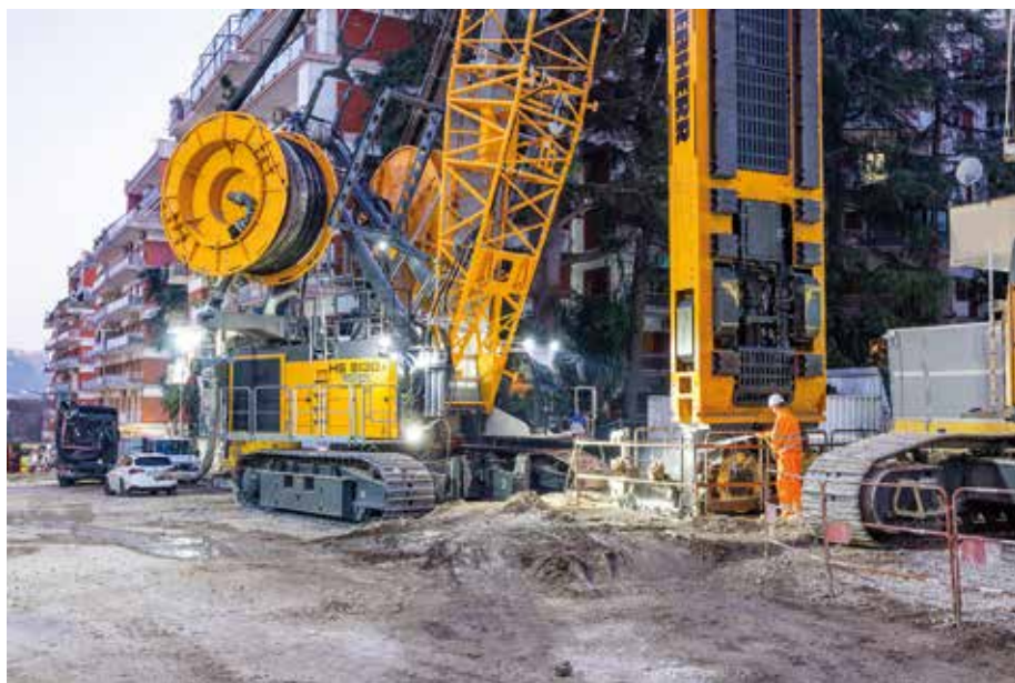
Schweregewicht für Innenstädte: Der leistungsstarke HS 8130.1 von Liebherr ist bestens für Schlitzwandarbeiten geeignet und verursacht geringe Emissionen. (Foto: Liebherr)
