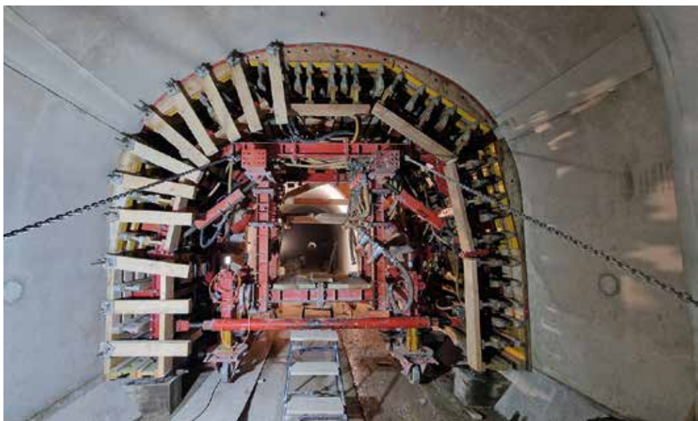
Effektives Gespann: Die biegbare und biegesteife Vollkunststoffplatte Alkus GM6 auf der PERI-Stollenschalung und dem Rubrika-Tunnelwagen für den Sicherheitsstollen des Tunnels La Clusette. (Fotos: Alkus)
