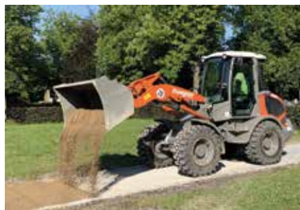
Präzise: Im Wegebau in einer Parkanlage kann der Weycor AR 420 überzeugen. (Foto: Weycor)
