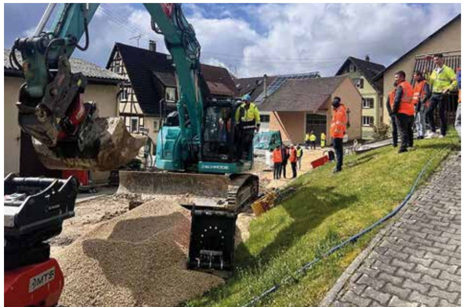
Tiefbau der Zukunft: Anhand einer klassischen Sanierungsmaßnahme im Schwäbischen Sonderbuch präsentiert MTS modellbasiertes Bauen ohne Medienbruch. (Foto: MTS)
