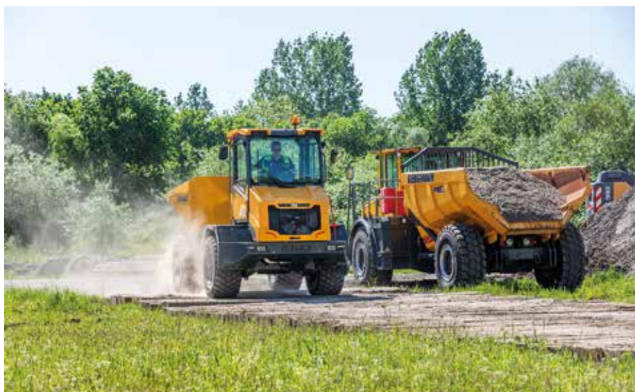
Harten Einsätzen gewachsen: Bohnenkamp und Bergmann haben Reifen von BKT für Baustraßen auf dem Gelände der Firma Bunte getestet. (Foto: Bohnenkamp)
