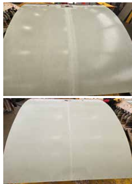
Für das perfekte Finish: Die Alkus-Schalungsplatten auf der PERI-Stollenschalung (o.) wurden vor der Verwendung mattiert (u.).
