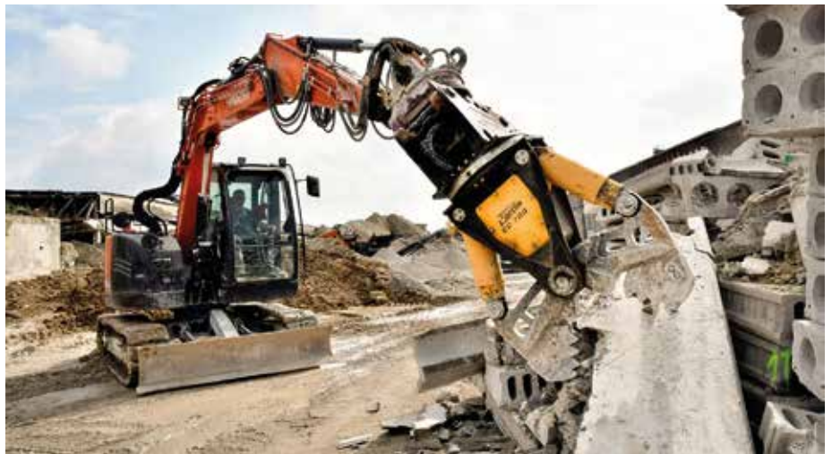
Volle Kraft: Der Kurzheckbagger ZX85US-6 von Hitachi zerbeißt den harten Beton mit seiner Zange fast spielerisch. (Foto: Kiesel GmbH, Dieter Göllner)
