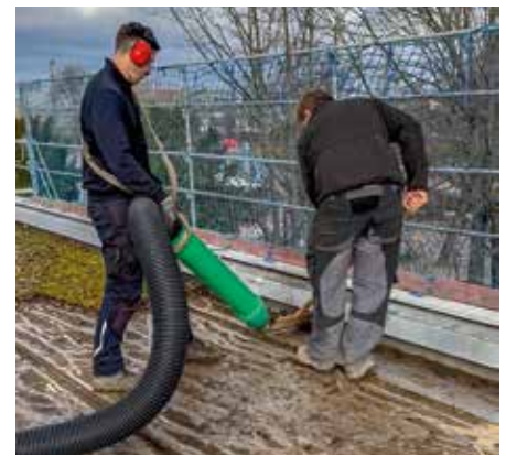
Kurzer Prozess: Der auf dem Flachdach verbackene Kies wird mit dem Spatel gelöst und direkt aufgesaugt.
