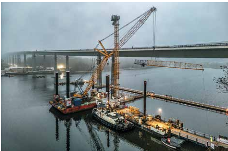
Montage im Wasser: Der erste Kran für den Ersatzneubau der Rader Hochbrücke wurde auf der neuen Pfahlkopfplatte des ersten Brückenpfeilers montiert.
