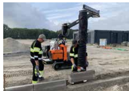
Deutliche Erleichterung: Das Vacu-Pallet-Mobil schont den Rücken der Mitarbeiter und erhöht die Arbeitsgeschwindigkeit. (Foto: Optimas)
