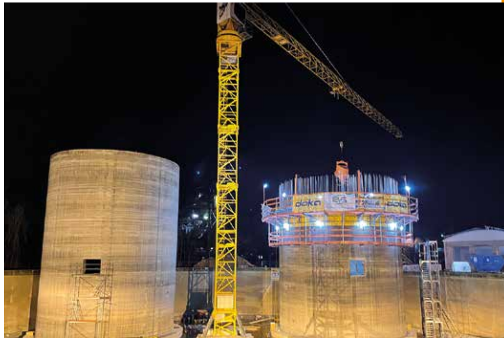
Schnelle Umsetzung: Beim Bau von Faultürmen in Saarbrücken-Brebach wurden durch die wirtschaftliche Gleitbauweise elf Wochen Bauzeit eingespart. (Foto: Doka)
