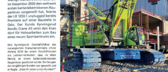
Ein Kranmodell, bevor Liebherr im Dezember 2020 den weltweit ersten batteriebetriebenen Baupark vorstellt, hat, feierte der L 9551 in der Baustelle in Ols.
