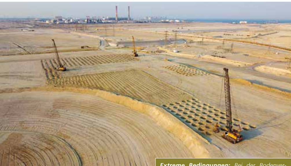
Extreme Bedingungen: Bei der Bodenverdichtung für das Bauprojekt Sabah Al Ahmad Sea City sind sechs Bauer MC Seilbagger im Einsatz. (Fotos: Bauer Gruppe)
