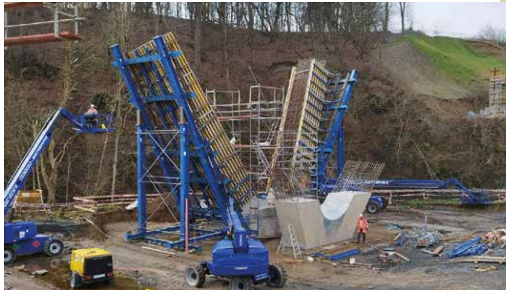
Zeitlich entkoppelt: Während der Beton des einen V-Astes aushärtet (l.), wird der andere für die Betonage vorbereitet (r.). (Foto: LBM Rheinland-Pfalz)
