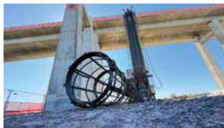
Imposant: Ein Bewehrungskorb für die rund 15 m langen Pfähle.
