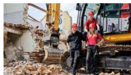
Eigenverantwortliches Arbeiten: Dank der Azubi-Baustelle erreichen die Auszubildenden schnell einen hohen Wissensstand. (Foto: Hagedorn)
