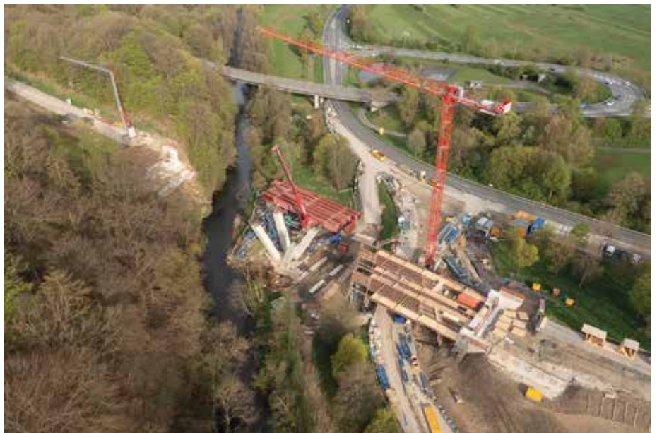
Zweifach geneigt, einmal gedreht: Da die Pfeileräste der neuen Brücke nicht linear zueinander verlaufen, kam eine Kombination aus Traggerüst und Trägerschalung zum Einsatz. (Foto: Doka)
