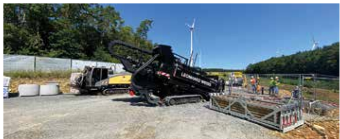
Grunddrill ACS300 beim Trassenbau für Leonhard Weiss. (Foto: Leonhard Weiss)
