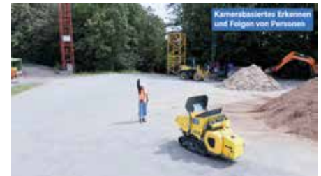
Sicherer, autonomer Betrieb: Der kollaborative Schüttguttransportroboter entlastet den Menschen. (Foto: TUM)
