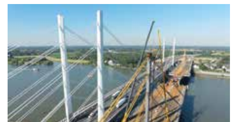
Blaupause: die Hilfsseilkonstruktion von Hochtief ist für viele der bestehenden Schrägseilbrücken weltweit geeignet. (Foto: Hochtief)
