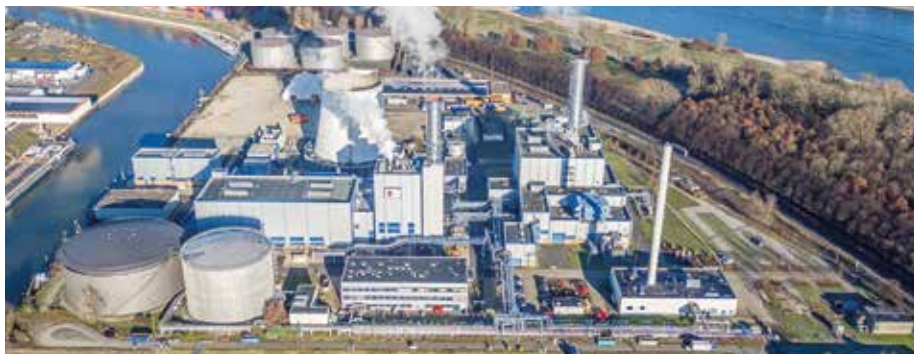
Leuchtturmprojekt: In Köln-Niehl entsteht die größte Flusswasser-Wärmepumpe Europas. (Foto: RheinEnergie)
