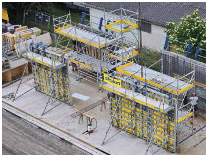
Doka LeanForm ist eine zentrale Vormontageplattform, die für reduzierte Wartezeiten auf der Baustelle sorgt. (Fotos: Doka)
