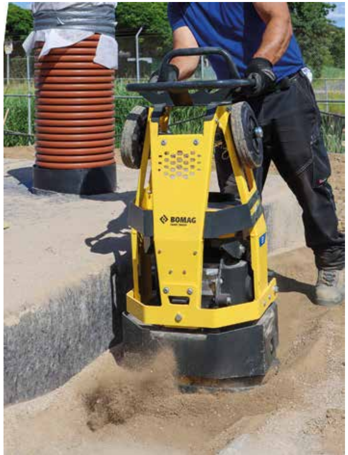
Die akkubetriebene Roundplate BR 95 e ist sowohl leistungsstark als auch flexibel in der Anwendung. (Foto: Bomag)
