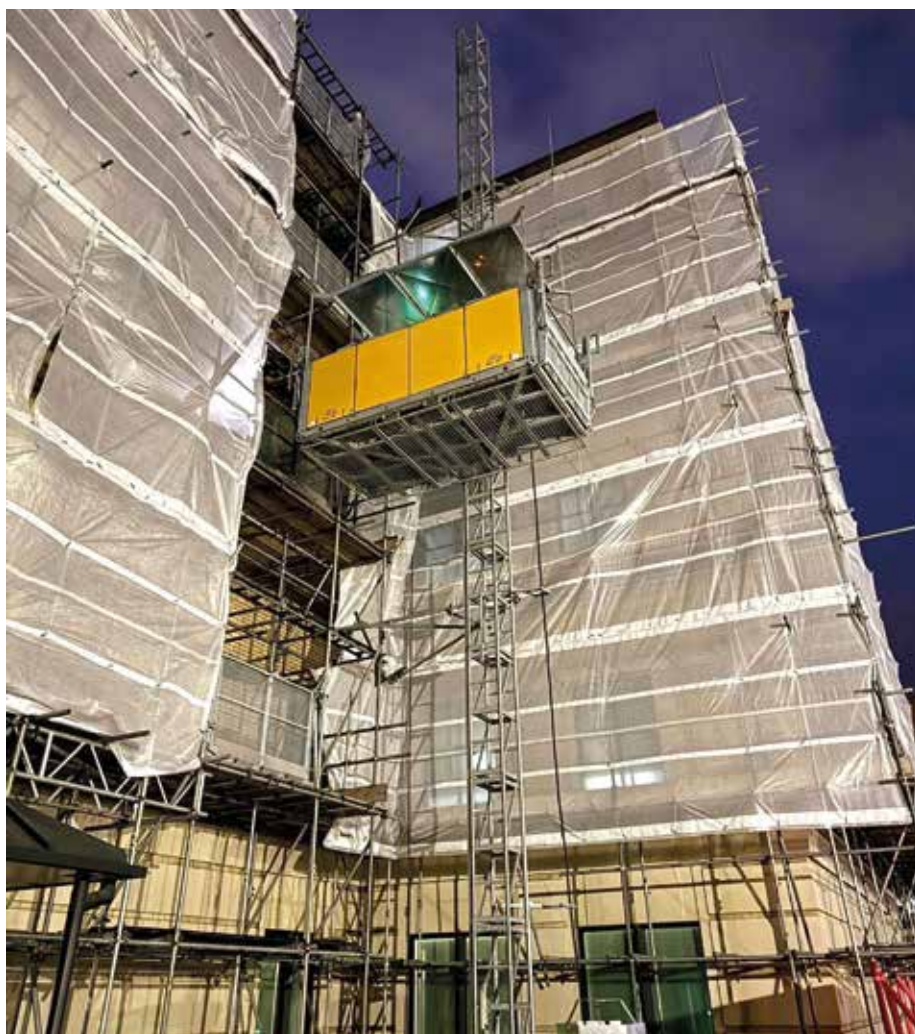
Neu im Angebot: Die Firma Burkowski hat Produkte von Electroelsa in ihren Mietpark aufgenommen, darunter die Transportbühne Elsa PM-M23. (Foto: Burkowski)
