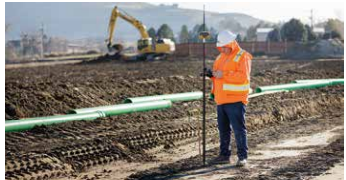
Der GNSS-Empfänger HiPer XR richtet sich an Anwender, die auf hochwertige Präzisionsmessungen angewiesen sind (Foto: Topcon)
