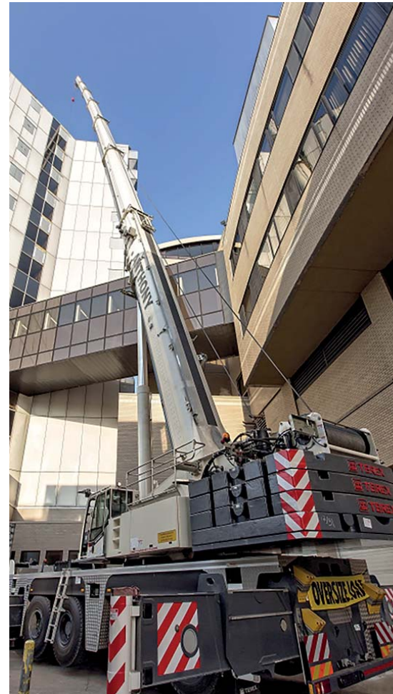
Der All-Terrain-Kran bot die passenden Voraussetzungen, um die Hübe effizient durchführen zu können. (Foto: Terex)
