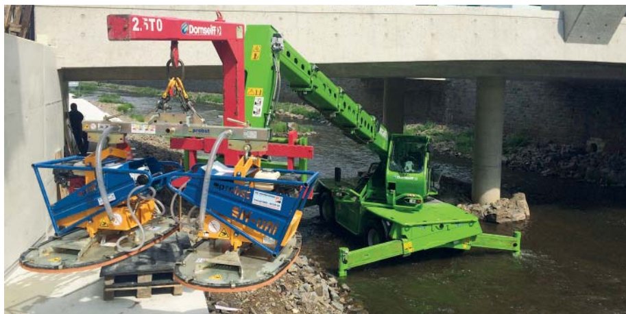
Ein Teleskopklader half mit bei der Verschönerung der „Rubenstadt“ Siegen. Bei der Freilegung und Uferbefestigung des Flusses Sieg musste er meist im Wasser stehend arbeiten. (Foto: Merlo)
