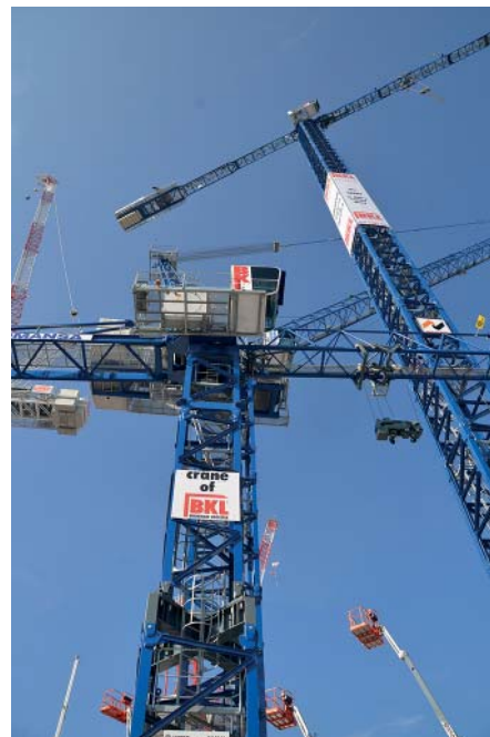
Über 80 m freistehende Hakenhöhe: Bei BKL stand der höchste Kran der Messe, ein 21 LC 750 von Linden Comansa. (Foto: BKL)
