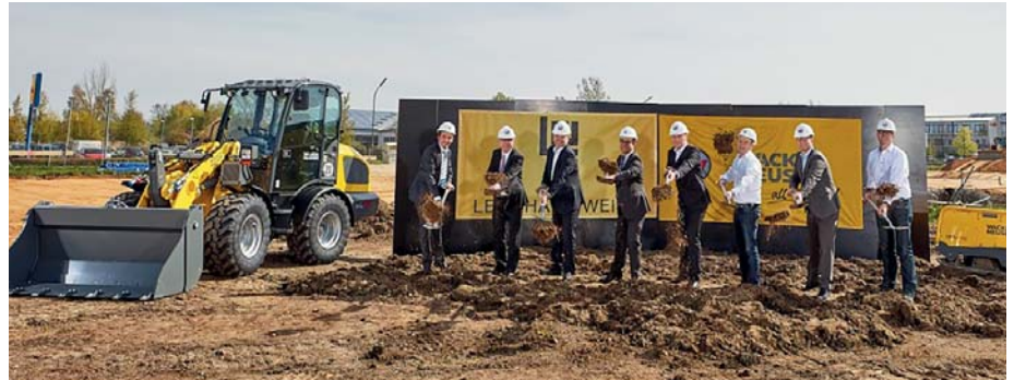
Der erste Spatenstich erfolgte im April, bereits Ende des Jahres sollen die neuen Gebäude bezogen werden. (Foto: Wacker Neuson)
