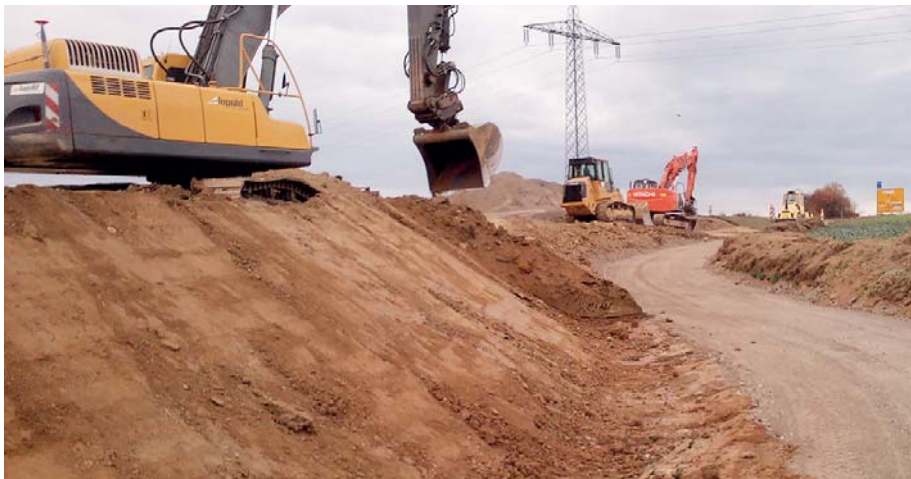
Dank der 3D-Baggersteuerung benötigte das Bauunternehmen für die Neuanlage eines Kreisverkehrs ohne Vollsperrung nur fünf Wochen. (Foto: MTS)
