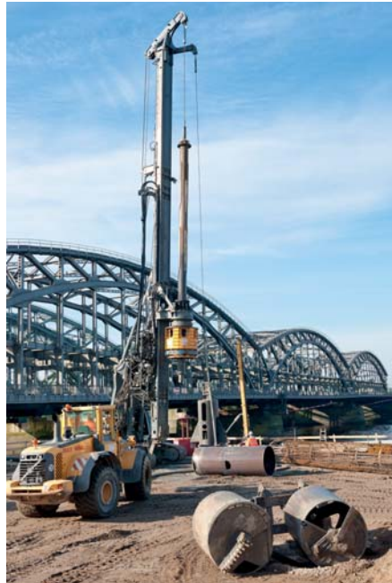
Ausbau der U 4 in Hamburg: Die Gründung des Ebbrückenpfeilers erfolgt auf Großbohrpfählen. (Foto: Max Bögl)
