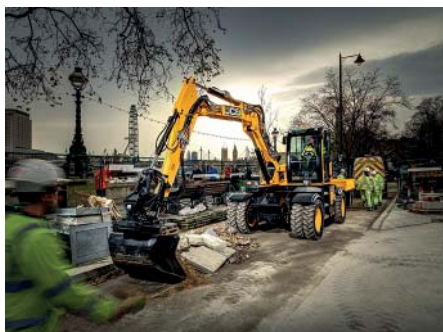
Mit perfekter Rundumsicht und massiver Standfestigkeit erlaubt der Hydradig von JCB ein müheloses Arbeiten auf beengten Stadtbaustellen. (Foto: JCB)
