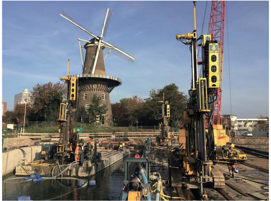
Arbeit für Spezialisten: Für die Pfahlgründung der Tiefgarage wurde bis in 55 m Tiefe gebohrt. (Foto: Bauer Gruppe)
