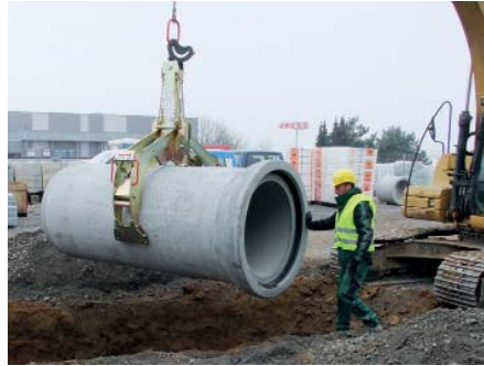
Der mechanische Rohrgreifer mit Sicherheitsverriegelung RG-75/125-Safelock hat eine Tragfähigkeit von 4 t. (Foto: Probst)
