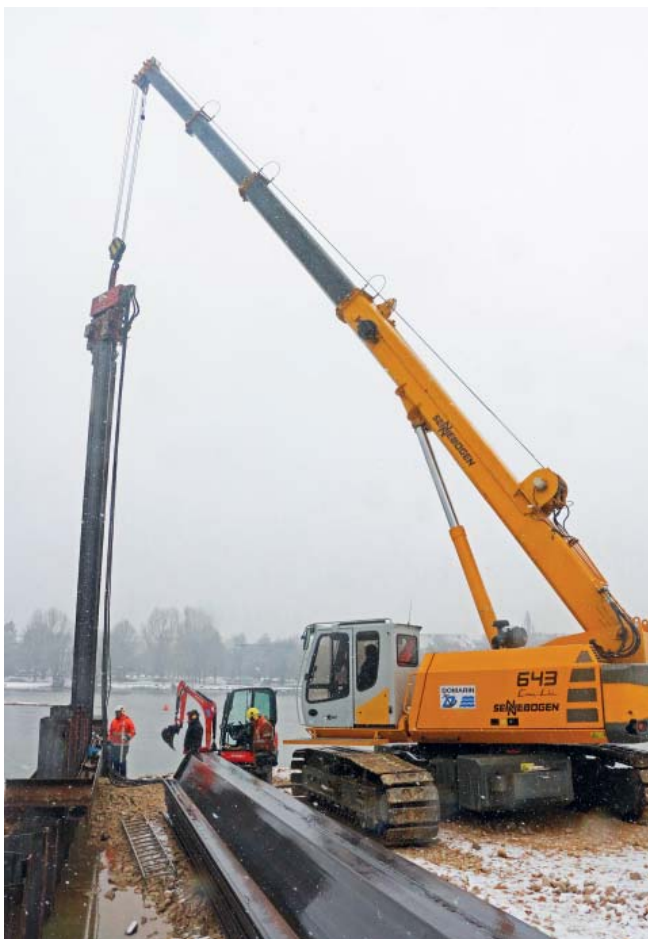
Auf der Dammbaustelle: Bis 12 m lange Spundwände rammt der 40-t-Telekran in den Boden. (Foto: Sennebogen)
