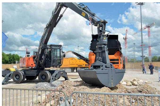
Zum Beschicken der Anlage diente der Atlas 250 MHE, ein rein elektrisch betriebener Bagger mit nahezu null Geräuschemissionen und niedrigen Betriebskosten von etwa 2,50 Euro pro Stunde.
