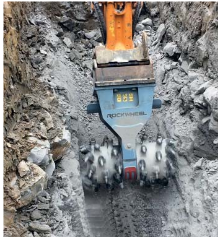
Die Rockwheel-Anbaufräse ist im Kanalbau bis zu dreimal schneller als ein Hydraulikhammer.
