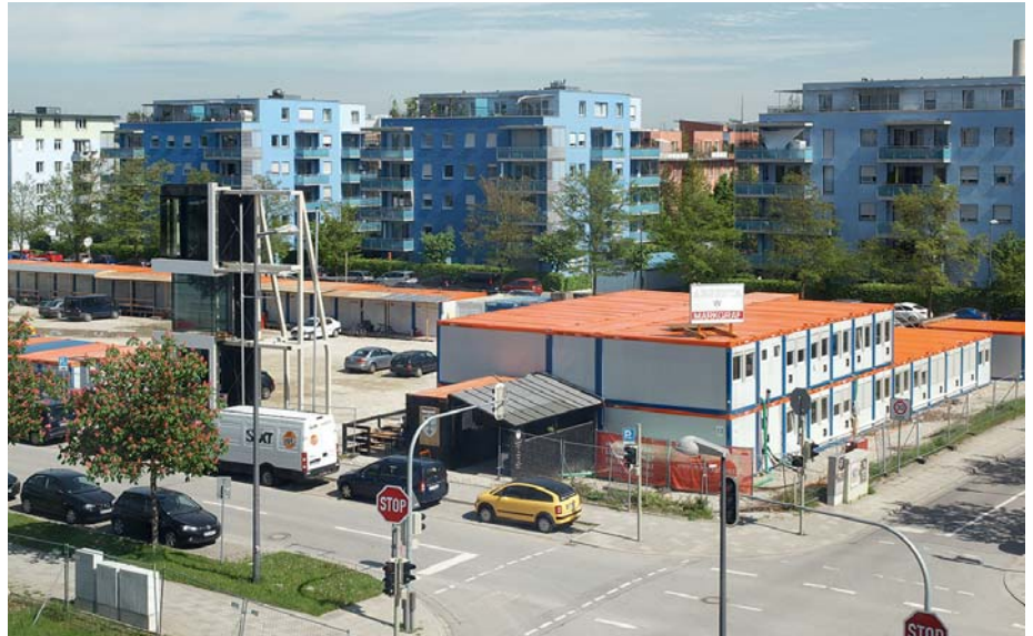
Rund 110 Container sind Baubegleiter von zwei Großprojekten in der Münchener Parkstadt-Schwabing. (Foto: HKL Baumaschinen)
