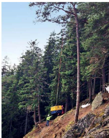
Sicherung eines Steilhanges an der L237 bei Kühtai. Der Baukompressor wurde eingeflogen. Kufenmodelle mit ihrem geringeren Gewicht sind dabei im Vorteil.
