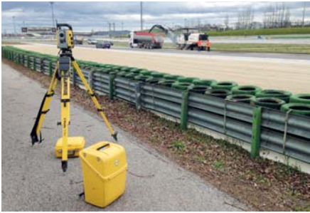
Die Trimble SPS930 Universal Total Station wird auf das aktive Prisma der Kaltfräse eingestellt. So lässt sich die Frästiefe auf den Millimeter genau justieren.
