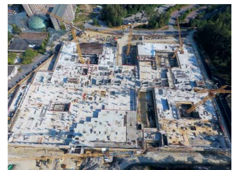
Durch ein ausgeklügeltes Aufstellkonzept wird sichergestellt, dass alle Bereiche der Baustelle von Kränen mit der benötigten Tragfähigkeit abgedeckt werden.
