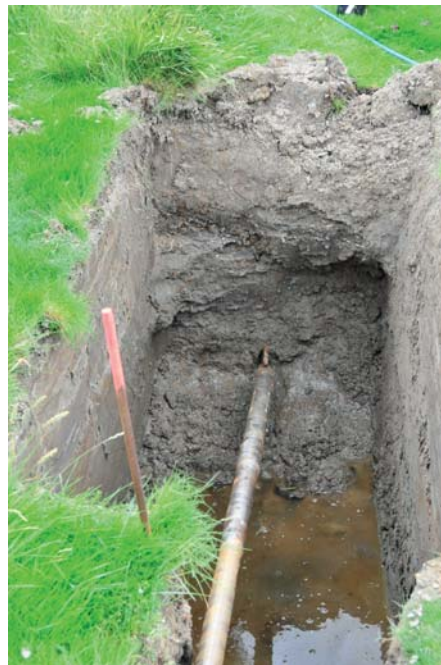
Die Pilotbohrung mit Bohrkopf , à la Paasch' durch den fruchtbaren Marschboden. Die wertvolle Grasnarbe muss später wieder eingesetzt werden.
