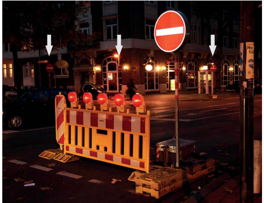
Auch bei völliger Dunkelheit gut zu erkennen: innenbeleuchtete LED-Verkehrszeichen. Die Pfeile deuten auf herkömmliche unbeleuchtete Verkehrszeichen. (Fotos: BAS)
