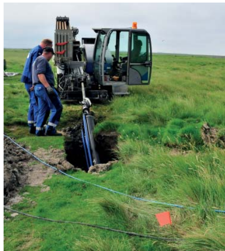
Das Kabelschutzrohr DA 225 mm wird zusammen mit drei kleinen Leerrohre für die Verspressung eingezogen.
