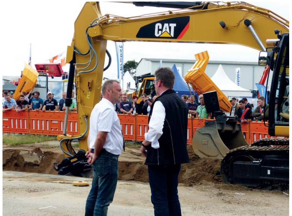
Als enger Partner wird der VDBUM auf der TiefbauLive die „Musterbaustelle“ mit Maschinenvorführungen im Straßen-, Kanal- und Spezialtiefbau betreuen. (Foto: VDBUM)
