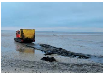
Bei Ebbe früh am Morgen bringt der Ponton-Bagger den Verbaurahmen für die Zielgrube durchs Watt.
