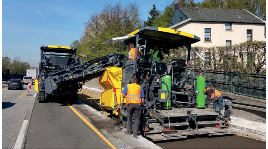
Um die Leistung zu erhöhen und die Wechselzeiten der Lkw zu verkürzen, fuhr der Beschicker auf der rechten Fahrspur und versorgte von dort den Fertiger auf dem tiefer gelegenen Seitenstreifen. (Fotos: Dynapac)
