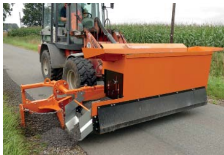
Finliner im Bankettbau: Das seitlich montierte Bankettschild sorgt für gleichmäßiges Einbauniveau.
