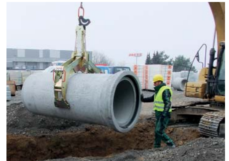
Der Rohrgreifer RG-75/125-Safelock behält dank Sicherheitsverriegelung seine volle Klemmkraft selbst bei Fehlbedienung.
