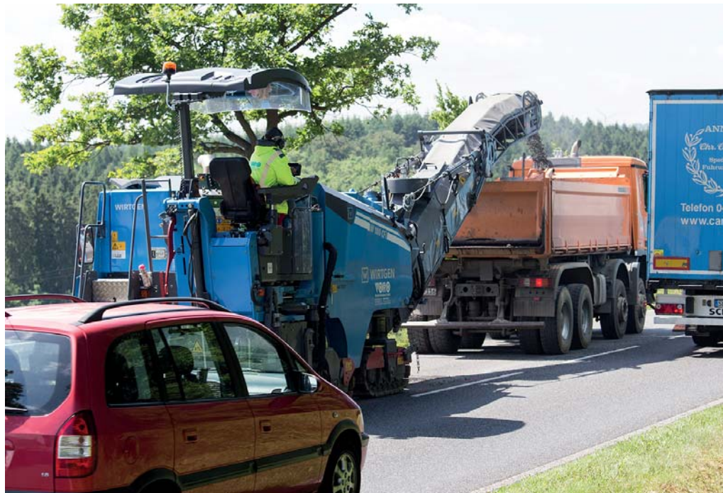
Auch bei fließendem Verkehr ist es für die Wirtgen W 100 CFi kein Problem, die Baustelle sicher abzuwickeln. Hier hilft auch das deutlich schmalere Chassis, welches dem Fahrer unter anderem eine optimale Sicht auf die Fräskante ermöglicht. (Fotos: Wirtgen)
