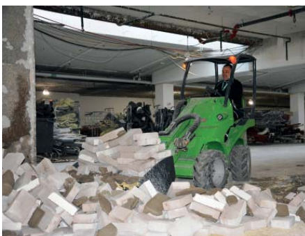
Typischer Einsatz: der Elektrolader beim Einsatz in der Gebäudesanierung.
