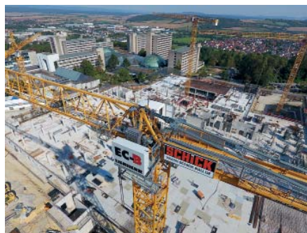
Bei diesen EC-B-Kranen integriert der Kompaktkopf das Hubwerk, das Drehwerk, die zentrale Schaltanlage und die komplette Kugeldrehkranz-Auflage.
