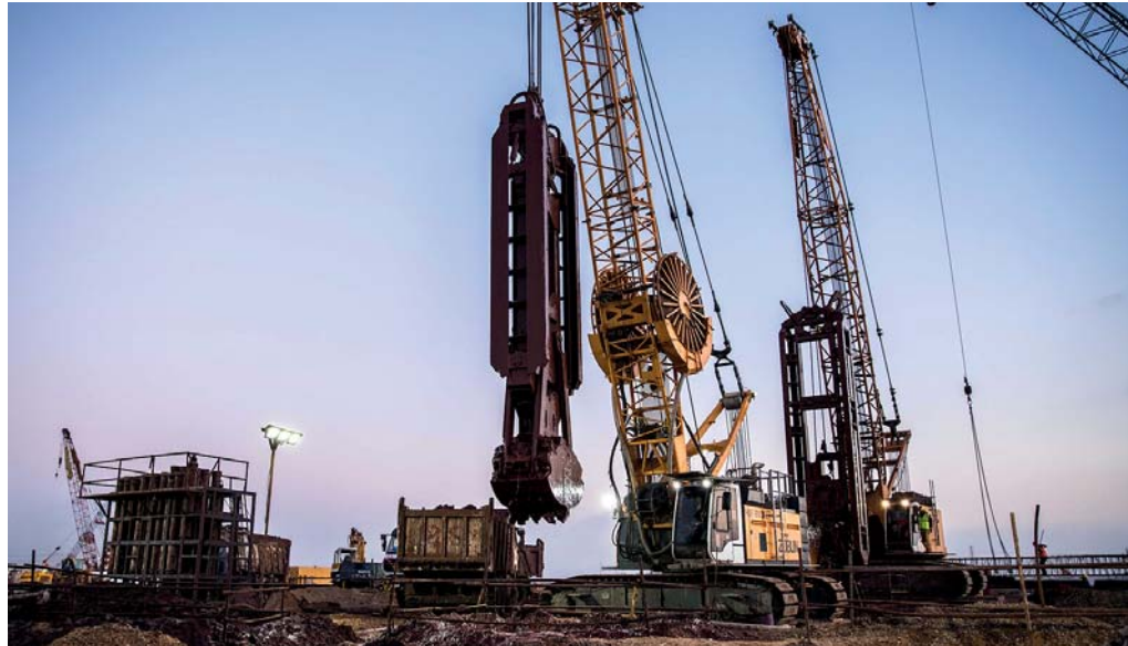
Der HS 8100 HD ist aktuell einer von zehn Seilbaggern und Raupenkranen von Liebherr am Suezkanal. (Fotos: Liebherr)
