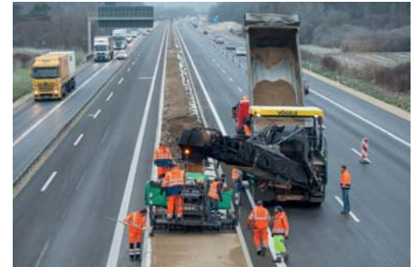
Kontinuierliches Verfüllen bei fließendem Verkehr: Der Einsatz des Beschickers MT 3000-2i Offset macht es dank seines Schwenkbands möglich.
