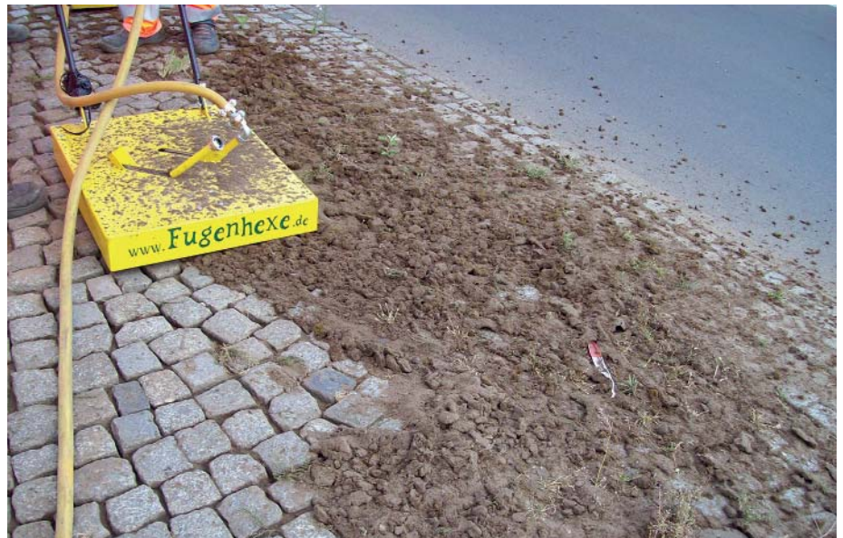
Mit der Fugenhexe wird Fugenmaterial kontrolliert ausgeblasen, um anschließend mit modernem Pflastermörtel oder anderem Material die Sanierung durchzuführen. (Fotos: Optimas)
