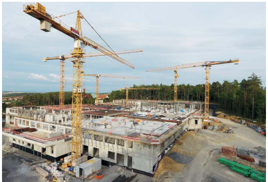
Aktuell sind sechs Liebherr-Obendreher auf der Großbaustelle in Bad Neustadt im Einsatz. (Fotos: Liebherr)
