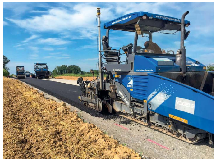
Nach dem Einbau der Deckschicht folgt gleich die Walze zur fachgerechten Verdichtung.
