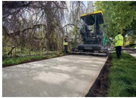
Mit seiner Einbaubreite bis 5,00 m meistert der Super 1300-3i die Anforderungen des größten Bauloses.
