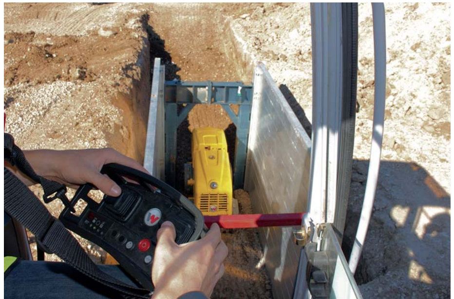
Mit Infrarot-Fernsteuerung: Der Bediener der Grabenwalze muss während des Verdichtungsprozesses nicht im Graben stehen. (Foto: Wacker Neuson)
