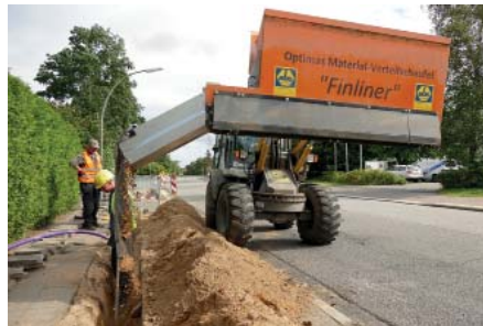
Mit der Anbauschaufel „Finliner“ lässt sich im Straßen- und Leitungsbau Sand, Splitt, Schotter oder Mutterboden gleichmäßig über ein Förderband verteilen. (Foto: Optimas)
