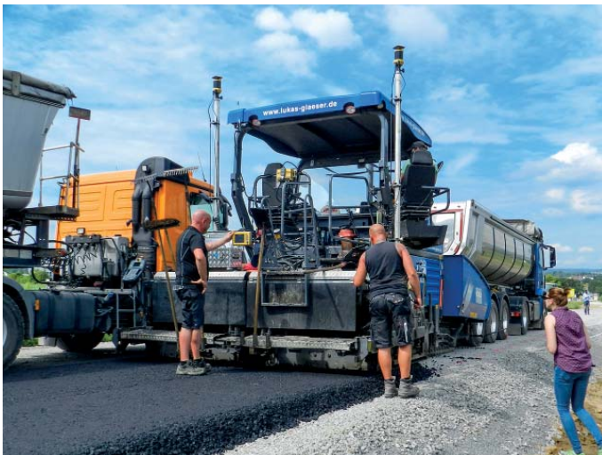
Die Bedienmannschaft prüft den Verlauf des Einbaus am Topcon-Display.
