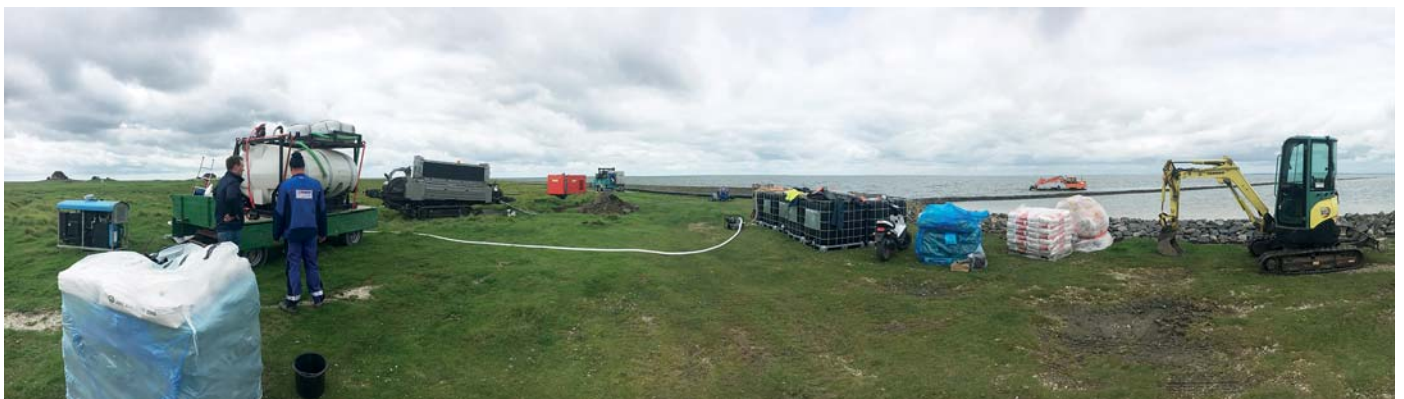
Gesamtaufbau der Baustelle hinter dem Deich mit mobiler Mischanlage, Grundodrill 15, Generator, mobiler Recyclinganlage AMC SRU 500 und Misch tanks. Im Watt steht der Ponton-Bagger bereit.
