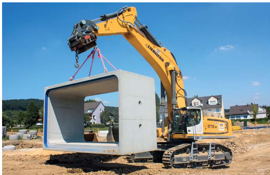
Der Raupenbagger mit 90 t Einsatzgewicht und einer Leistung von 400 kW / 544 PS wurde zur Verlegung von über 30 t schweren Leitungsblöcken eingesetzt. (Foto: Liebherr)
