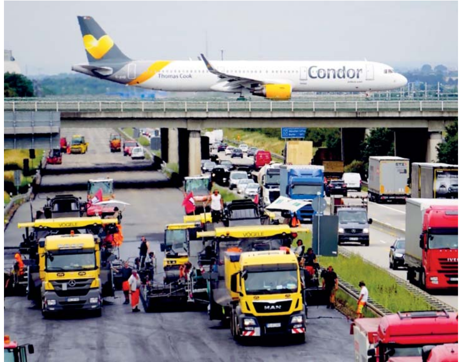
70.000 t Asphalt einbau wurden auf der A 14 am Flughafen Leipzig mit BPO geplant und in Echtzeit gesteuert. Hierbei waren 50 Lkw im 24-Stunden-Schichtbetrieb im Einsatz. (Fotos: Volz Consulting)
