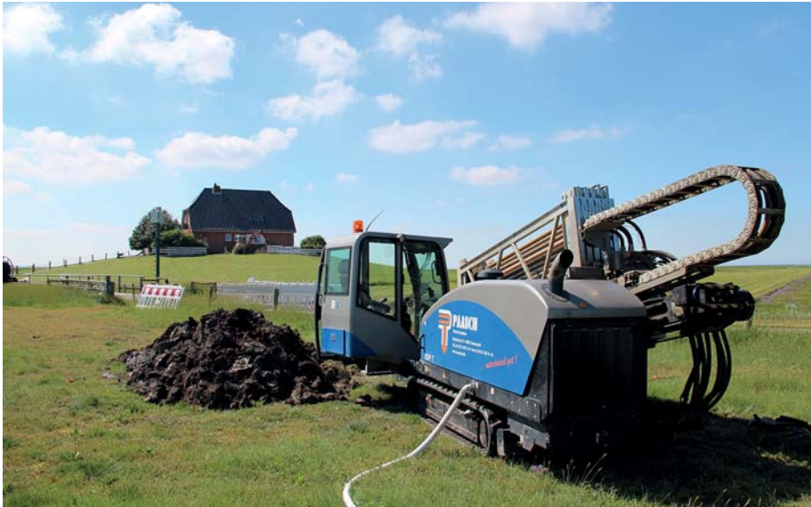
Die erste Etappe ist geschafft, das Schutzrohr für die Anlandung des Seekabels ist gelegt.
