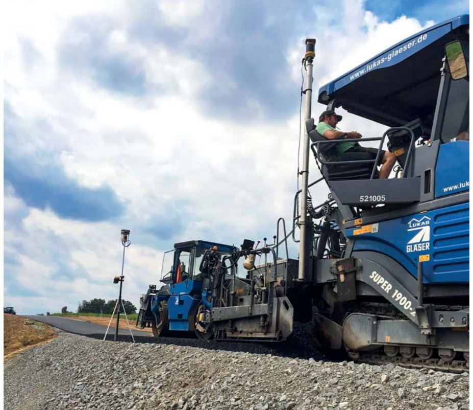
Zunächst wurde die zu bearbeitende Strecke präzise vermessen. Die kundeneigene Topcon-Basisstation sorgte für das benötigte Referenzsignal. (Fotos: Topcon)
