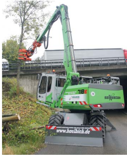
Teleskopausleger mit 15 m Reichweite: Die Mobilmaschine mit Westtech Woodcracker Schneidkopf eignet sich ideal für die Böschungspflege entlang der Autobahn. (Foto: Sennebogen)
