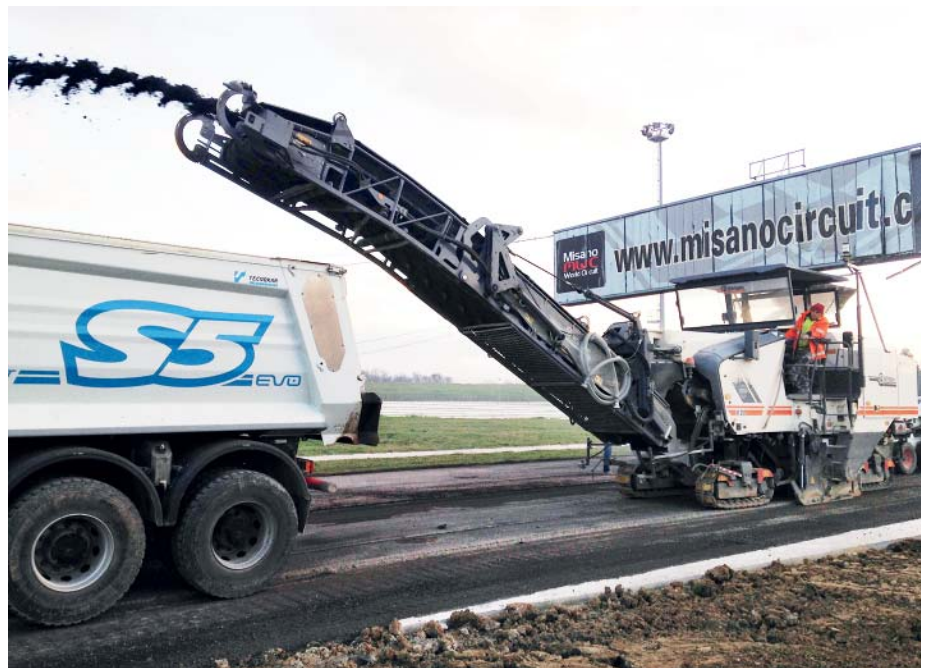
Die Wirtgen-Kaltfräse W 210 ist mit einer Schnittstelle für 3D-Systeme ausgestattet. Bei diesem Einsatz kam das Trimble PCS900 System zum Einsatz. (Fotos: Trimble)
