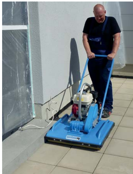
Führende Hersteller von Großformatplatten und -pflastersteinen empfehlen den Einsatz von Rollenrüttlern wie dem VPR 700. (Foto: Weber MT)
