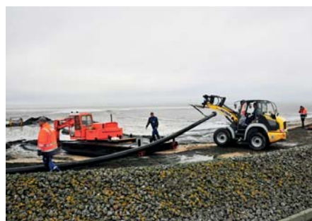
Der Rohrstrang wird vorsichtig über den Uferdamm gehoben und vom Ponton-Bagger zur Zielgrube gezogen.
