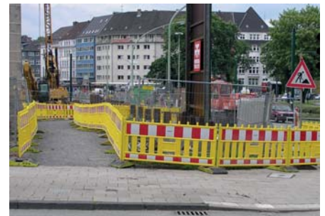
An dieser Baustelle wurde die Sicherheit durch eine bis zum Boden reichende, geschlossene Einhausung und Absperrzäune in gut erkennbarer Signalfarbe deutlich erhöht.
