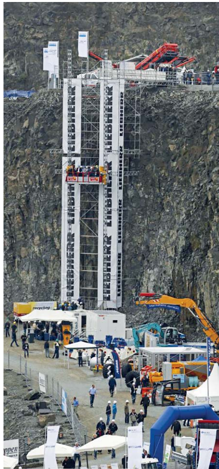
Erlebnis der besonderen Art: Zwischen Sohle B und C sowie zwischen Sohle C und D werden 30 m hohe Aufzüge die Laufwege verkürzen.
