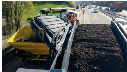
Mit seinem außerordentlich leistungsfähigen Fördersystem erreichte der MF2500 bei seinem ersten praktischen Einsatz eine Tagesleistung zwischen 2.500 und 3.000 t.
