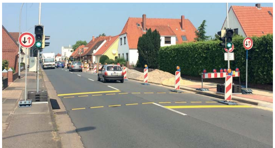
Fachgerechte Verkehrssicherung einer Straßenbaustelle mit Leitbaken und Lichtsignalanlage. (Foto: BVT)
