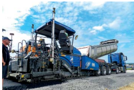
Der Lkw versorgt den Fertiger mit perfekt temperiertem Heißasphalt.
