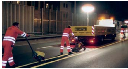
Durch beleuchtete Nachtbaustellen wird die Baustellenzeit verkürzt.
