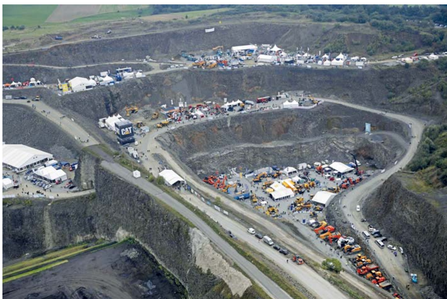
Außergewöhnliches Messegelände: Der Basalt-Steinbruch des Unternehmens Mitteldeutsche Hartstein-Industrie in Nieder-Ofleiden ist der größte seiner Art in Europa.
